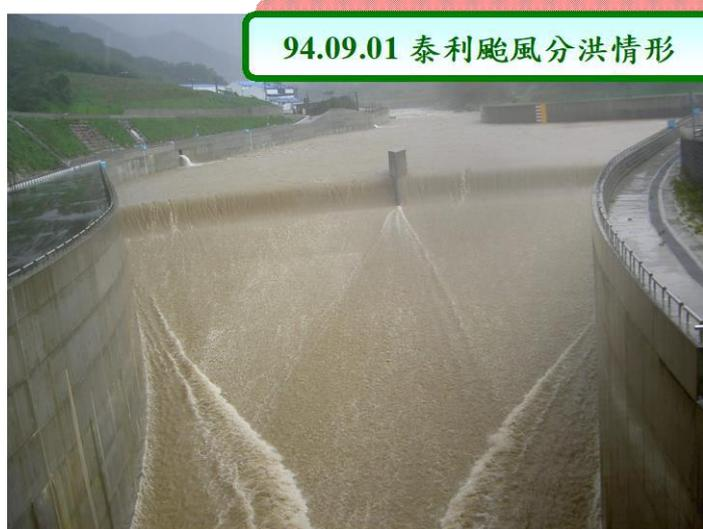
本計畫自 93 年隧道襯砌未完成前，即已進行應急分洪，適時降低下游水位，94 年起每年汛期颱風時均能正常發揮分洪減災功效，截至 97 年 10 月底止，累計完成分洪 15 次，總分洪體積概估約達 7507 萬立方公尺，歷次分洪成果詳如表 1。
