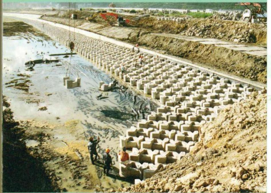
▲自然坡護岸鋪置混凝土鼎塊，可耐水流沖刷。
