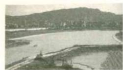
許低水河槽橫向變形，故決定低水河槽兩側，應採用固定式護岸。由於低水河槽已無橫移的可能，而且高灘地表面亦略具防淘能力，故本堤防的護腳工僅須適宜的寬度，即可達到保護堤防的安全標準。
