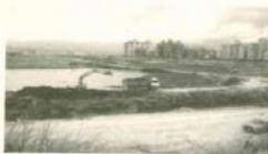
低水護岸封口部分，因低水護岸處受水流淘刷，有長期邊坡穩定的問題，地盤改良採用排水砂樁工地，一方面可加速沈陷，另可增加土層抗剪強度。現有排水砂樁的施工能力，僅達二十五公尺，無法完全貫穿粘土層，剩餘沈陷量較大。低水護岸施工時，需加高預留沈陷厚度，並採用對沈陷抵抗力較大的柔性結構物。排水砂樁要求和布置，在剩餘沈陷量方面，填土完畢後，低水護岸施工前為小於二十公分；砂樁樁徑為四十點零公分；砂樁間距為二點五公分；打設深度為二十五點零公尺。
