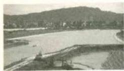
坡度方面，為顧及低水護岸的親水性，特於標高E1.2.0處，保持六公尺寬的親步道。上、下方護岸的坡度研定，採用 Bishop 圓弧切片分析法，以 STABL5 程式。垂直比水平為一比五、一比四、一比三的坡度，針對各種荷重情況，分析其安全係數。其中除了一比五的坡度在各種狀況下，安全係數均符合要求外，一比四和一比三的坡度，於地震作用或施工中，安全係數偏低。因此，最後選定一比五為自然坡護坡的坡度。
