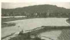
沖岸河道的坡面，則沿水流方向，每間隔三公尺，加築高度零點三公尺乘以寬度零點五公尺的縱樑一支，增加糙率<sup>②</sup>。
