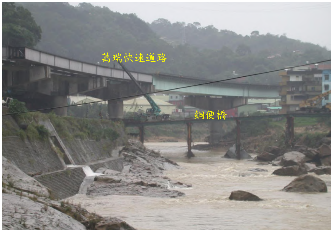
照片 4.3 萬瑞東西向快速道路橋墩及便橋
