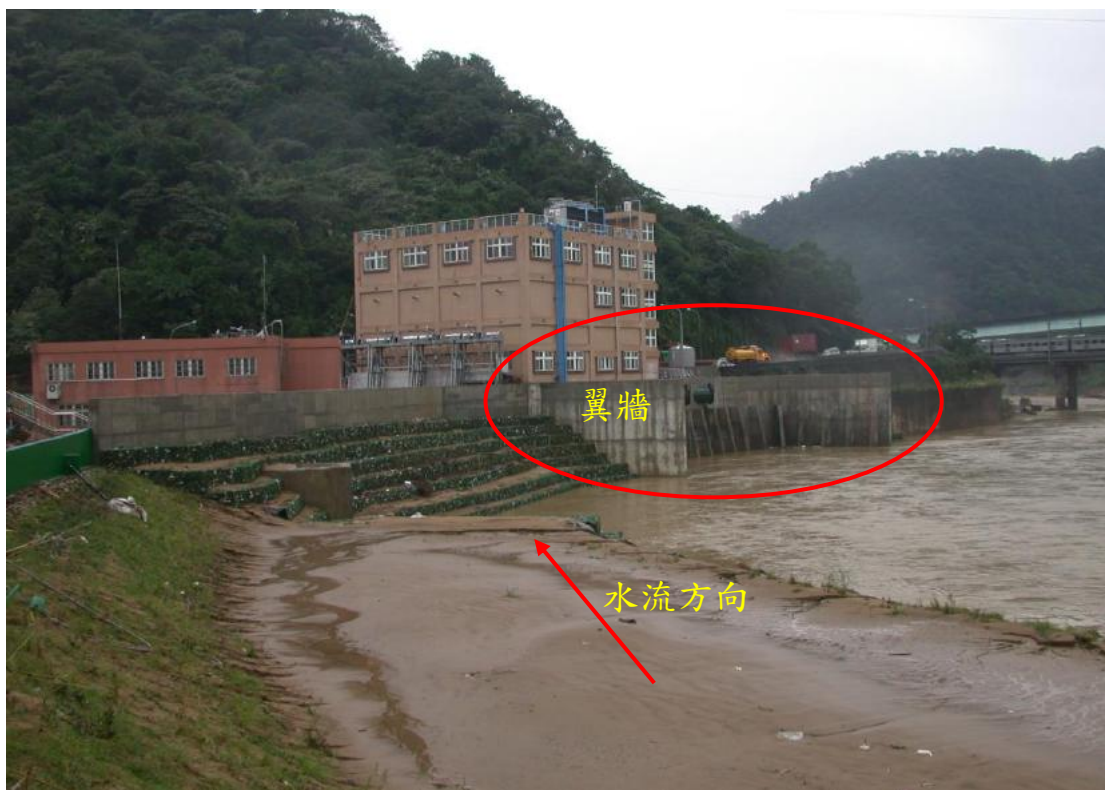
照片 4.4 碇內抽水站翼牆
