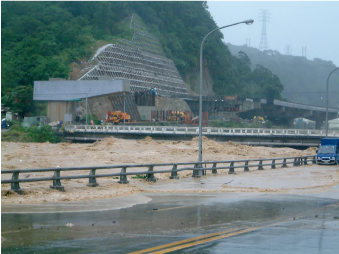
納坦颱風暖江橋上下游護岸洪水情況
