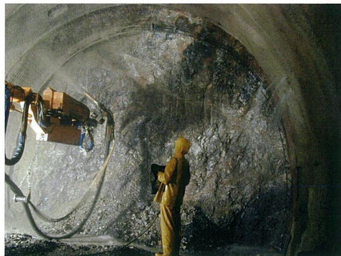
圖9.7-1 噴混凝土搭配鋼線網施作
