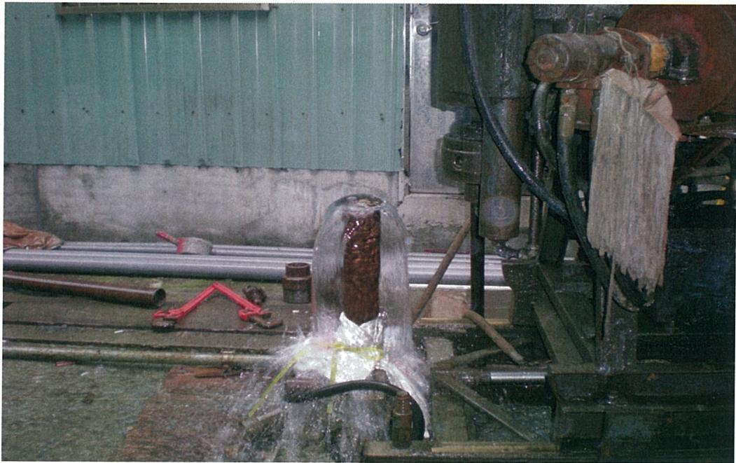
照片 2.3-5 鑽孔 DB-6 鑽遇高壓水層
