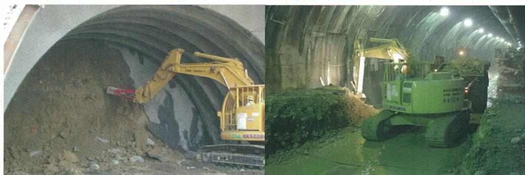
圖9.10-2 隧道機械開挖施工
