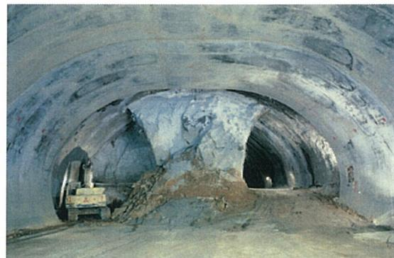
圖9.10-4 側導坑先進開挖
