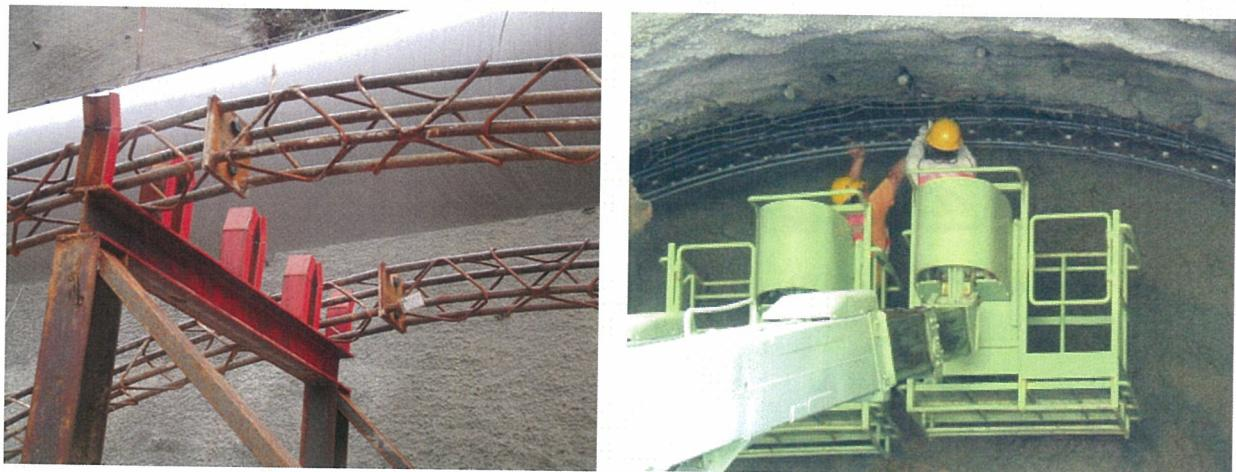
圖9.7-4 桁型鋼支保
