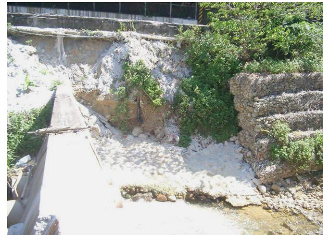
照片 4-71 青年公園旁之十八份坑溪防砂壩損壞 (94.9.29 摄，左側路堤損壞)
