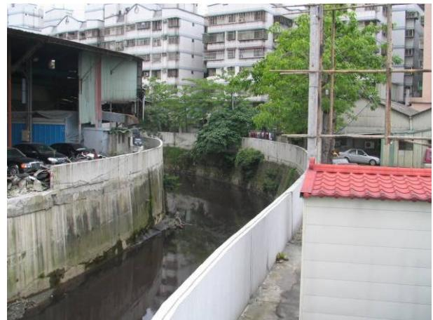
照片 4-91 潭底溝匯入塔寮坑溪之匯流口堤頂加高(94.5.19攝)
