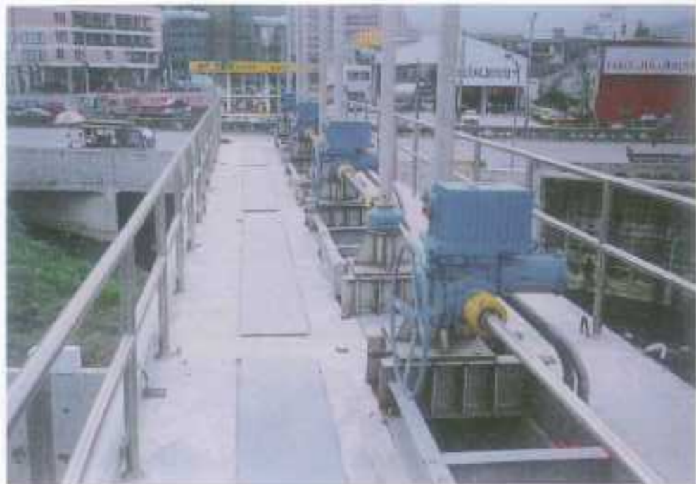
五股坑溪連繫堤防工程 (施工中)
