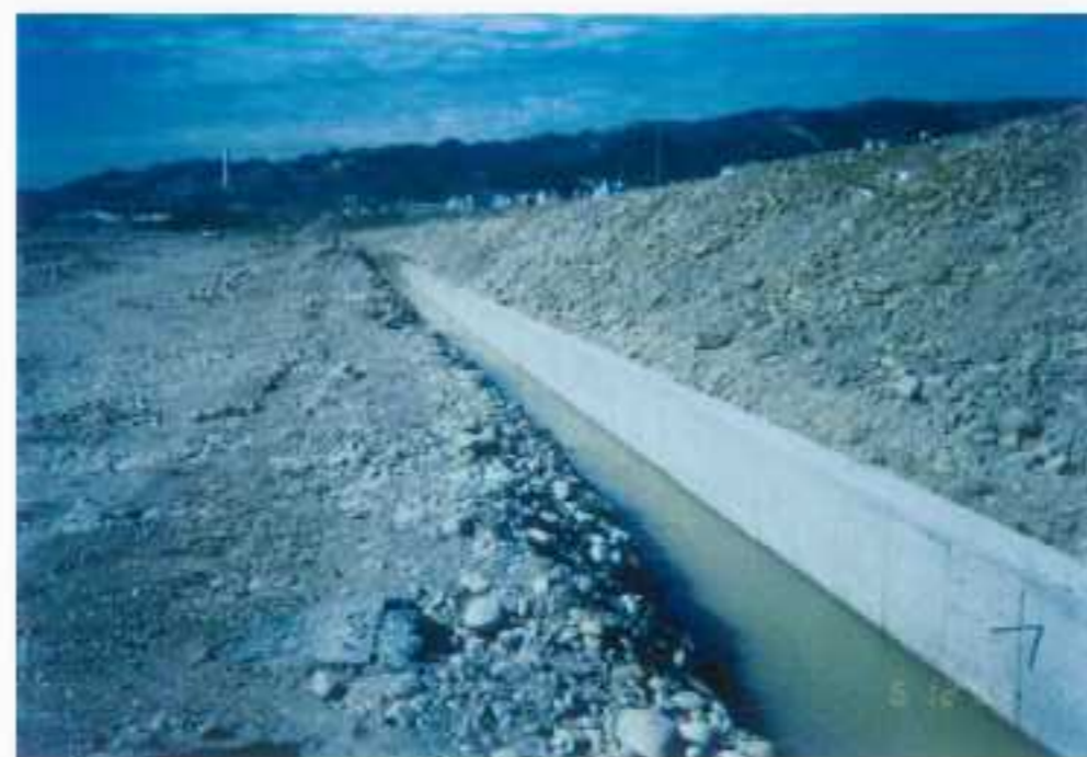
堤防工程 (基腳施工)
