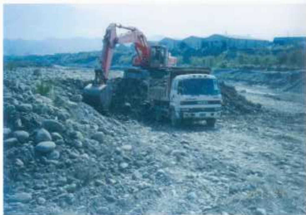
堤防工程（河道内取土）
