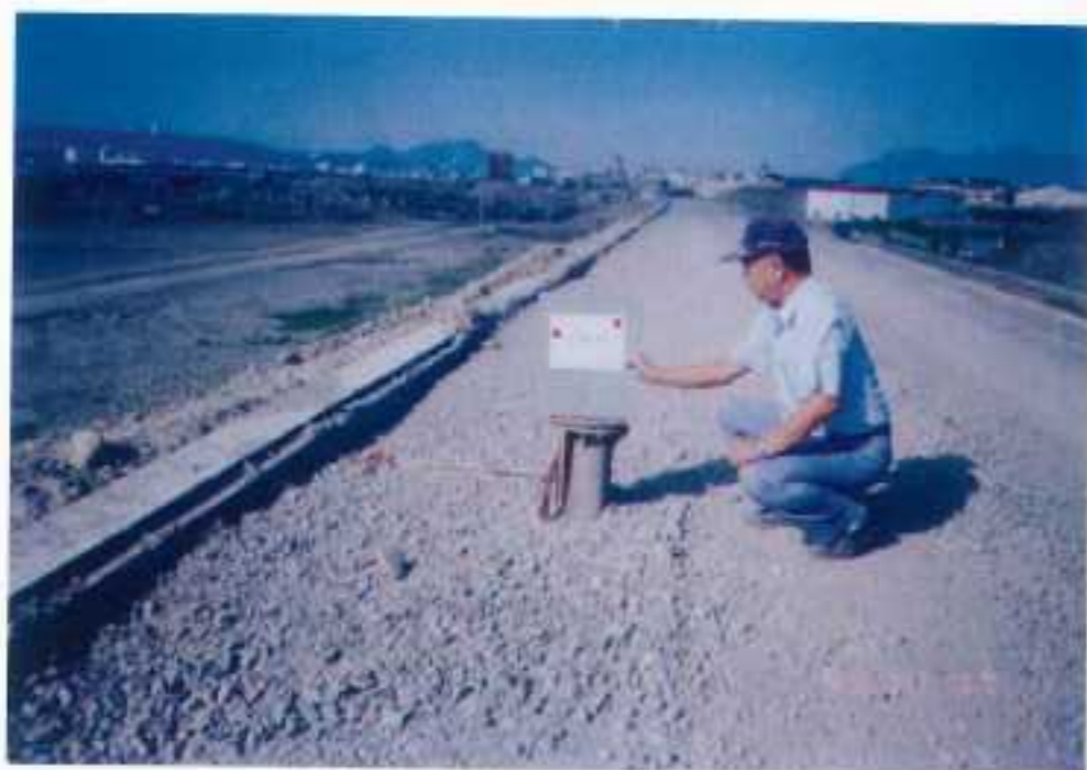
堤防工程 (沉陷板埋設)
