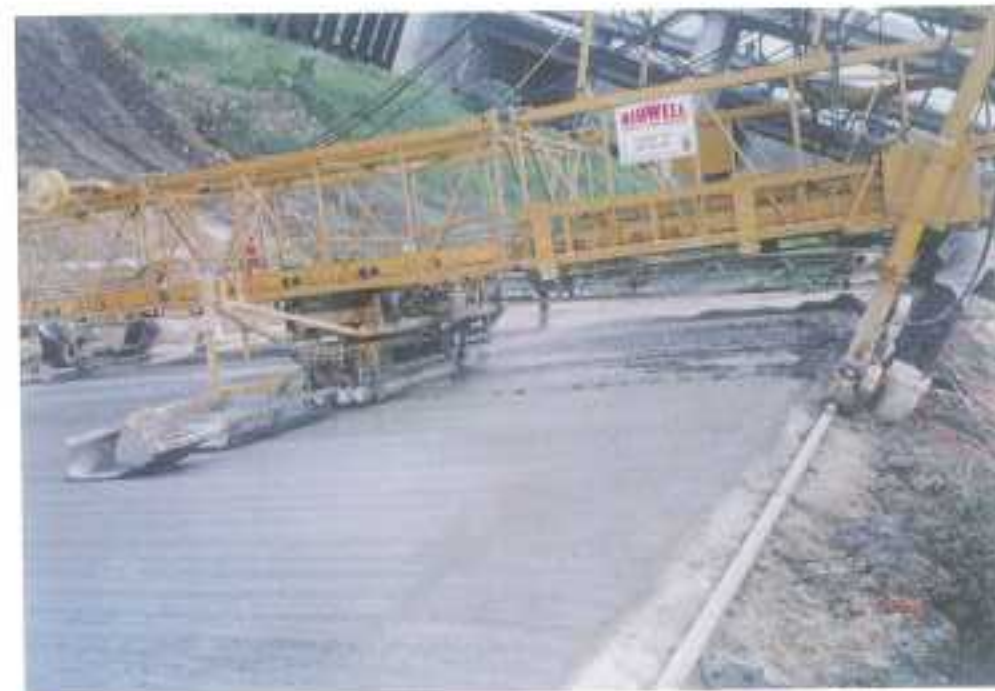
(圖九) 第二道壓實作業 (圓柱滾筒二支)
