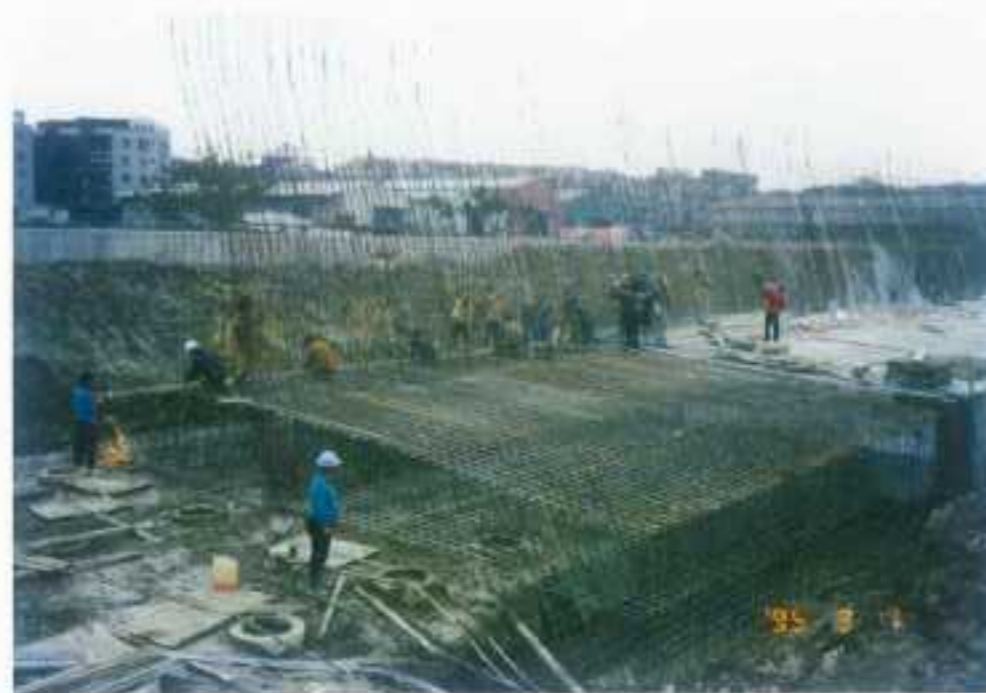
防洪工程 (防洪牆鋼筋施工)
