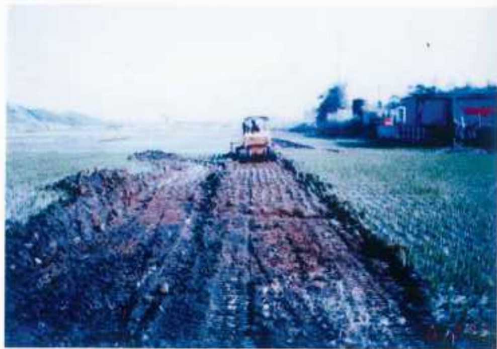
堤防工程（地表清除）
