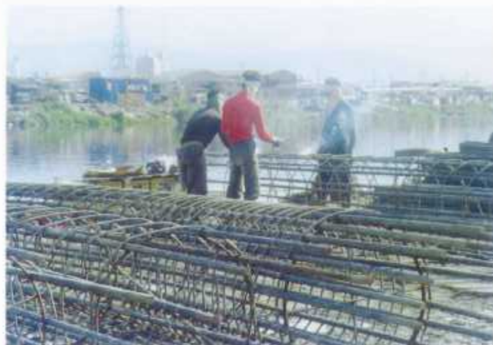
堤防工程 (反循環樁施工)
