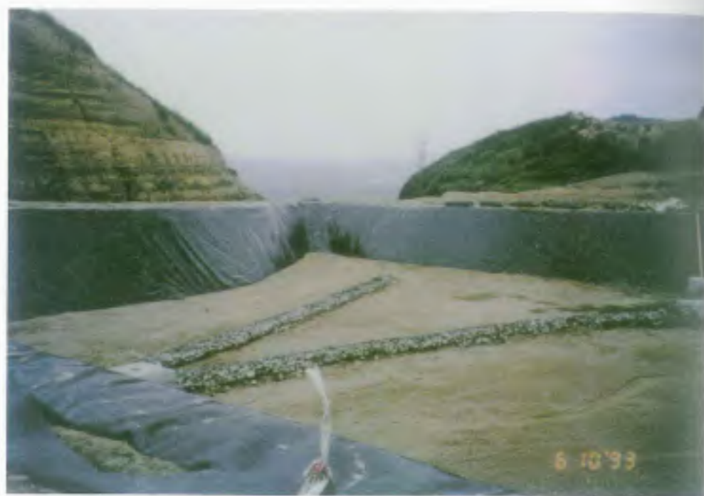
第一、二期工程腐植土堆置場(一)
