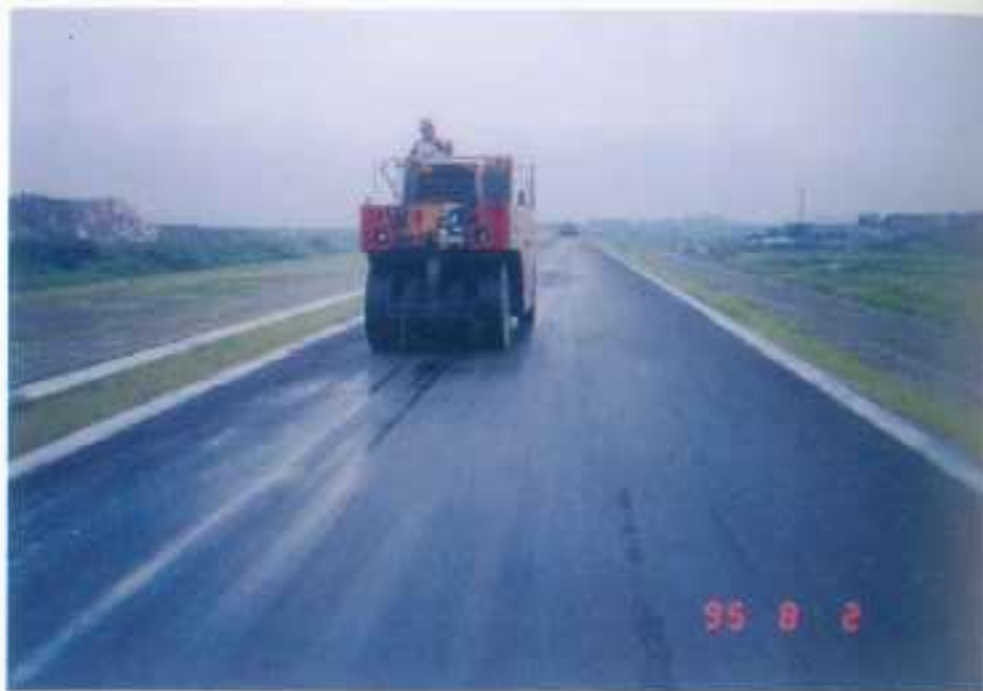
防洪工程 (瀝青施工)
