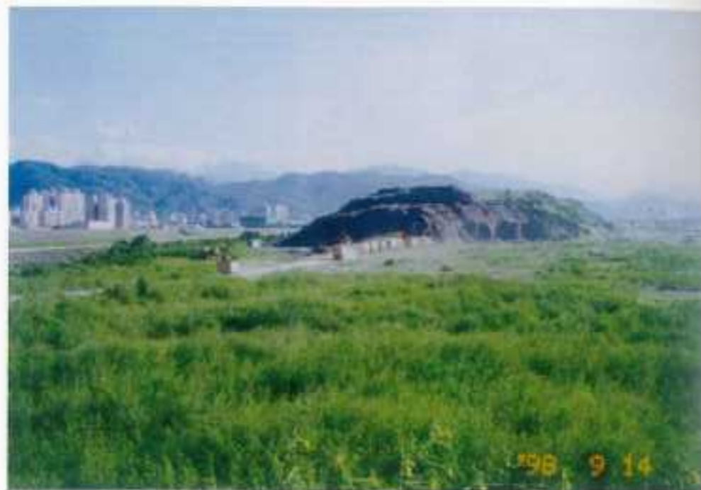
板橋市舊垃圾場清除施工
