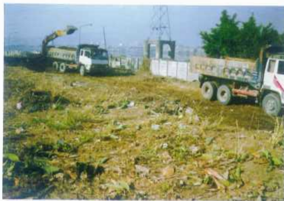
堤防工程（地表清除）
