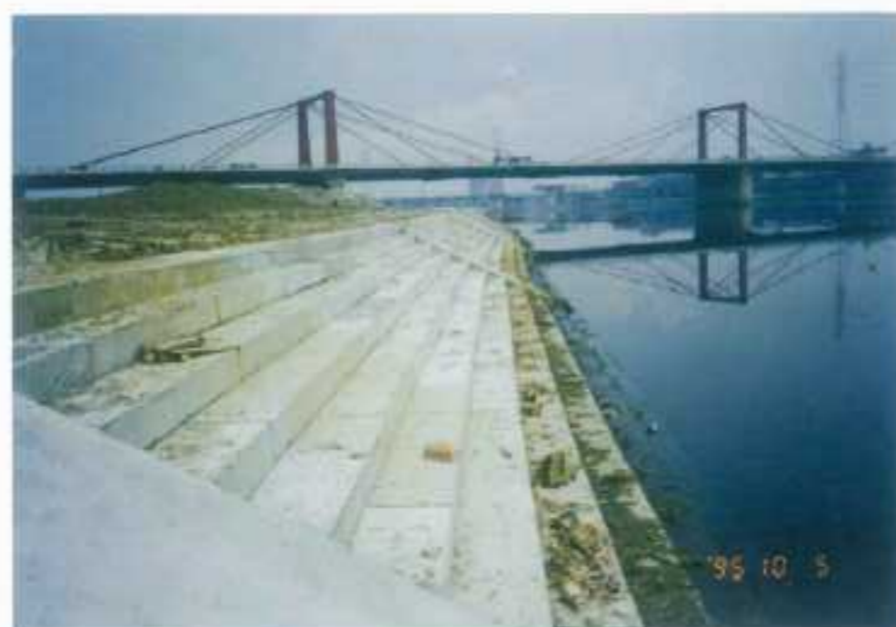
防洪工程 (階梯護岸工)
