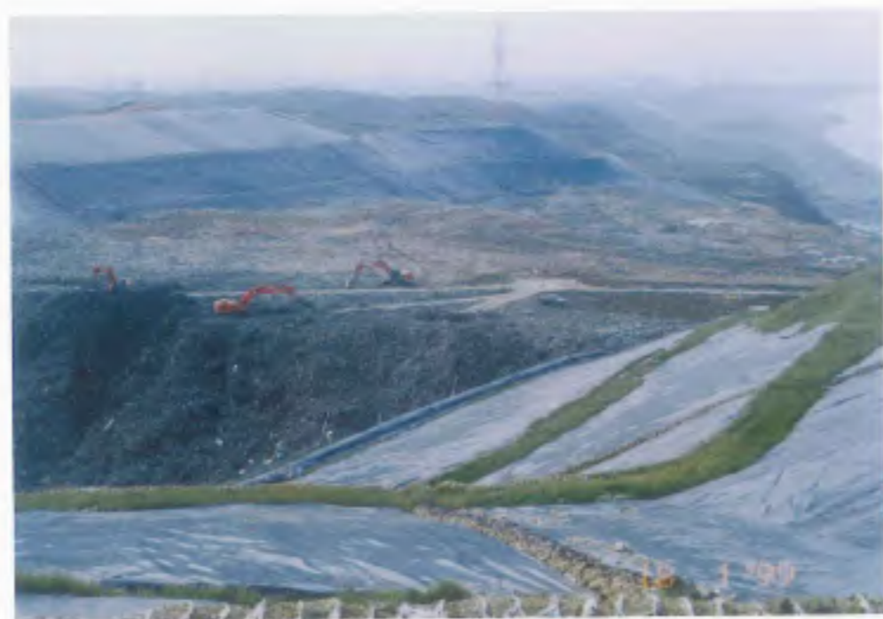
第四期堆置場清運掩埋施工
