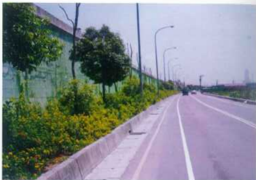
堤防工程（完工實景）
