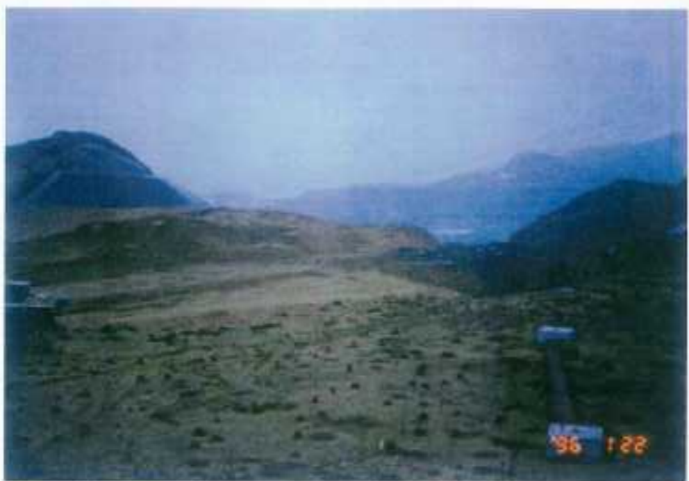
第一、二期工程腐植土清運完後覆土（二）
