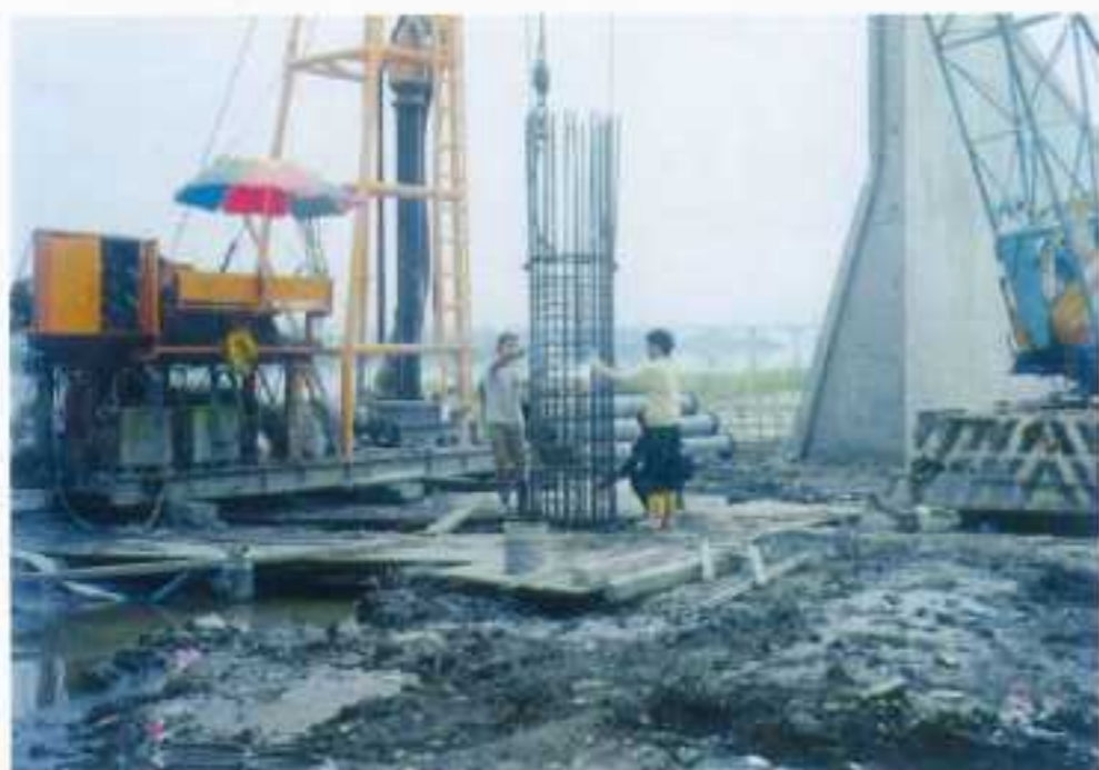
堤防工程 (反循環樁施工)
