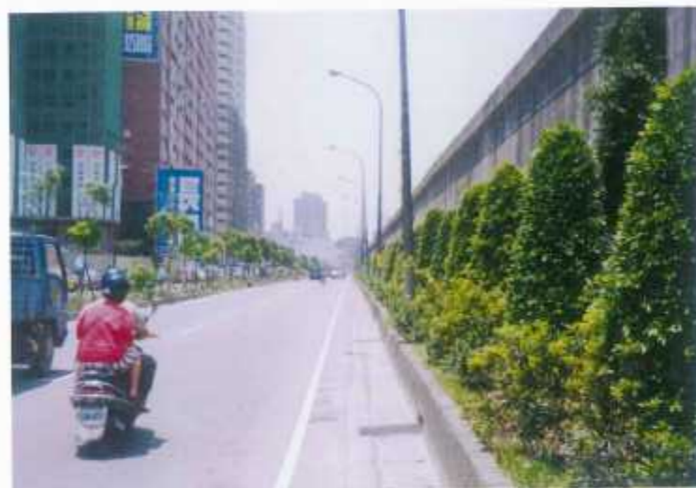
堤防工程 (完工實景)
