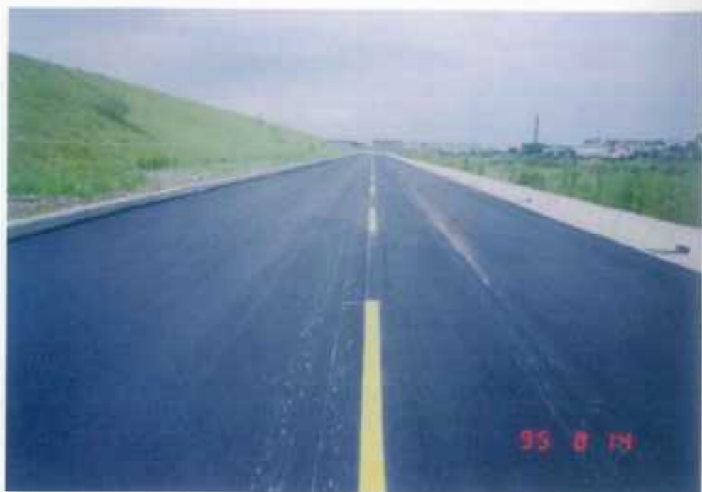
堤防工程 (完工實景)
