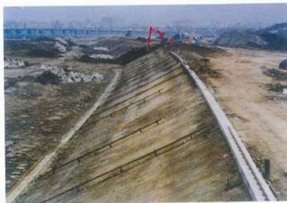
軌道及坡面整修
