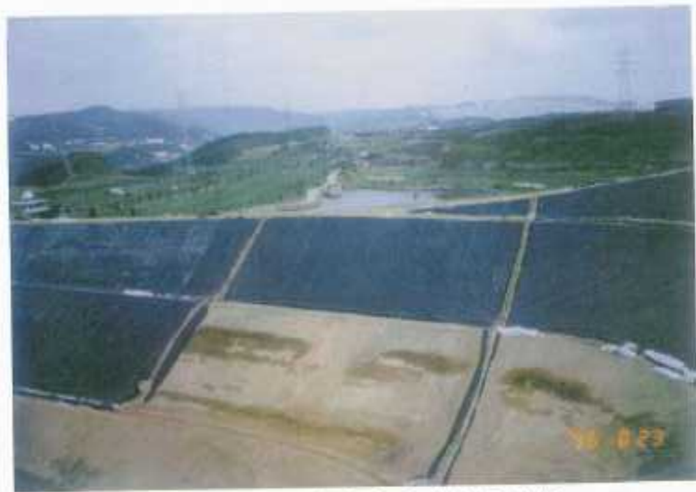
第三期工程堆置場不透水布施作
