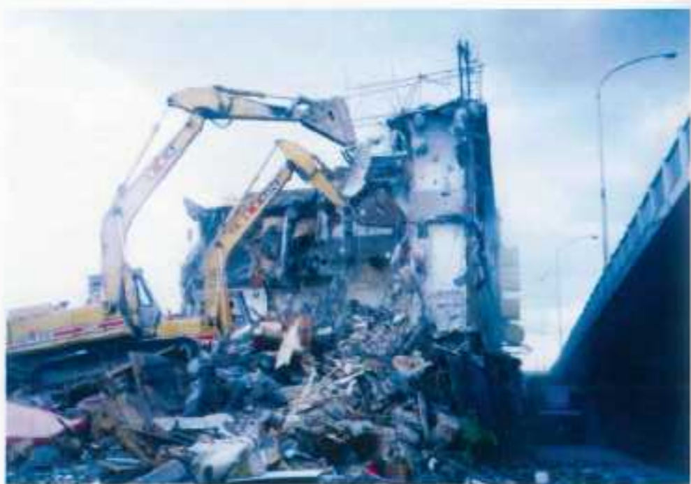
堤防工程 (建築物拆除)
