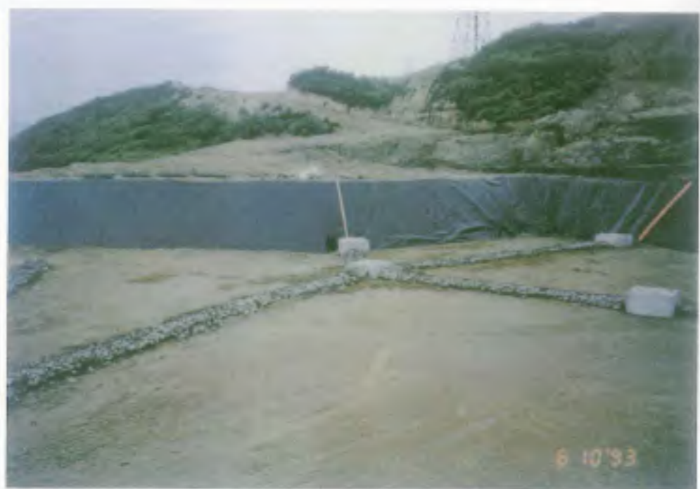
第一、二期工程腐植土堆置場(二)
