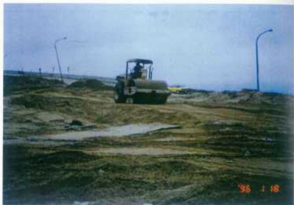
第一、二期工程腐植土清運完後覆土（一）
