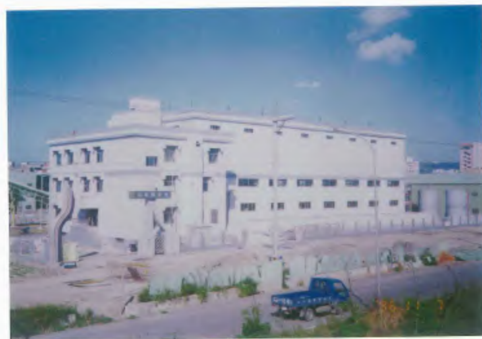
西盛抽水站 ( 完工後 )
