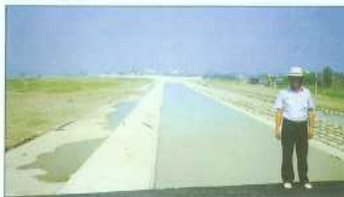
進洪道入口固定堰
