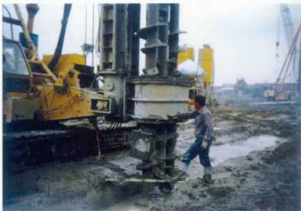
堤防工程 (S.M.W施工)
