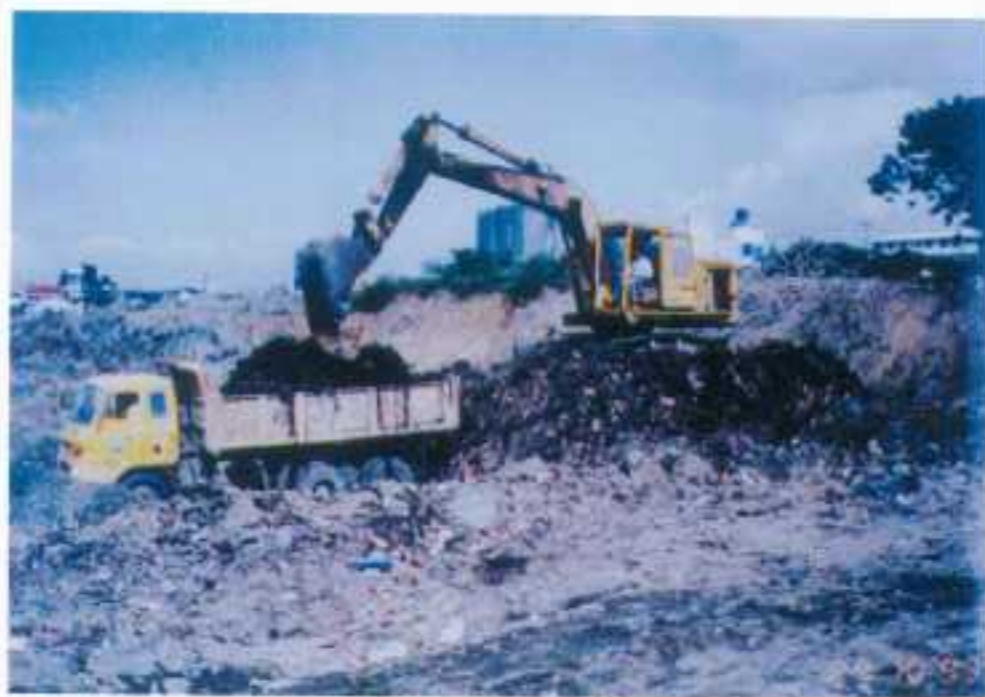
堤防工程（地表清除）
