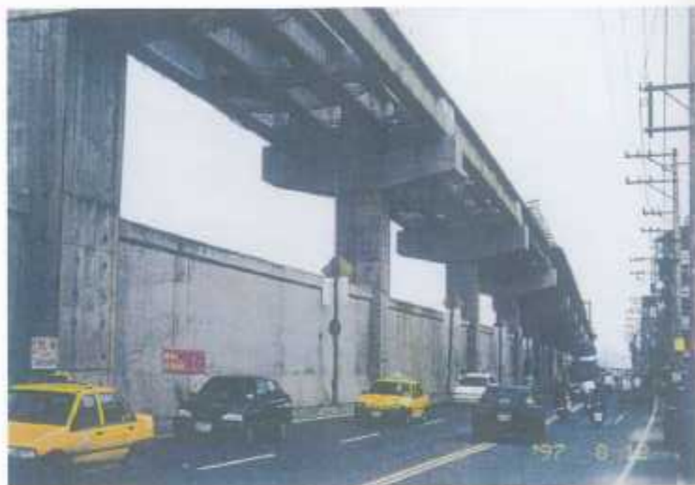
114線浮洲橋札道C與堤防共構
