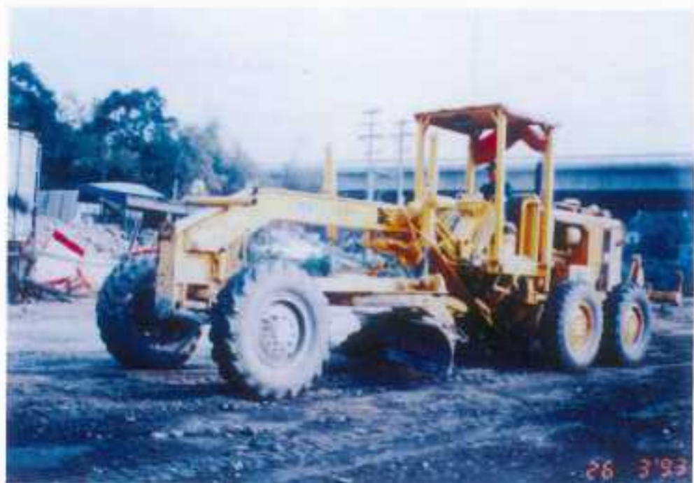
堤防工程 (填方整平作業)
