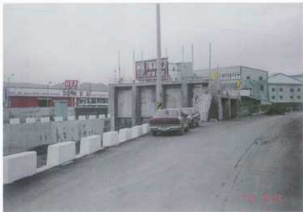
五股坑溪連繫防洪工程 (施工中)
