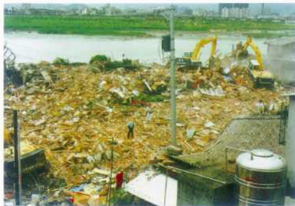
堤防工程（建築物拆除）
