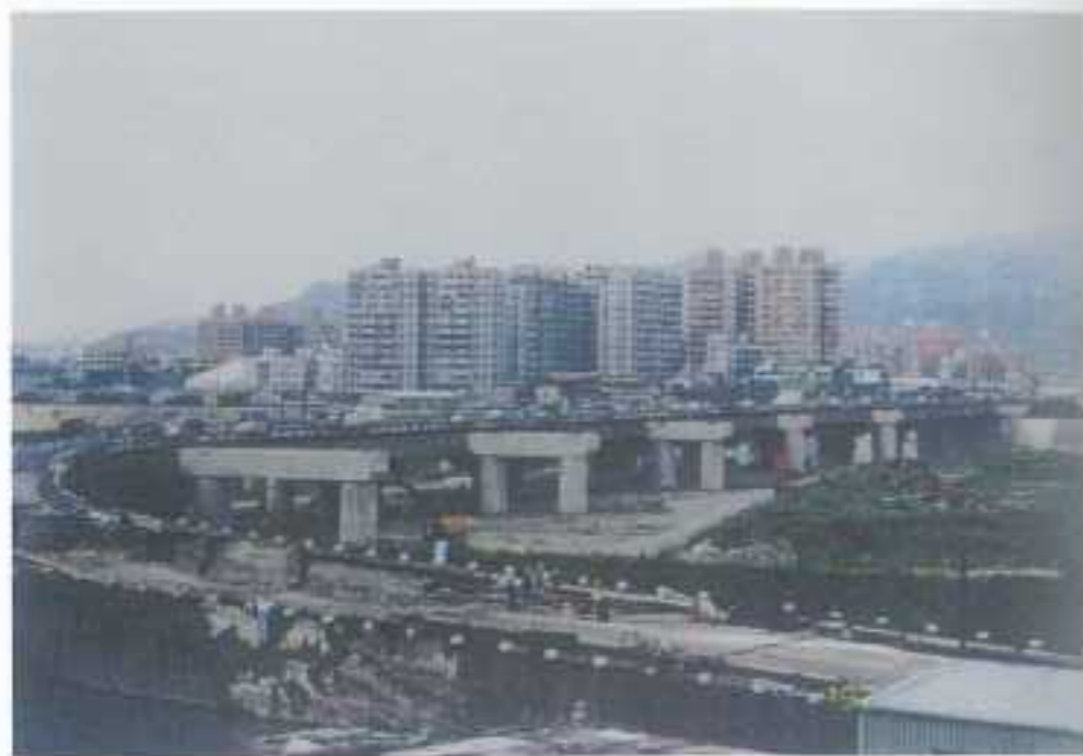
114線浮洲橋邊橋橋墩一瞥
