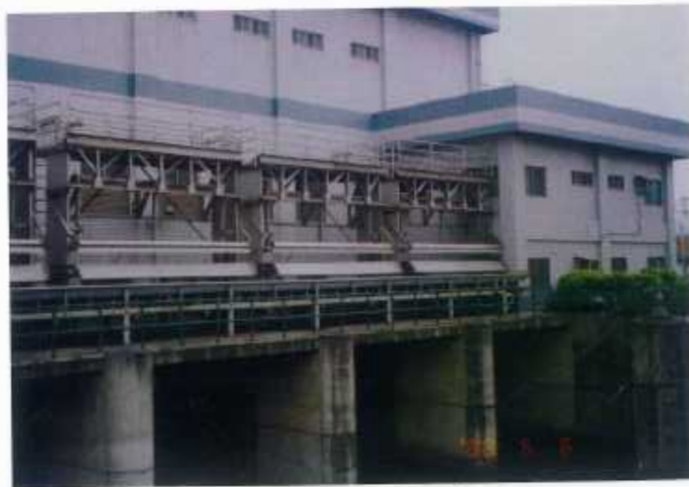
新海抽水站撈污機
