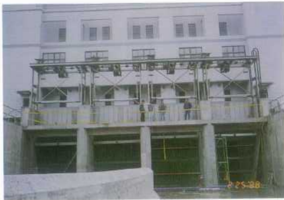
洲子洋抽水站工程 (施工中)
