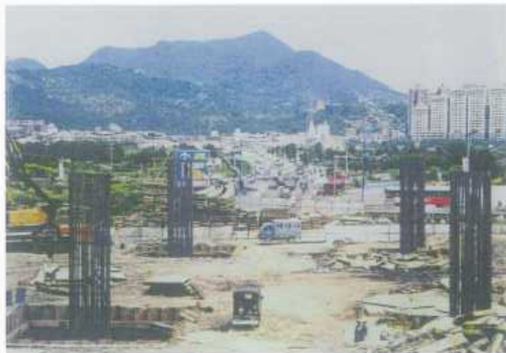
103線疏洪道橋橋墩施工
