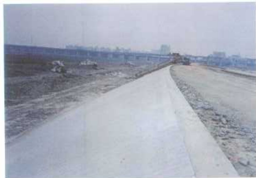
(圖十五) 完成面 (0 K +300+攝向高速公路橋)
