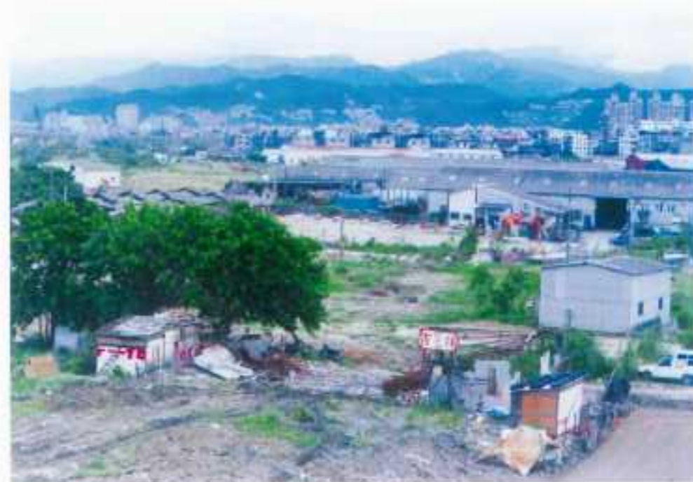
堤防工程 (施工前地貌)
