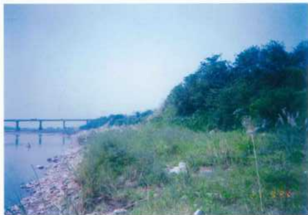
堤防工程 (施工前地貌)
