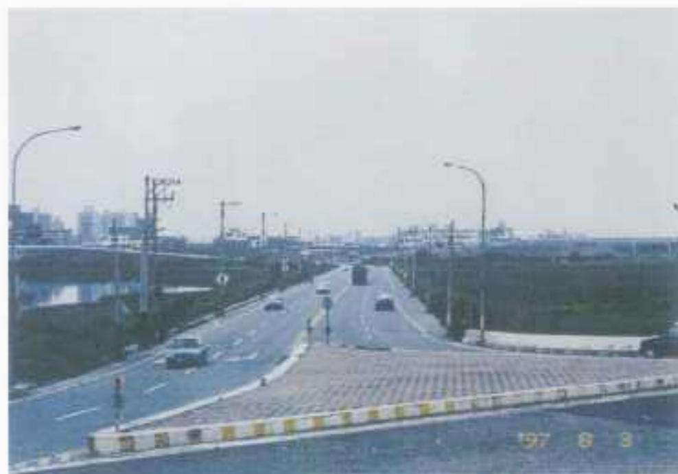
108線行經疏洪道路段現況
