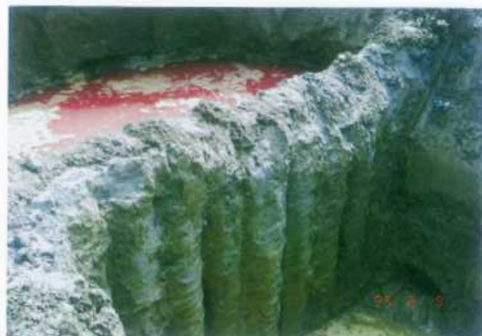
防洪工程 (S.M.W滲水測試)
