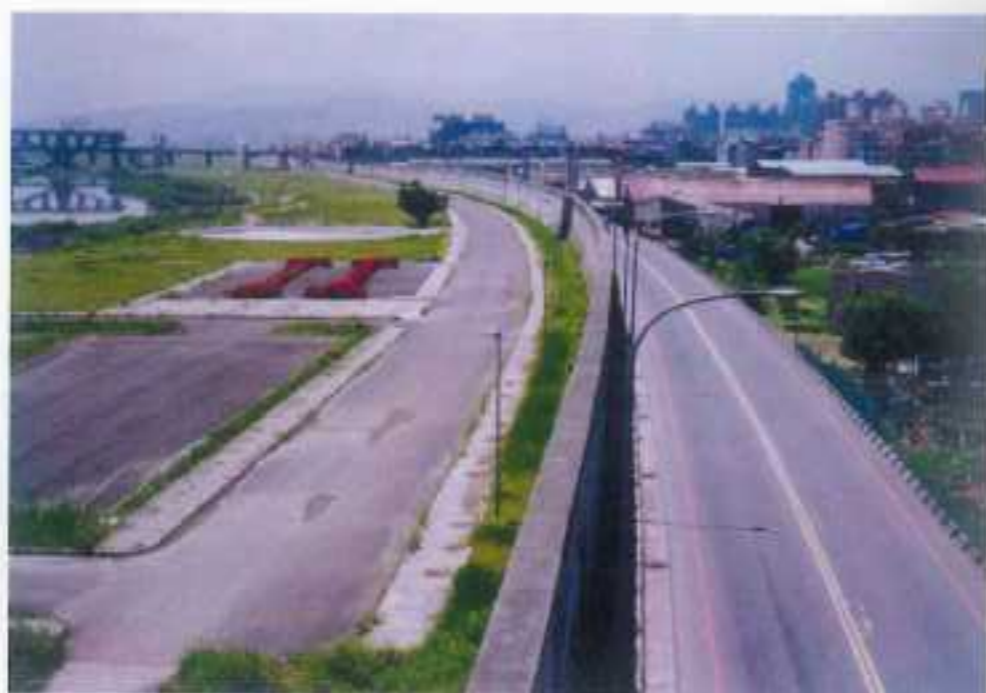
堤防工程（完工實景）
