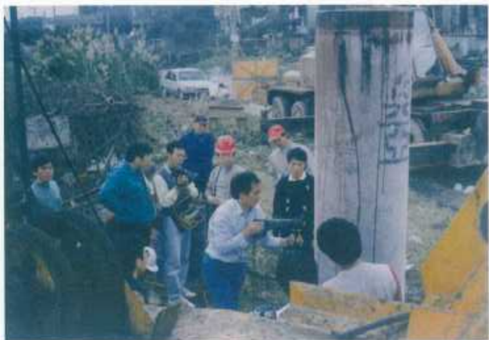
防洪工程（基樁承载力動力策試）
