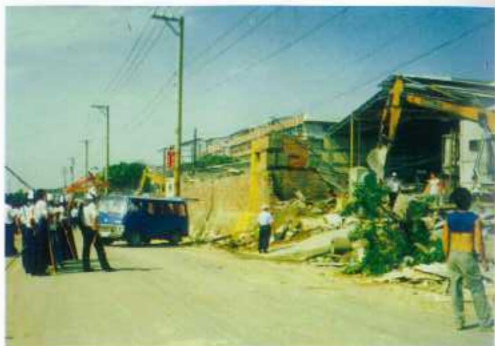
堤防工程 (建物拆除)
