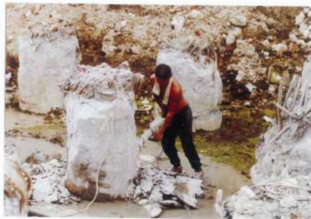
堤防工程 (反循環樁施工)
