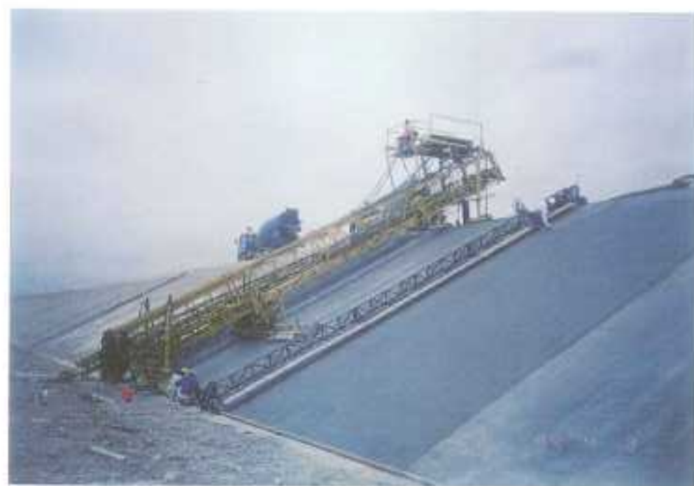
(圖十二) 修飾及養護作業
