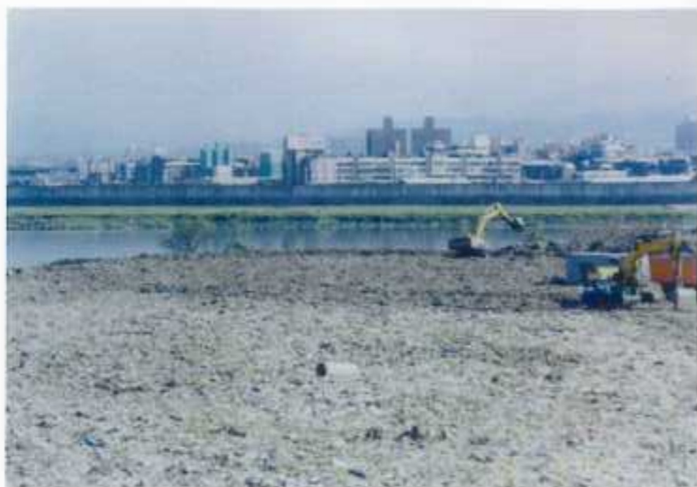
三重市舊垃圾場清除施工
