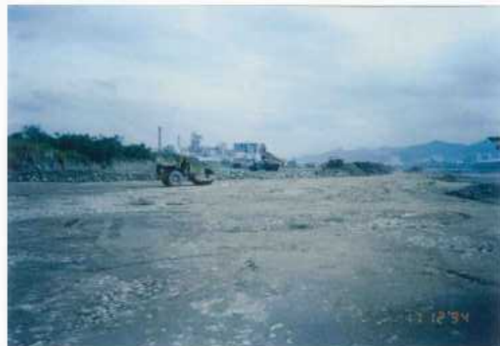
堤防工程 (土堤填方)
