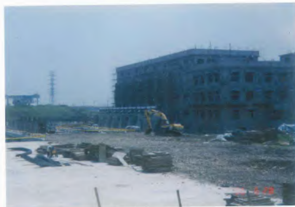
西盛抽水站 ( 施工中 )
