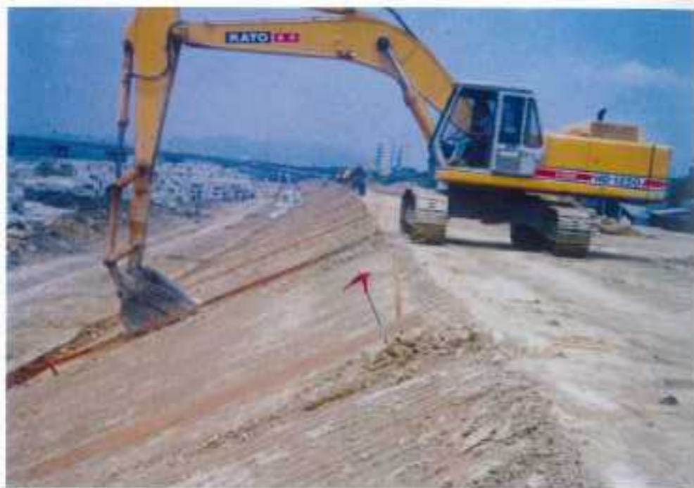
防洪工程 (坡面整修)
