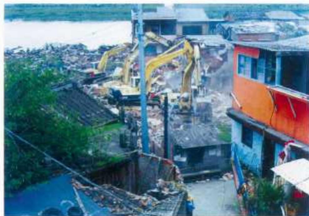
堤防工程（建築物拆除）
