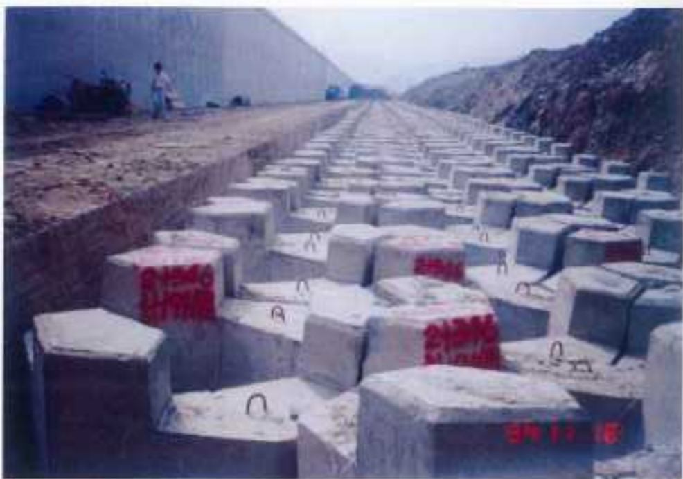
防洪工程 (堤前保護工)
