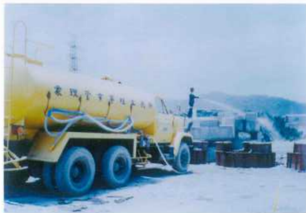
堤防工程 (混凝土保養)
