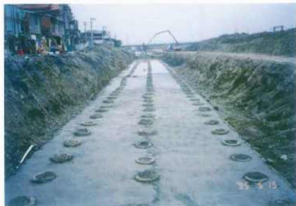
防洪工程 (基樁開挖)
