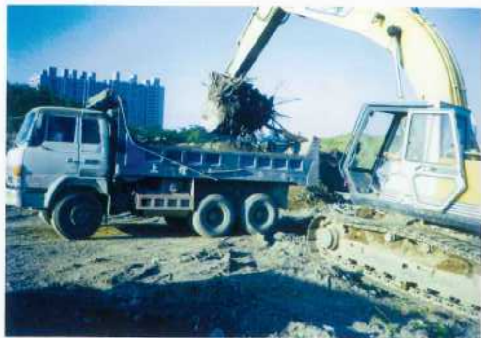
堤防工程（地表清除）
