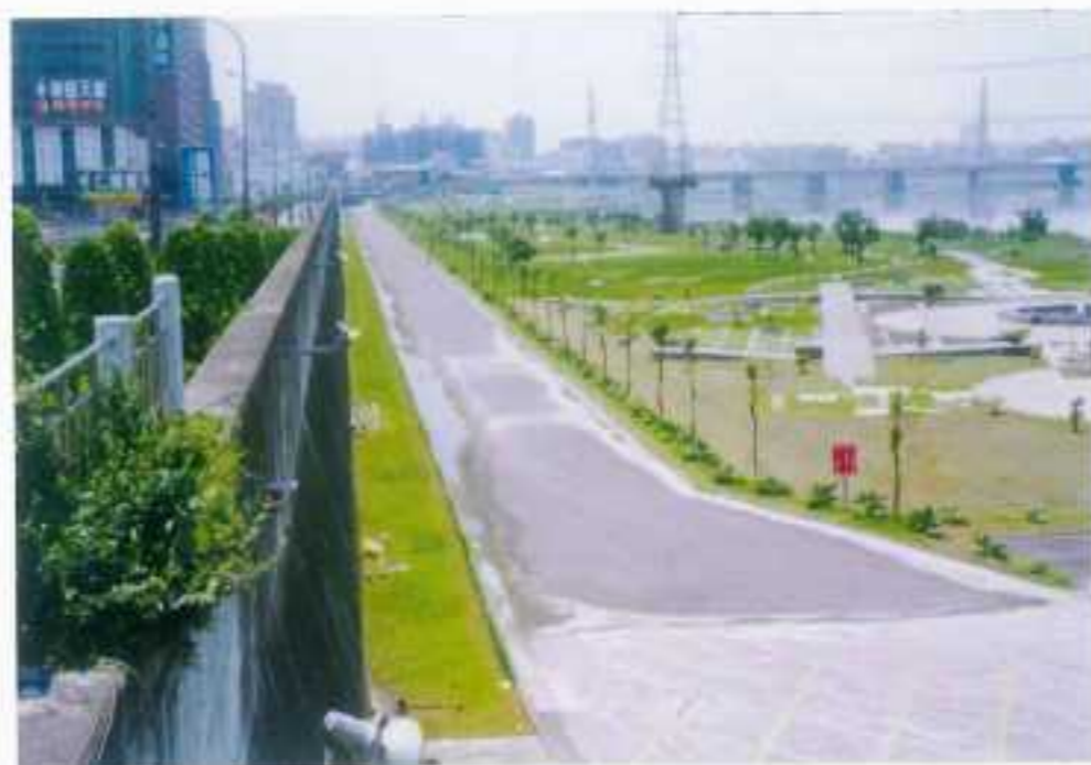
堤防工程 (完工實景)
