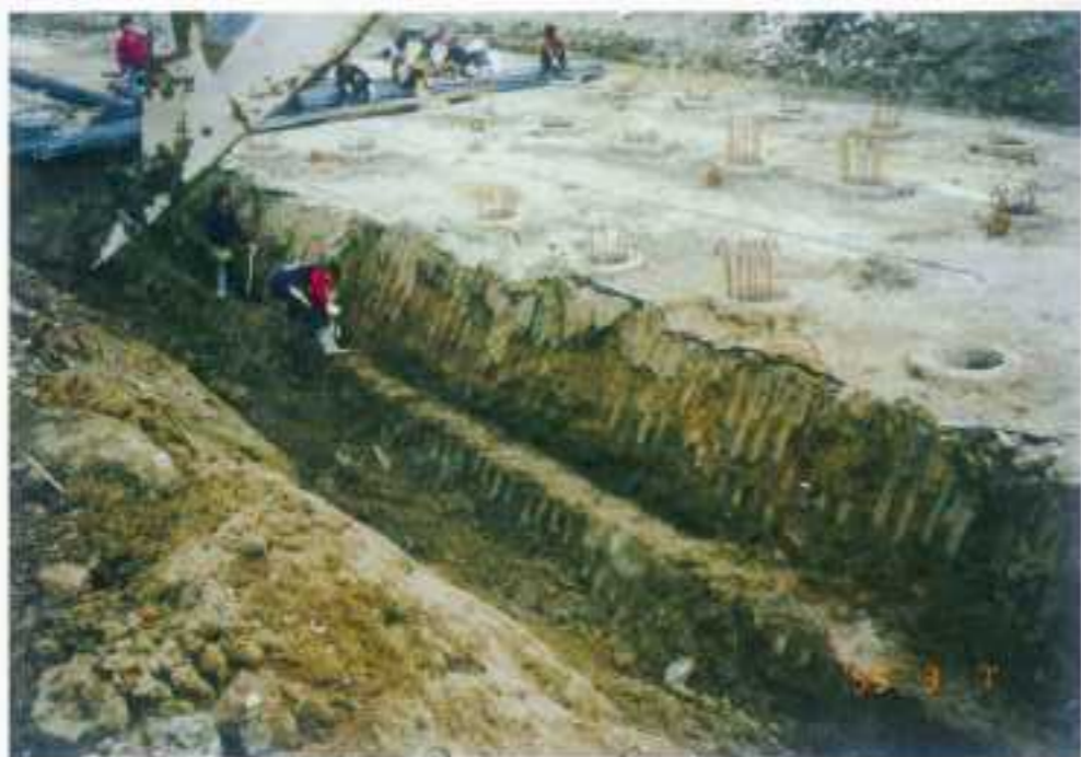
防洪工程 (S.M.W開挖)
