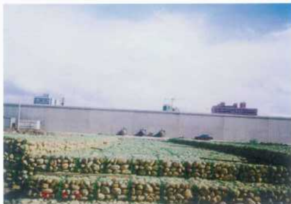
防洪工程 (抽水站排放口保護工)
