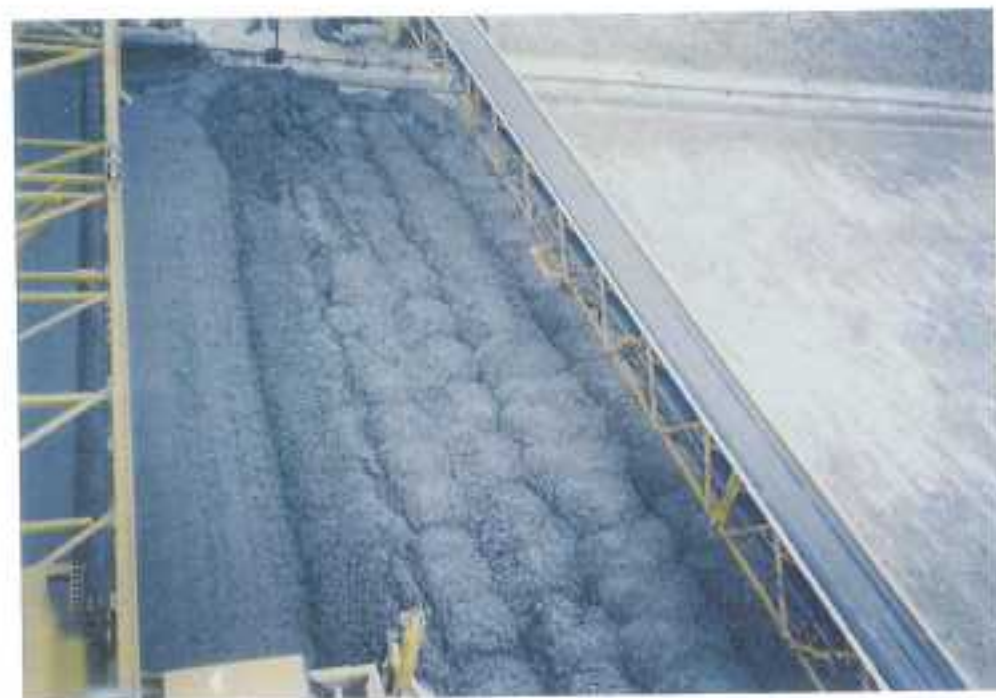
(圖五) 啓動鋪築機，鋪設坡面上
