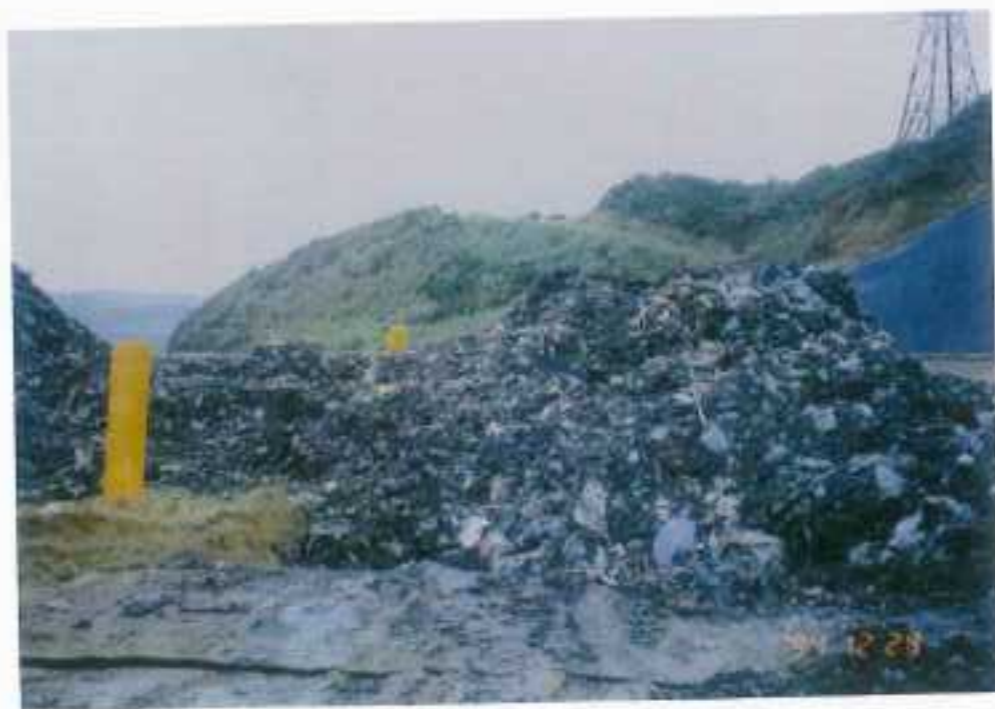
第一、二期工程腐植土清運掩埋場（二）
