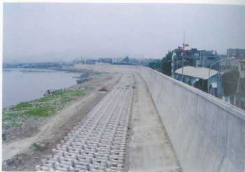
堤防工程 (完工實景)
