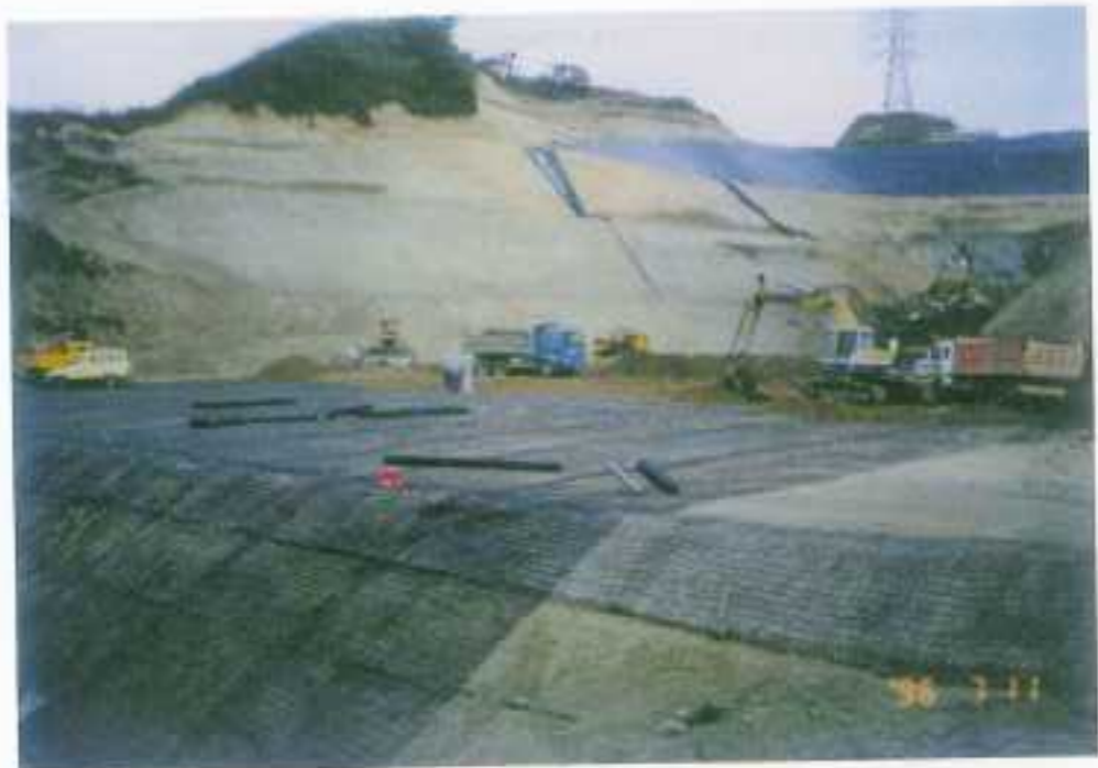
第三期工程堆置場土堤施工
