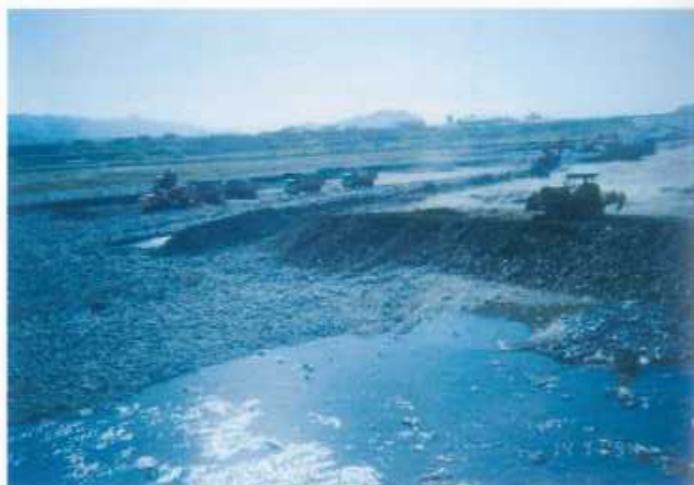
堤防工程（土堤填方）
