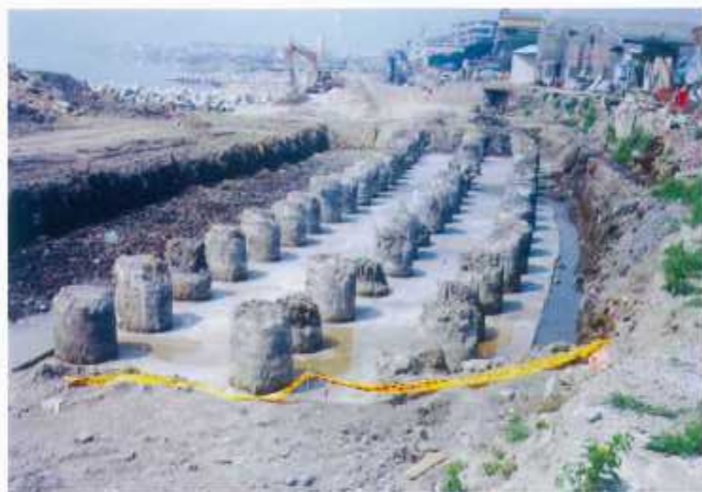
堤防工程 (反循環樁施工)
