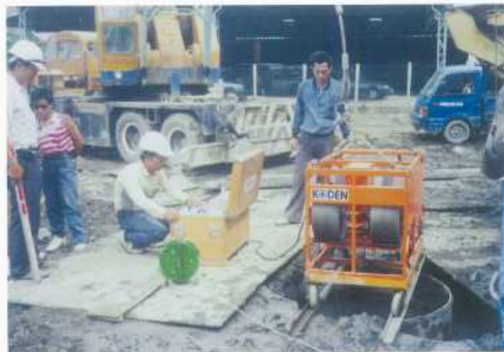
防洪工程 (反循環樁紅外線策試)
