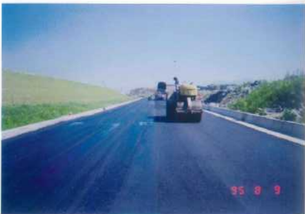
防洪工程 (瀝青施工)
