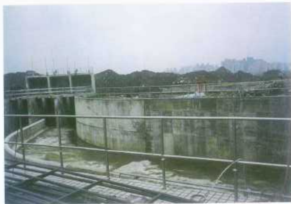
洲子洋抽水站工程 (施工中)
