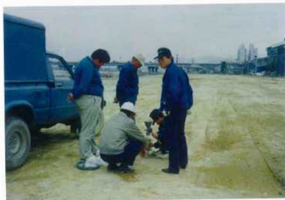
堤防工程 (土方密度試驗)
