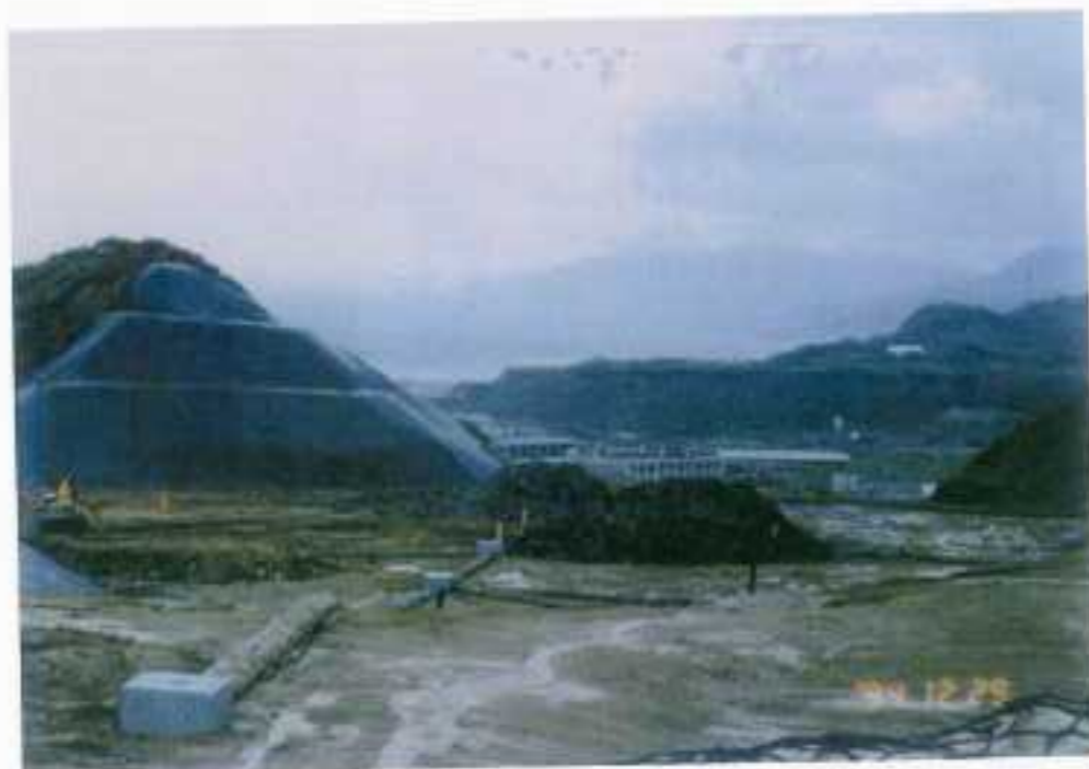
第一、二期工程腐植土清運掩埋場（一）
