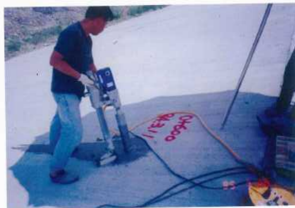
防洪工程 (混凝土鑽心試驗)
