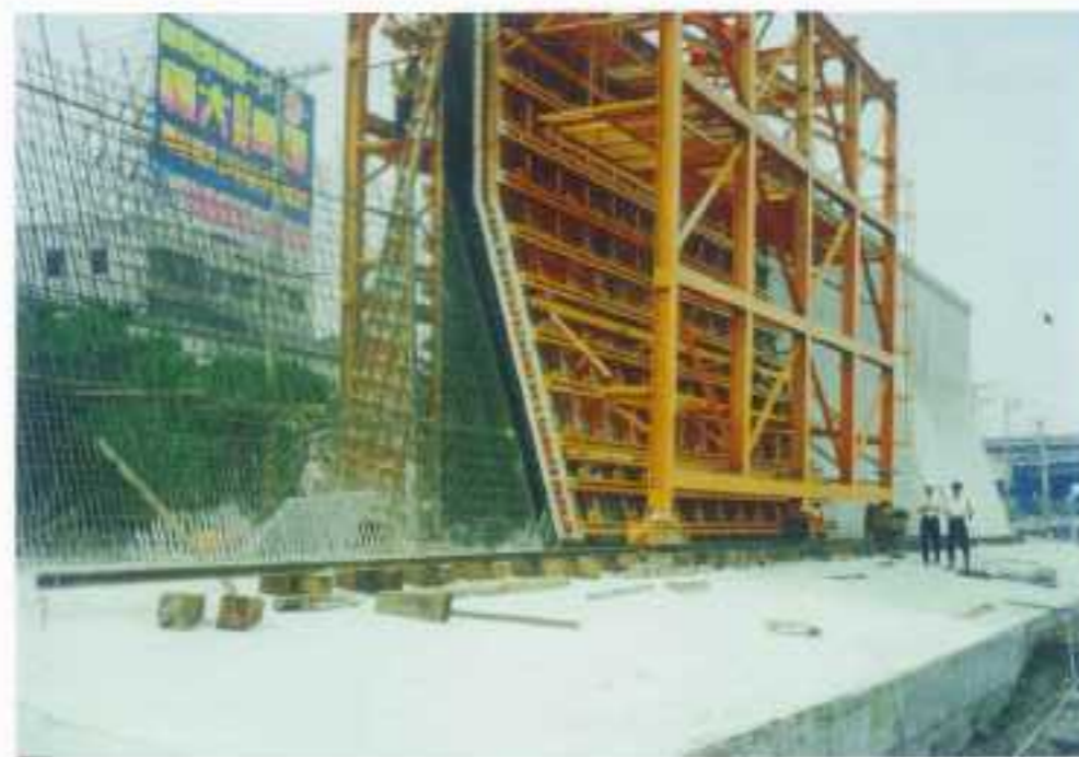
防洪工程 (防牆鋼模施工)
