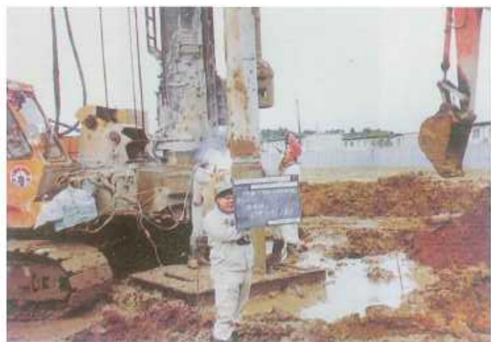
步驟③ 上，下基樁電焊接樁
