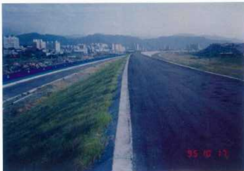
堤防工程（完工實景）
