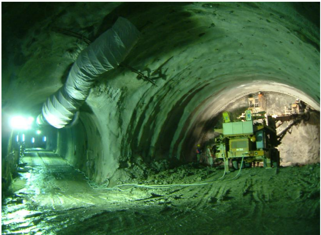
92.06.06 執行單位：十河局 工程名稱：員山子分洪隧道施工情形
