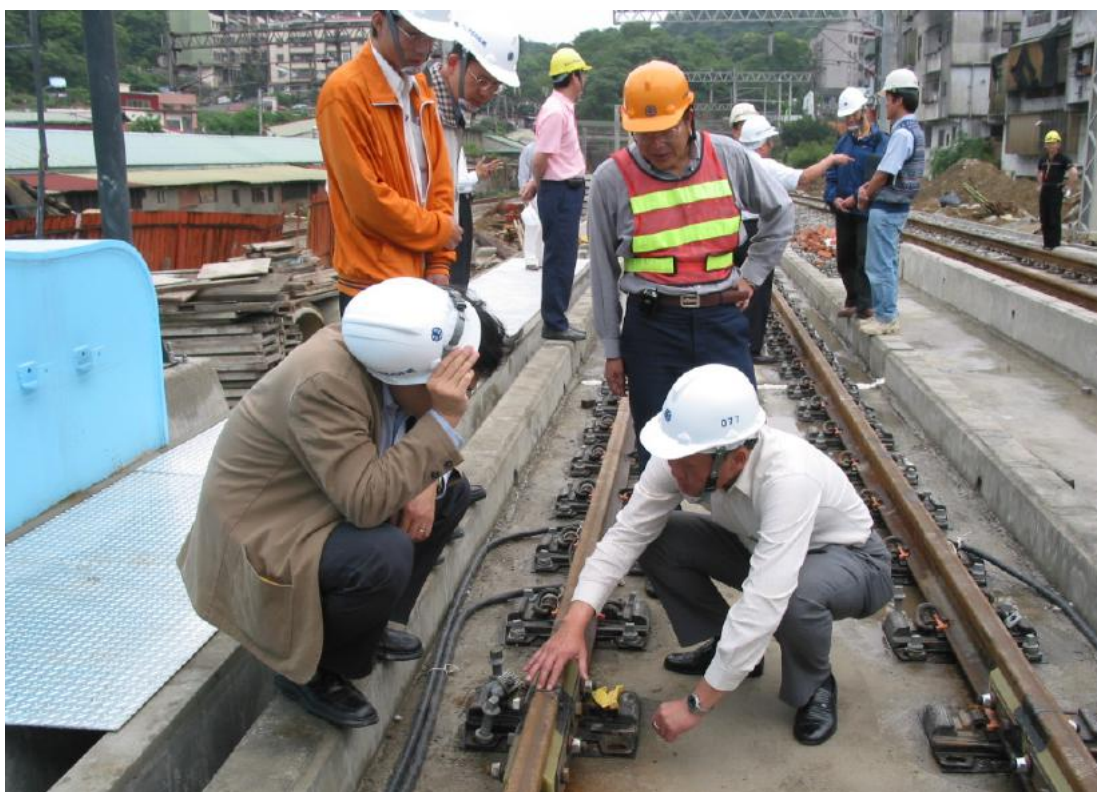
94.04.20 執行單位：臺灣鐵路管理局 工程名稱：鐵路八堵橋配合改建工程
