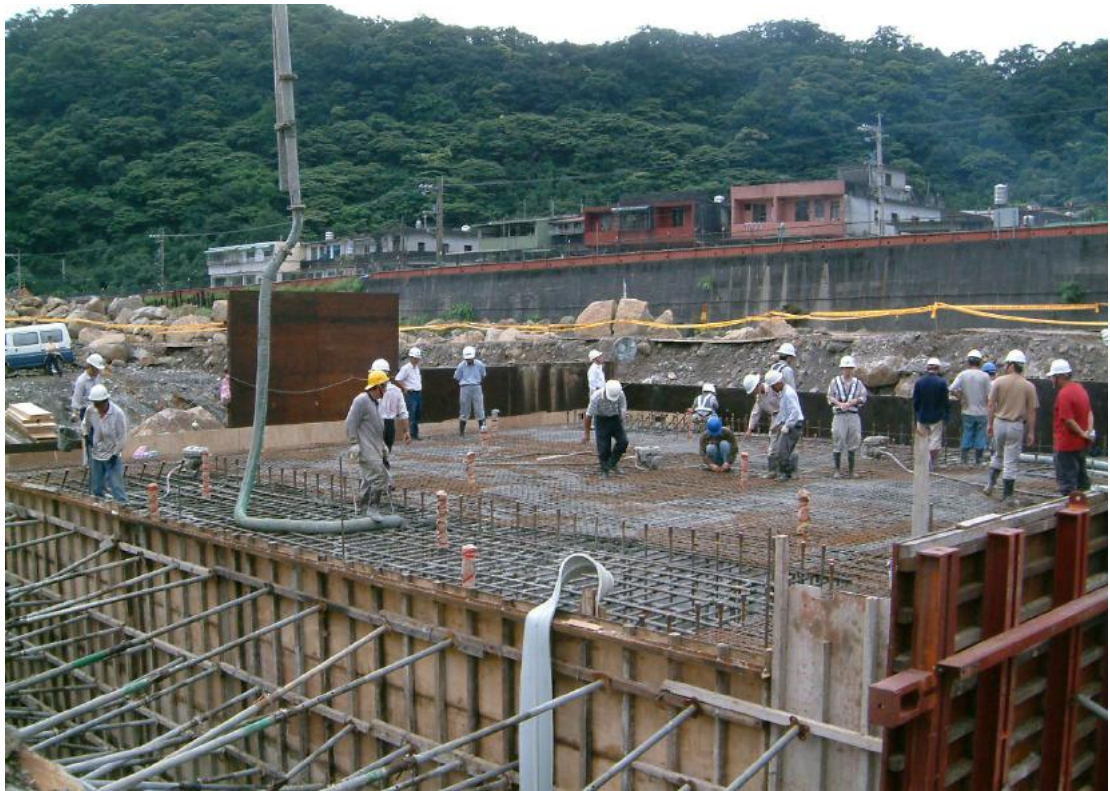
92.06.09 執行單位：十河局 工程名稱：員山子分洪攔河堰施工情形
