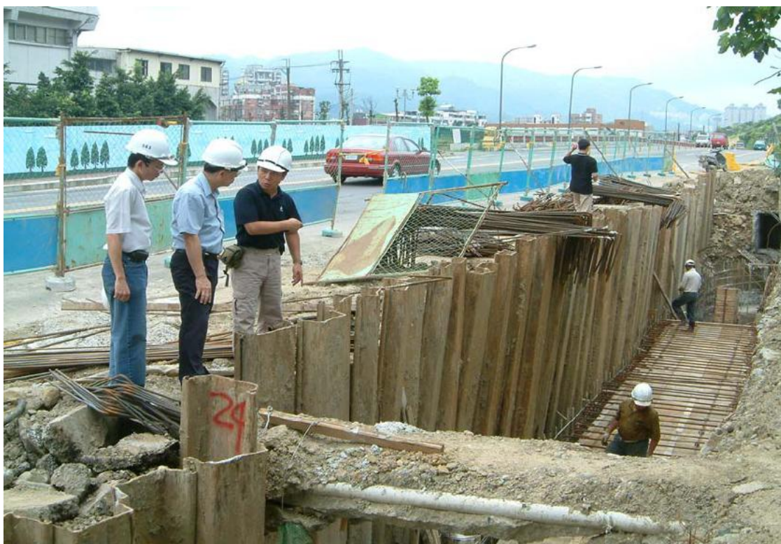
執行單位：基隆市政府工程名稱：基隆市六堵截排水溝工程壓力箱涵施作照片
