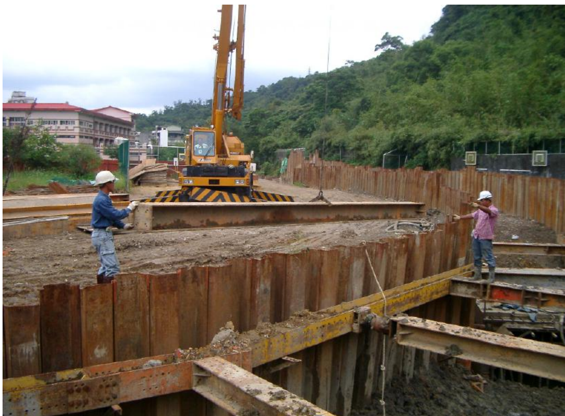
執行單位：基隆市政府 工程名稱：基隆市長興截排水溝工程壓力箱涵施作
