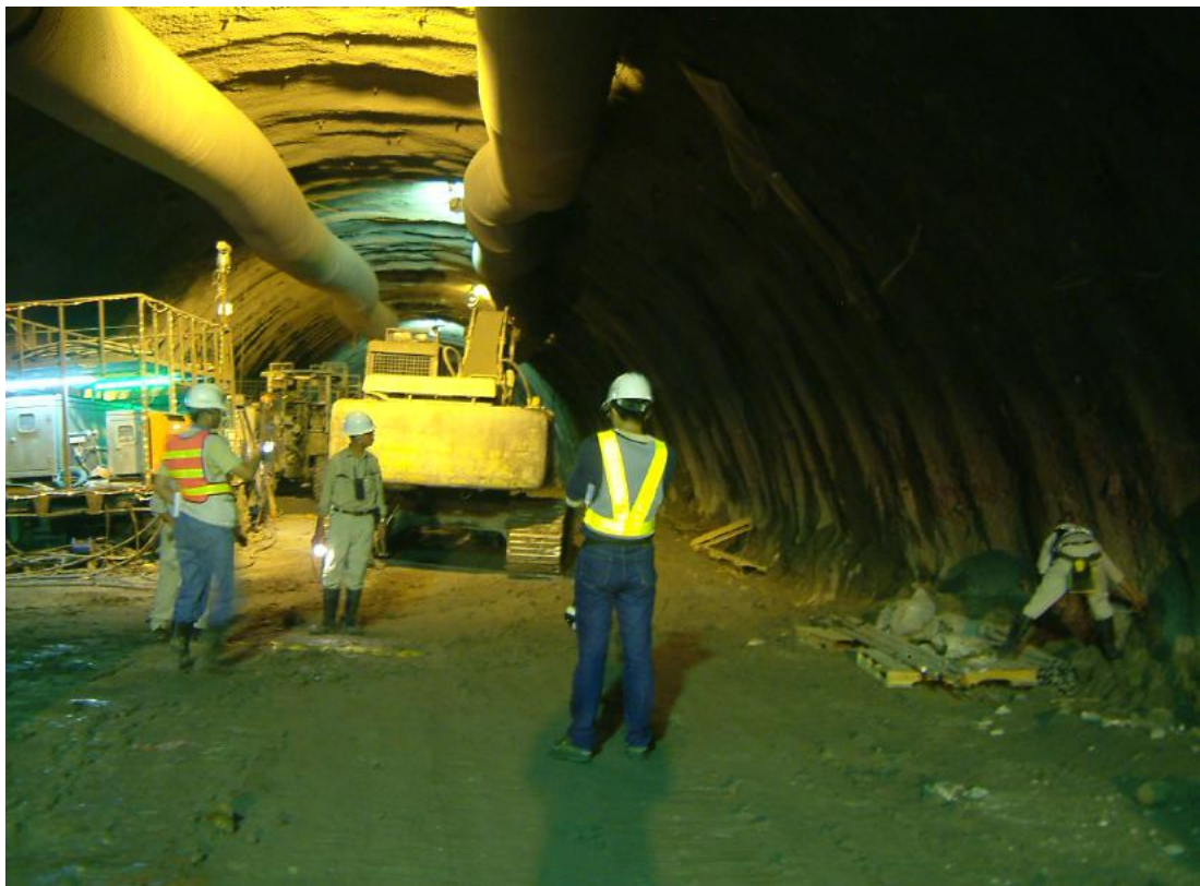
92.07.08 執行單位：十河局 工程名稱：員山子分洪隧道施工情形
