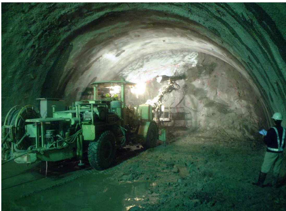
92.02.27 執行單位：十河局 工程名稱：員山子分洪隧道施工情形
