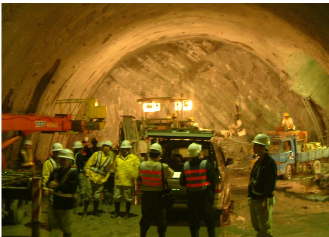
92.01.27 執行單位：十河局 工程名稱：員山子分洪隧道施工情形
