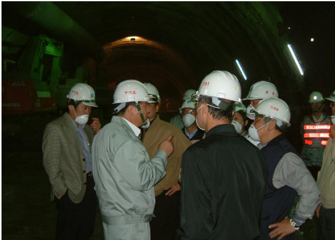
92.03.14 執行單位：十河局 工程名稱：員山子分洪隧道施工情形
