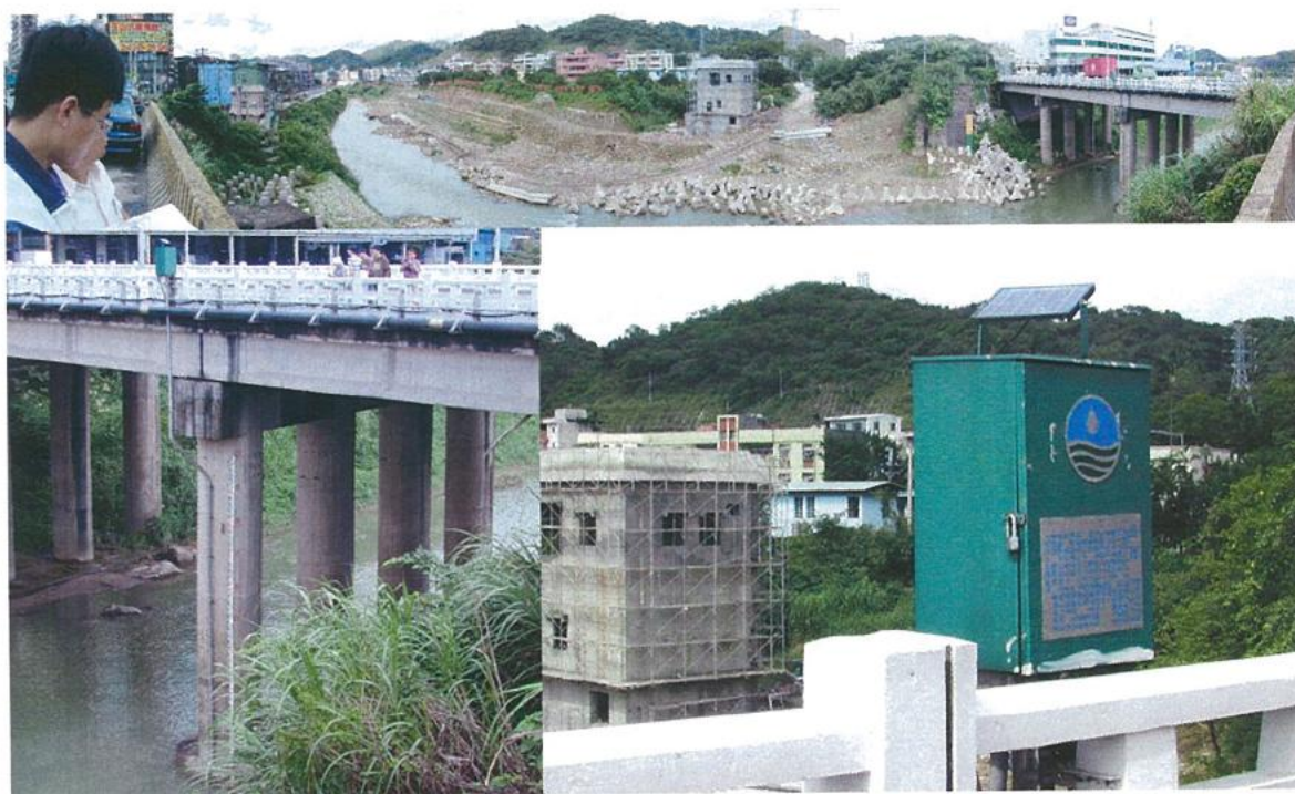
圖 A1.9.3 大華橋水位站
