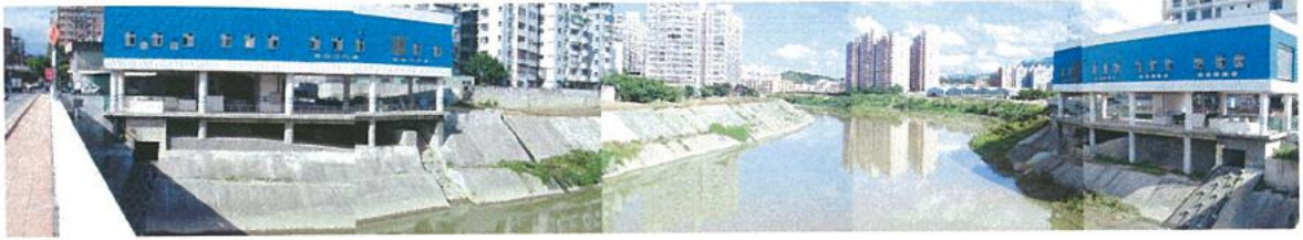
圖 A1.14.1 汐止社后橋上游面河道
