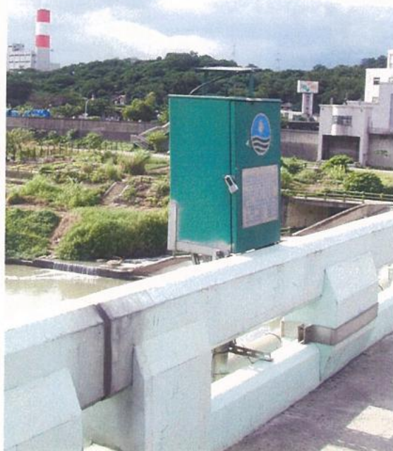
圖 A1.15.3 南湖大橋水位站
