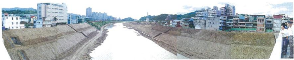
圖 A1.12.2 汐止長安橋下游面河道
