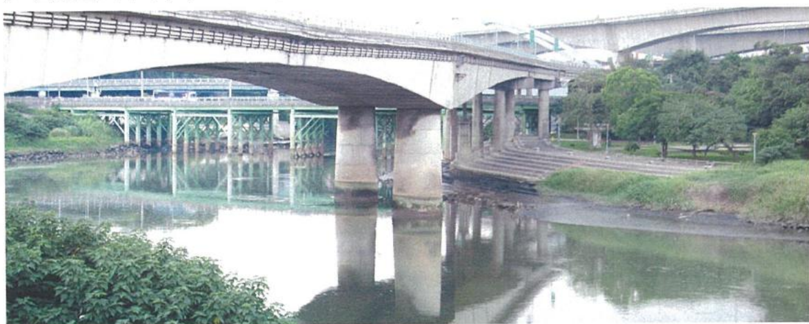
圖 A1.20.1 新生高架橋
