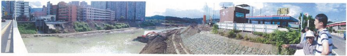
圖 A1.13.2 汐止江北橋下游面河道
