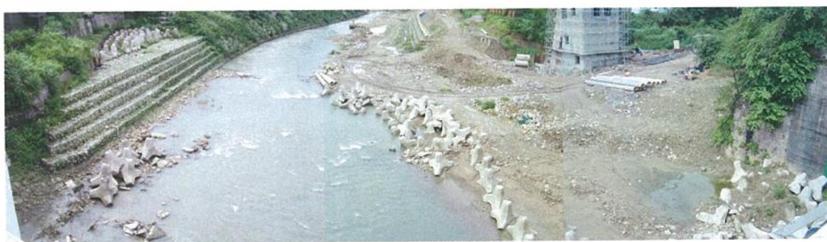
圖 A1.9.2 七堵大華橋下游面河道
