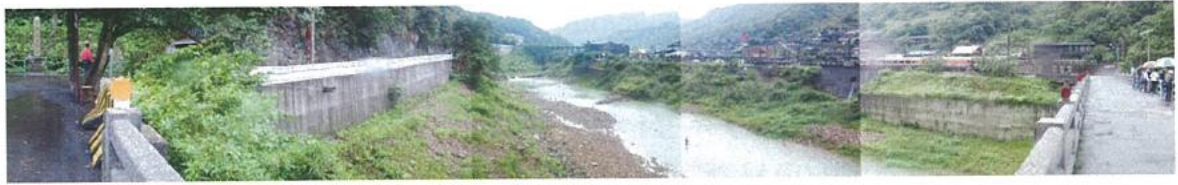
圖 A1.3.1 侯硐介壽橋上游面河道
