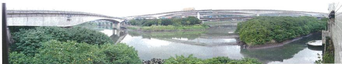
圖 A1.20.2 新生高架橋上游河段（圓山抽水站附近）
