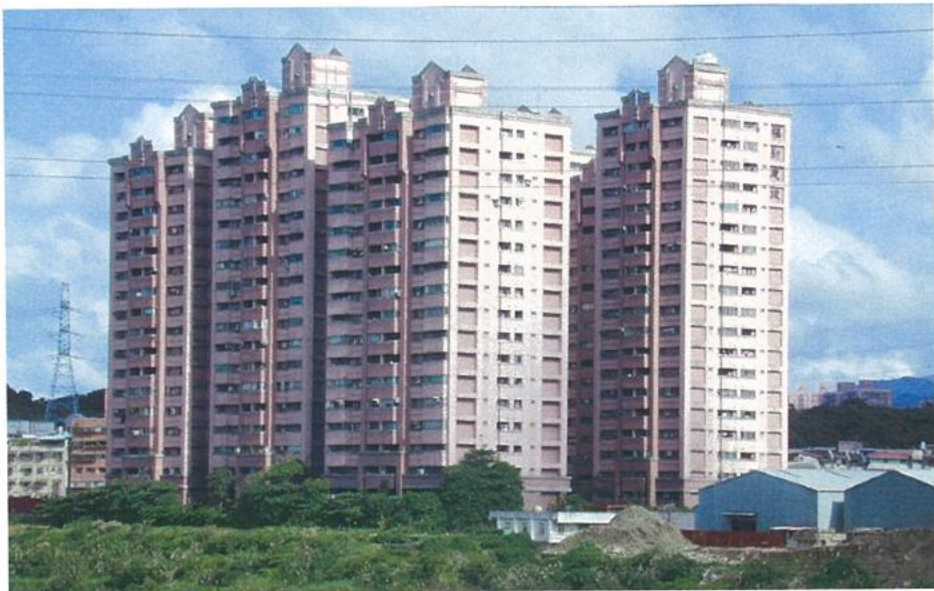
圖 A1.14.3 社后橋上游河岸臨近河岸民宅大樓
