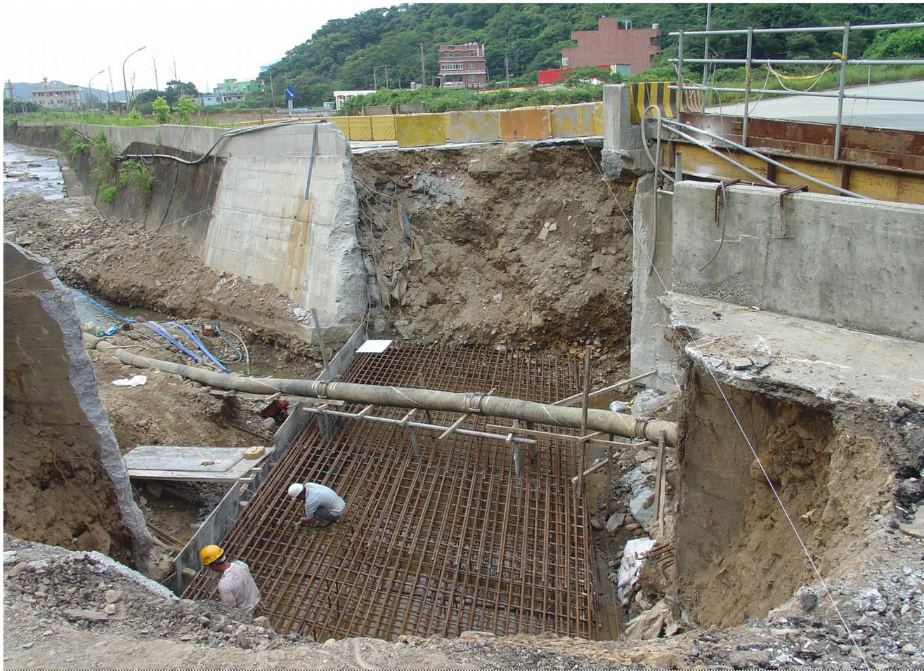
94/7/6 九份溪工區 九份溪箱涵橋基礎鋼筋綁紮施作
