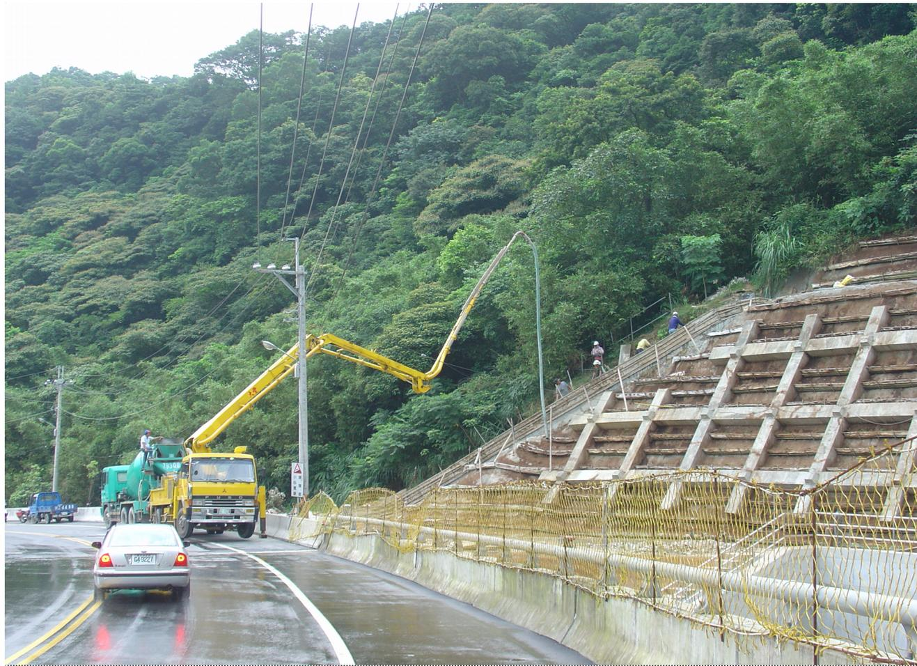
94/7/6 進水口工區 洞口上方集水井洩水溝混凝土澆置
