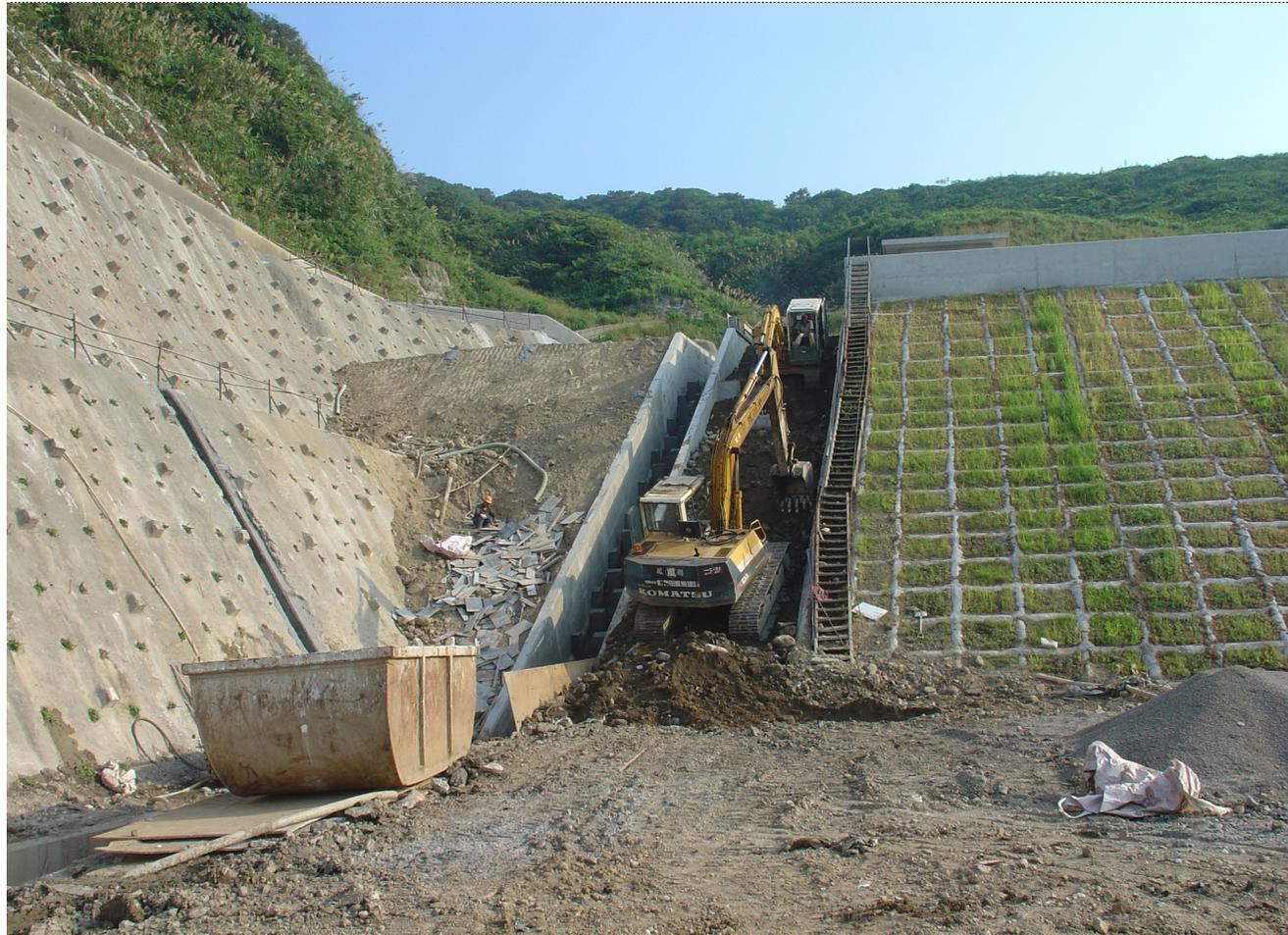
94/7/13 出水口工區 排水工程陡槽段結構回填施作
