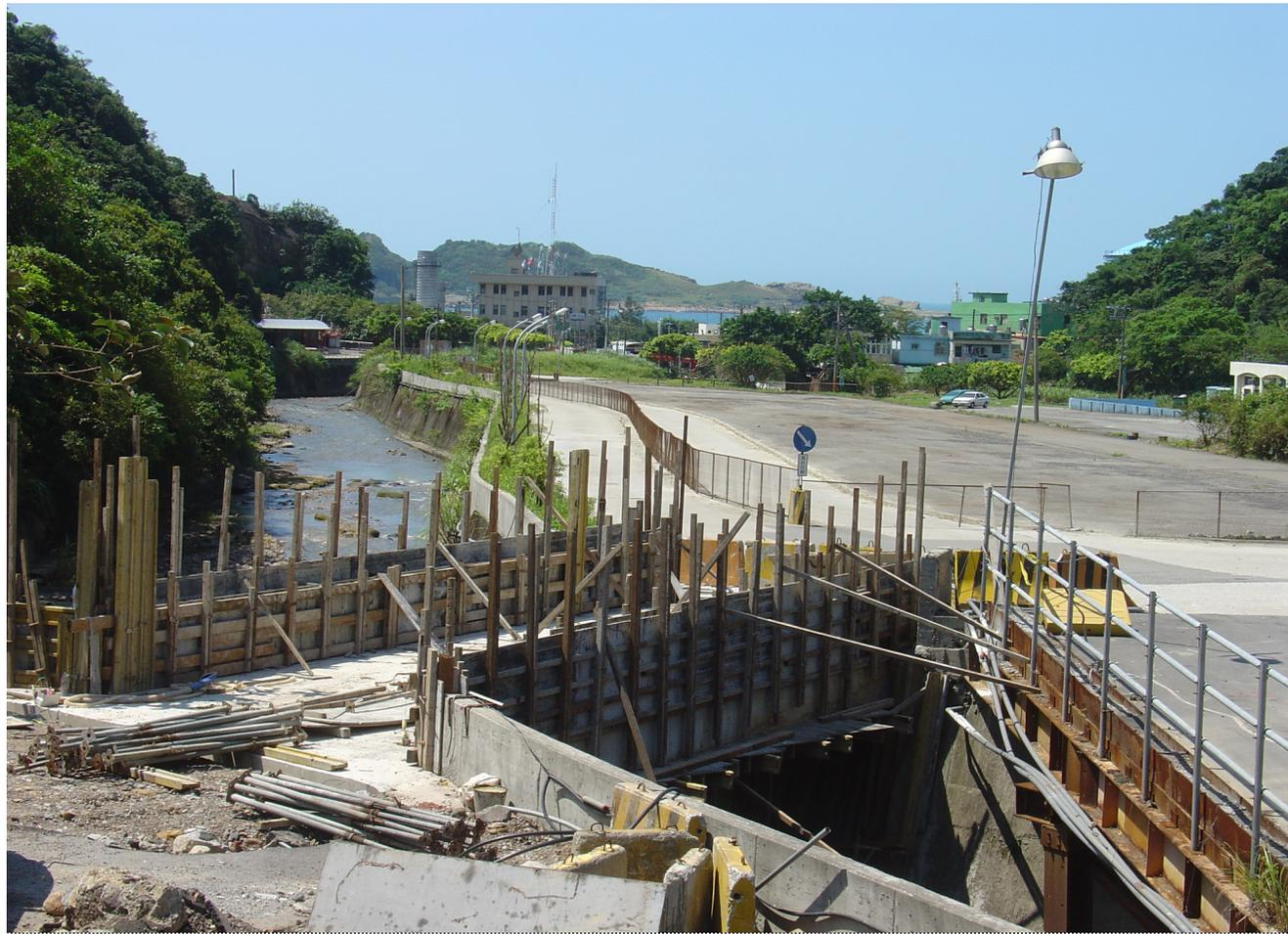
94/7/22 九份溪工區 九份溪箱涵橋護欄鋼筋綁紮
