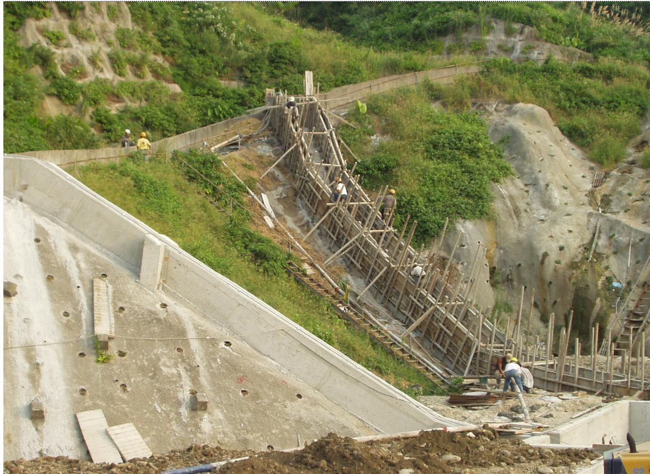
94/7/6 出水口工區 邊坡排水溝施作混凝土澆置
