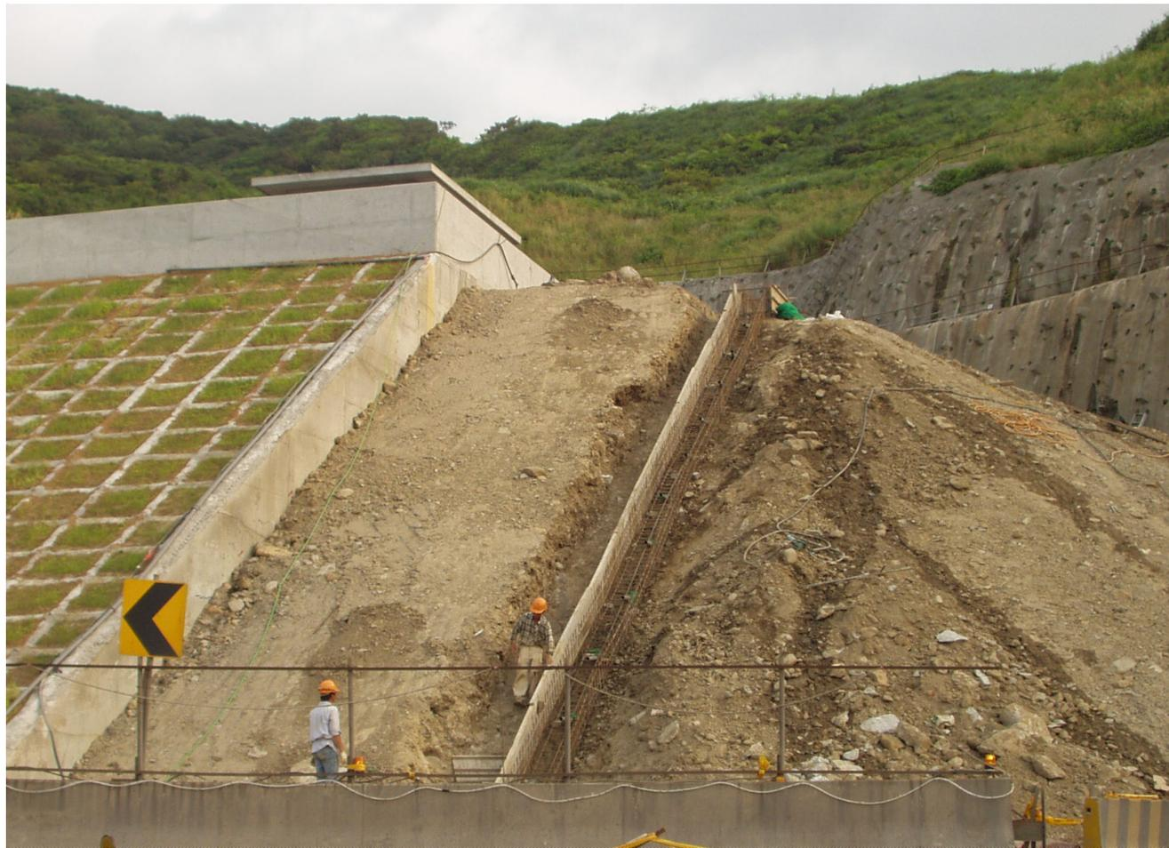
94/7/6 出水口工區 排水工程陡槽段排水溝施作
