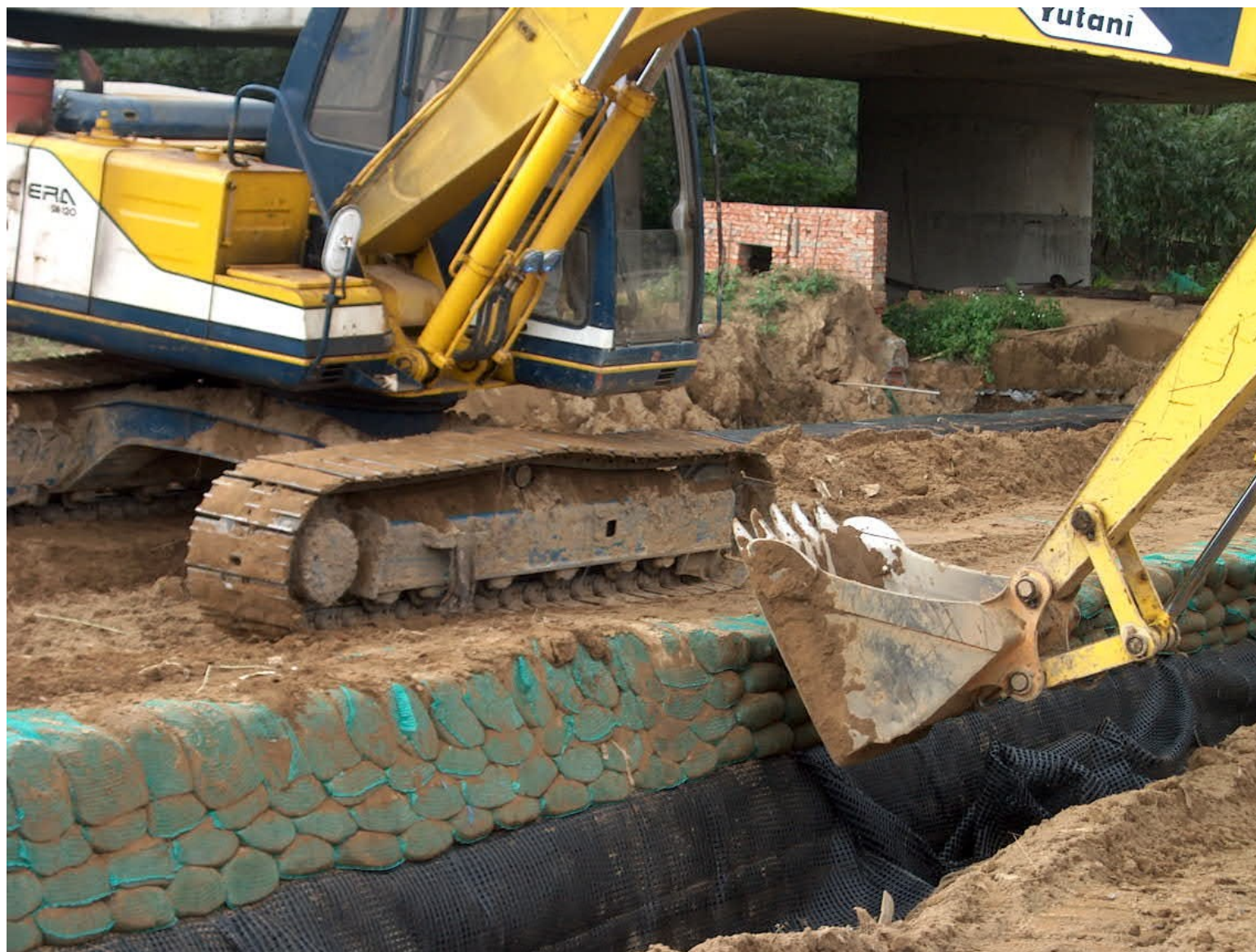
七賢橋下游右岸堤段（施工中）
