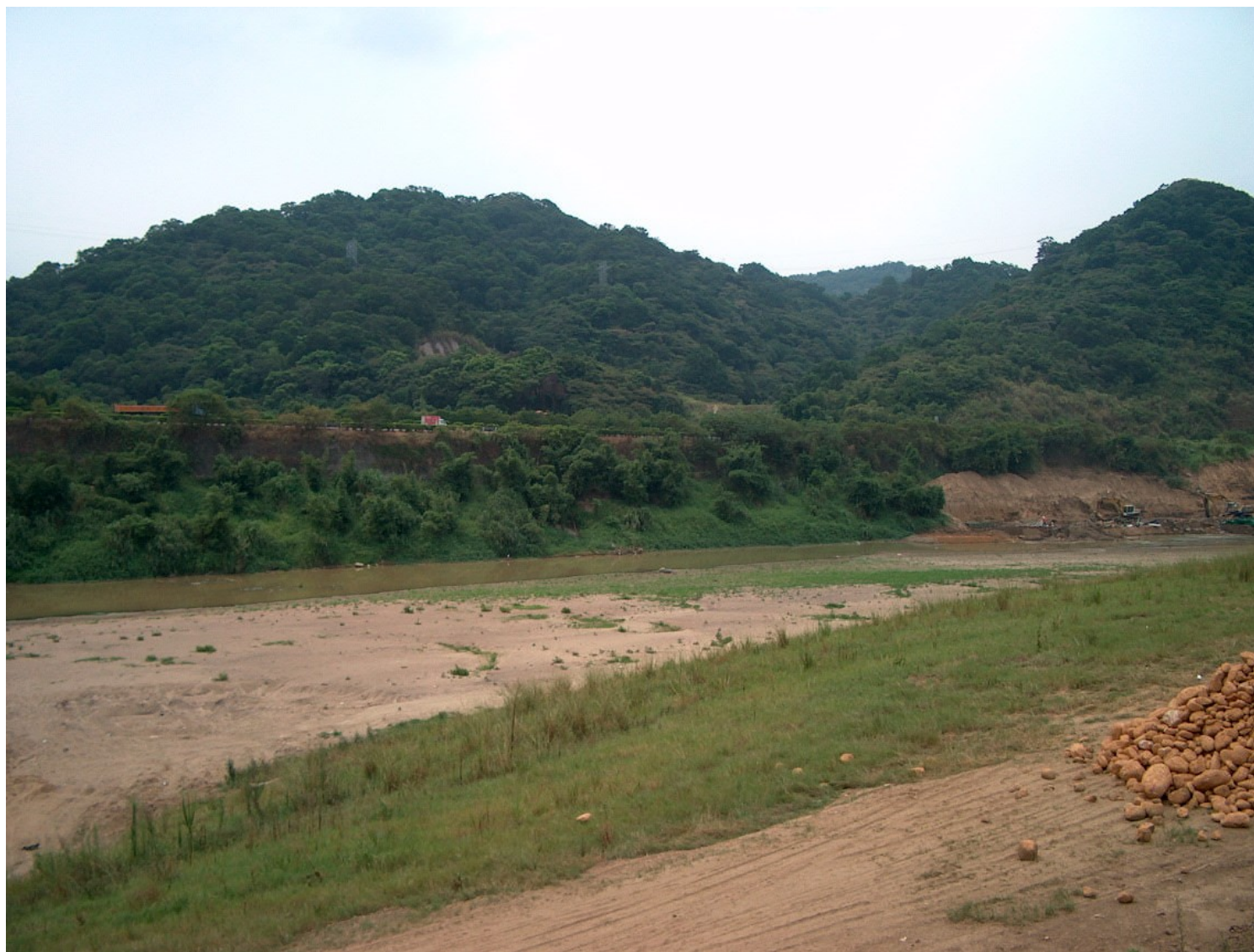
五福橋上游右岸堤段（施工前）
