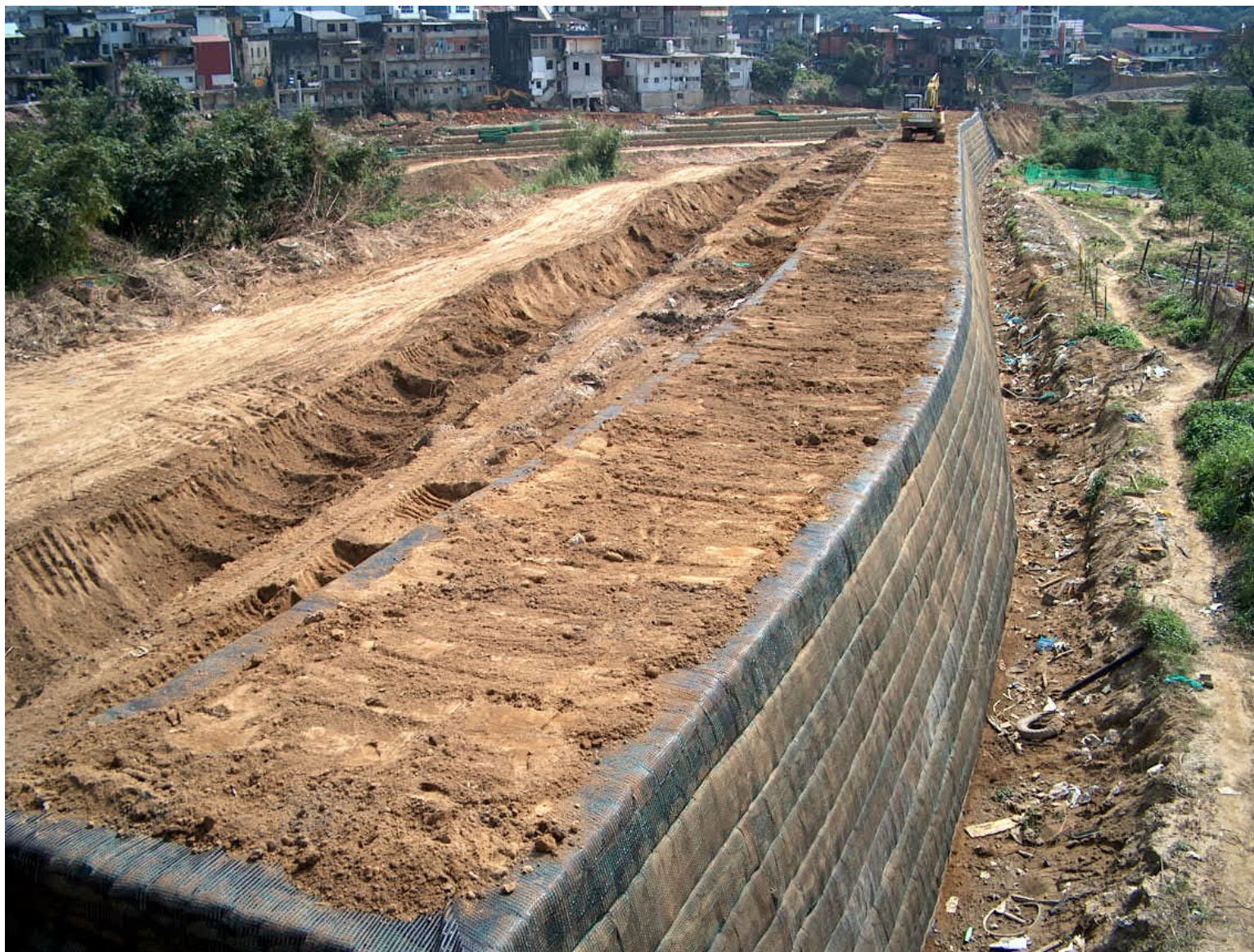
七賢橋下游右岸堤段（施工中）
