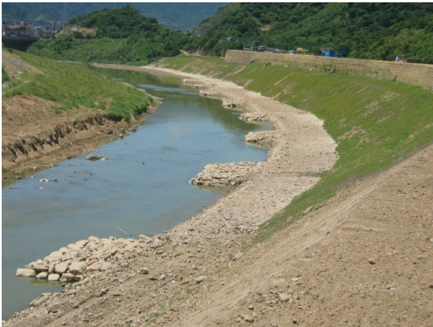
五福橋上游右岸堤段（完工後）
