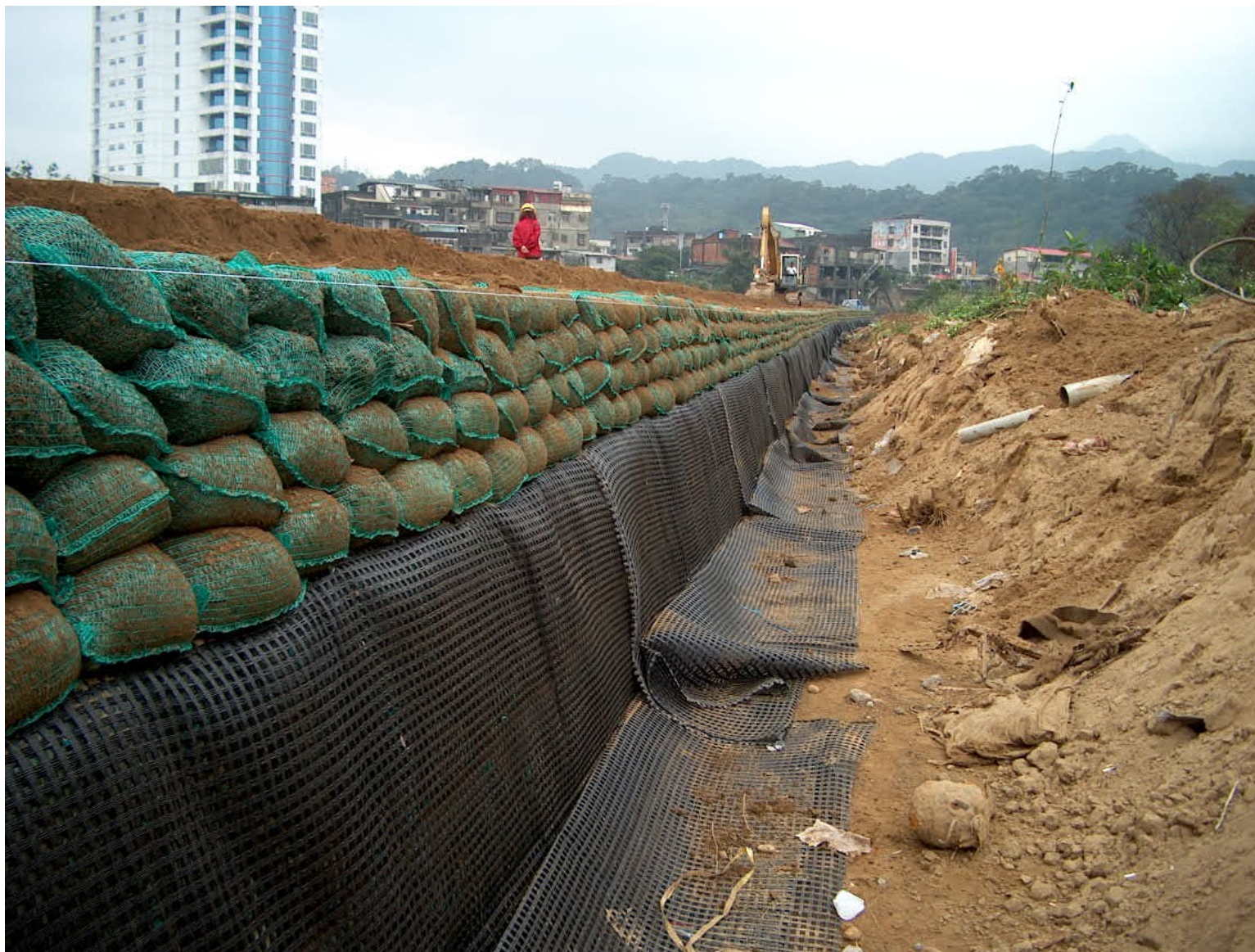
七賢橋下游右岸堤段（施工中）
