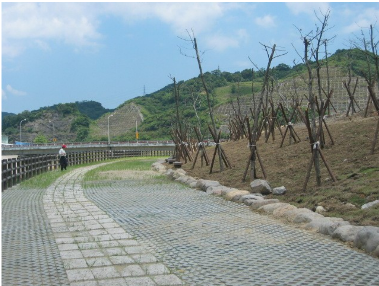
六合橋上游右岸堤段（完工後）
