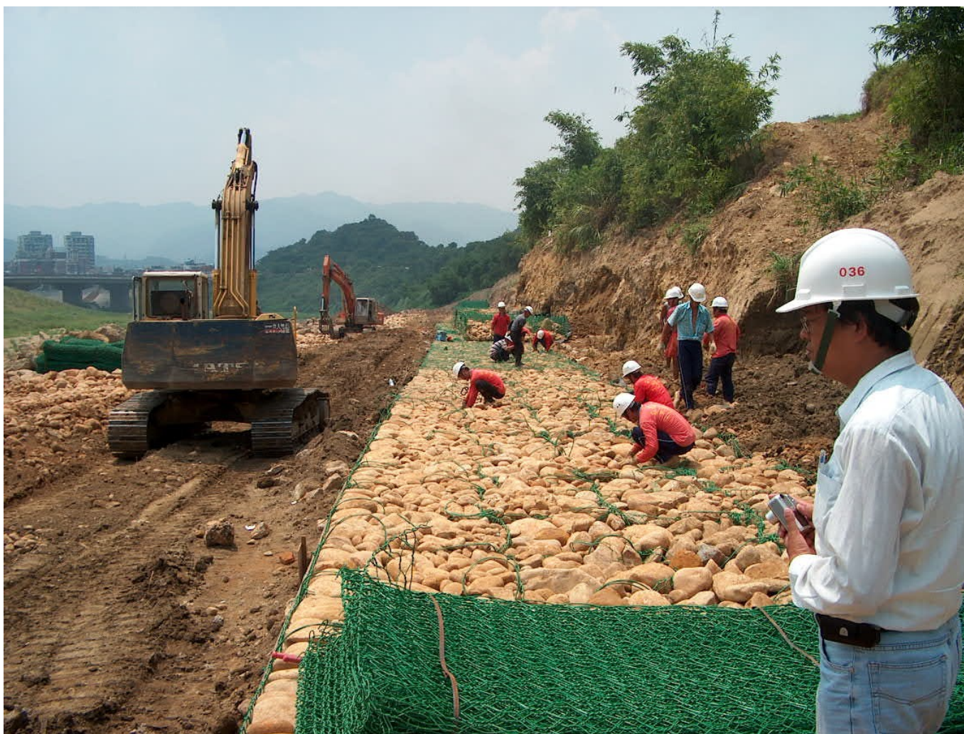
五福橋上游右岸堤段（施工中）
