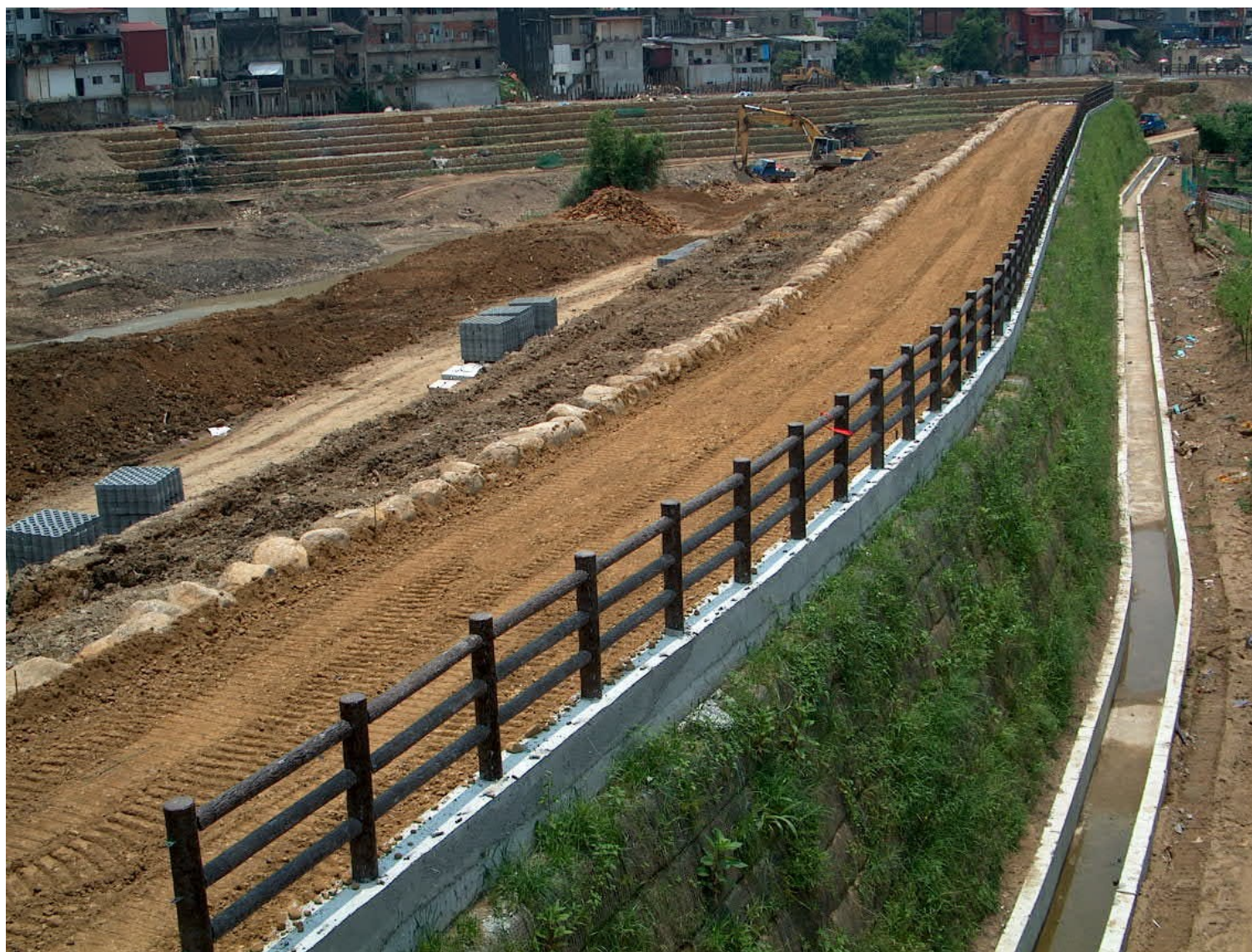
七賢橋下游右岸堤段（施工中）
