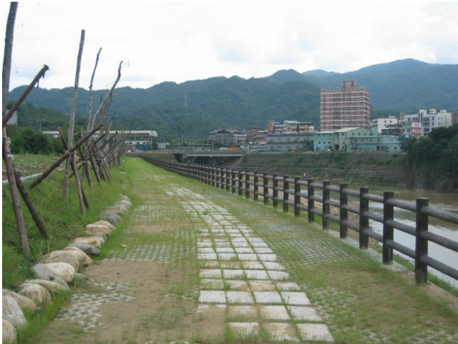
六合橋上游右岸堤段（完工後）
