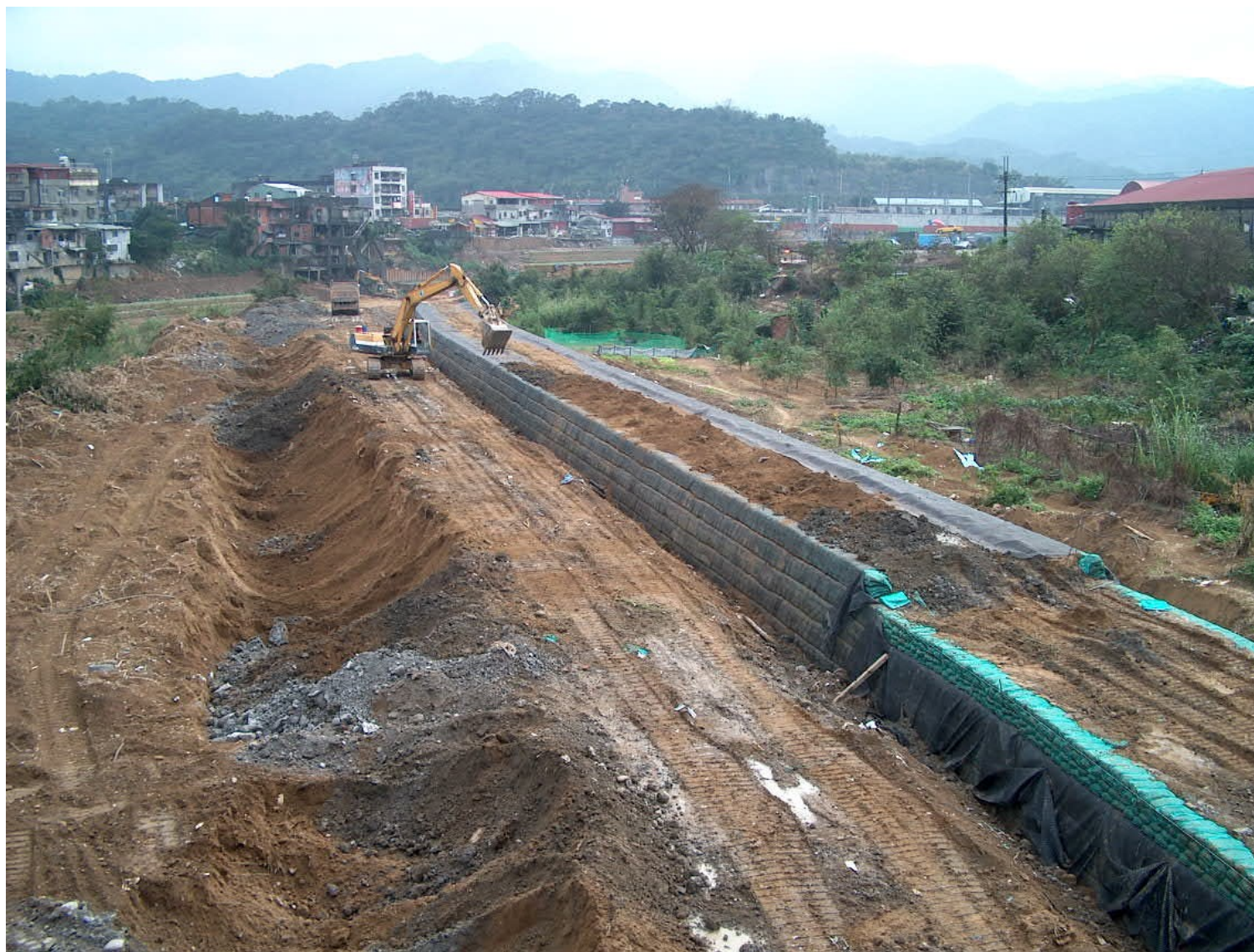
七賢橋下游右岸堤段（施工中）
