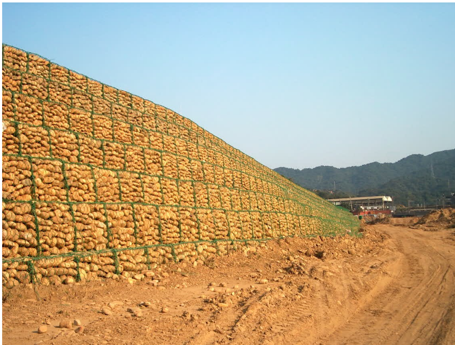
六合橋上游右岸堤段（施工中）
