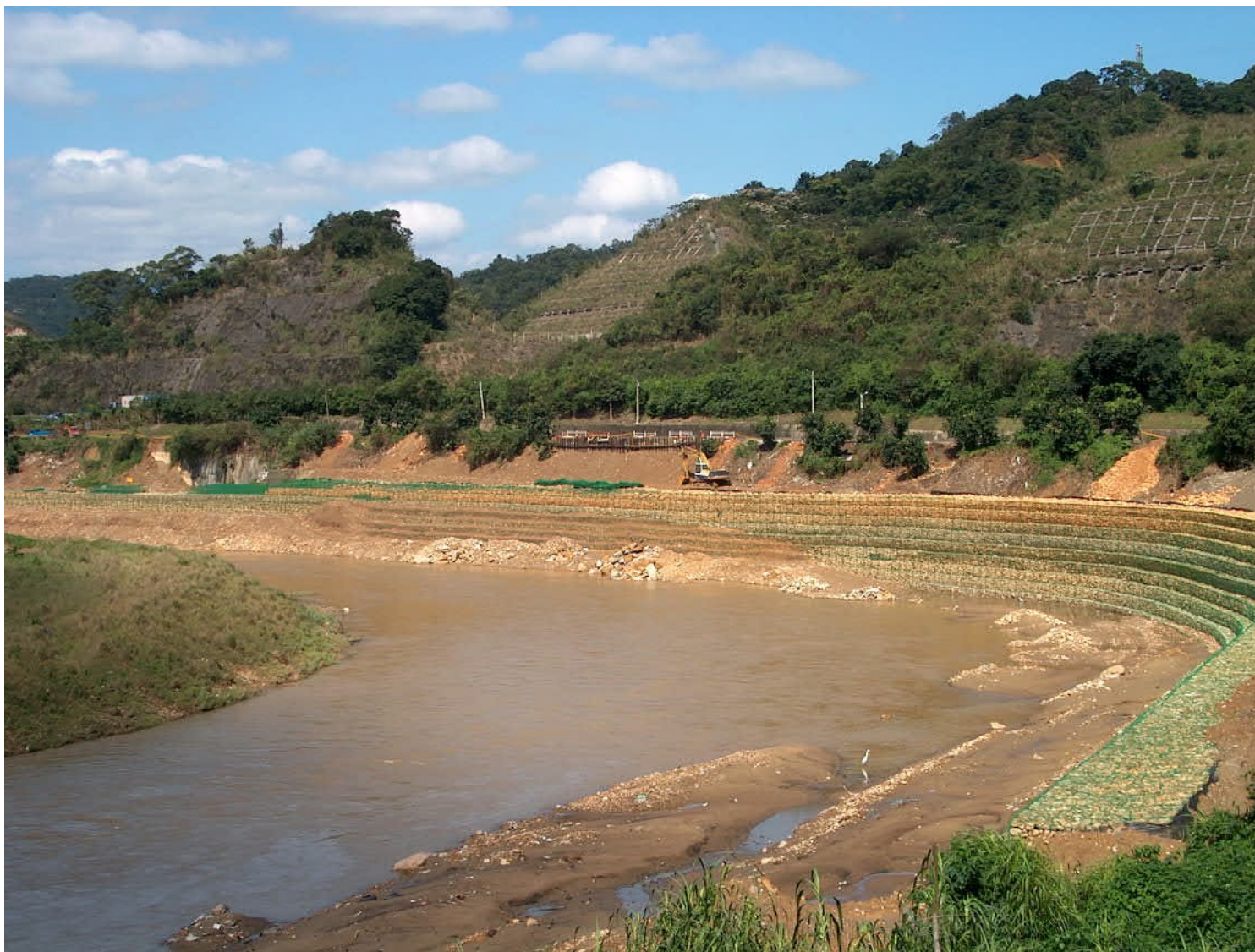
六合橋下游右岸堤段（施工中）
