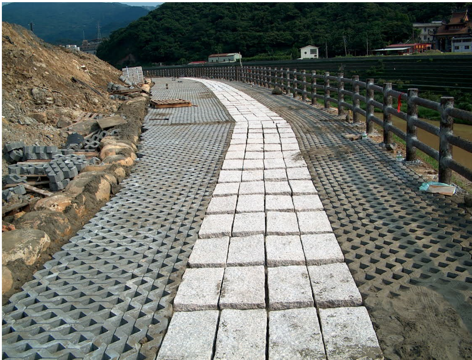
六合橋上游右岸堤段（施工中）
