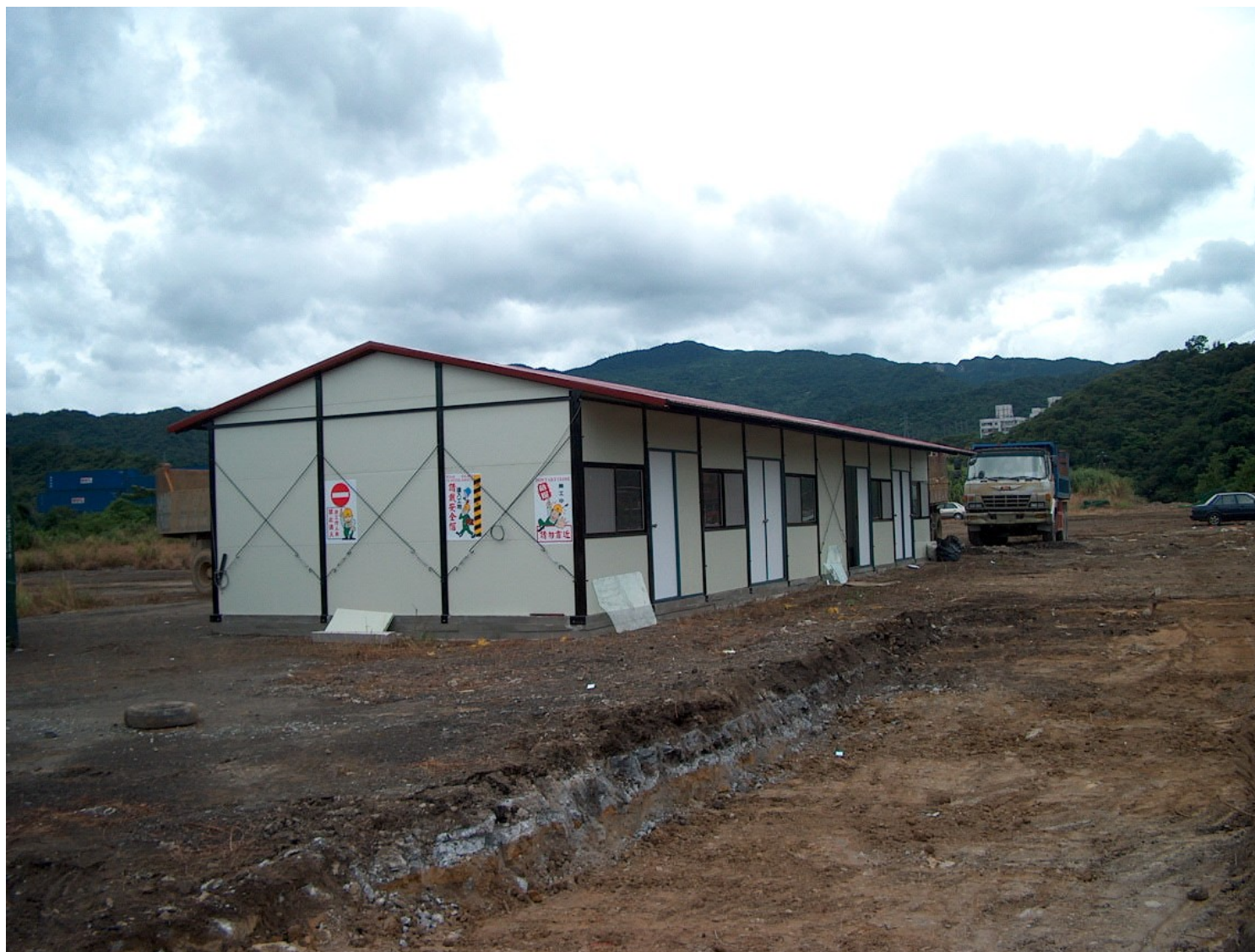
六和橋右岸工務所及料場整備（施工前）
