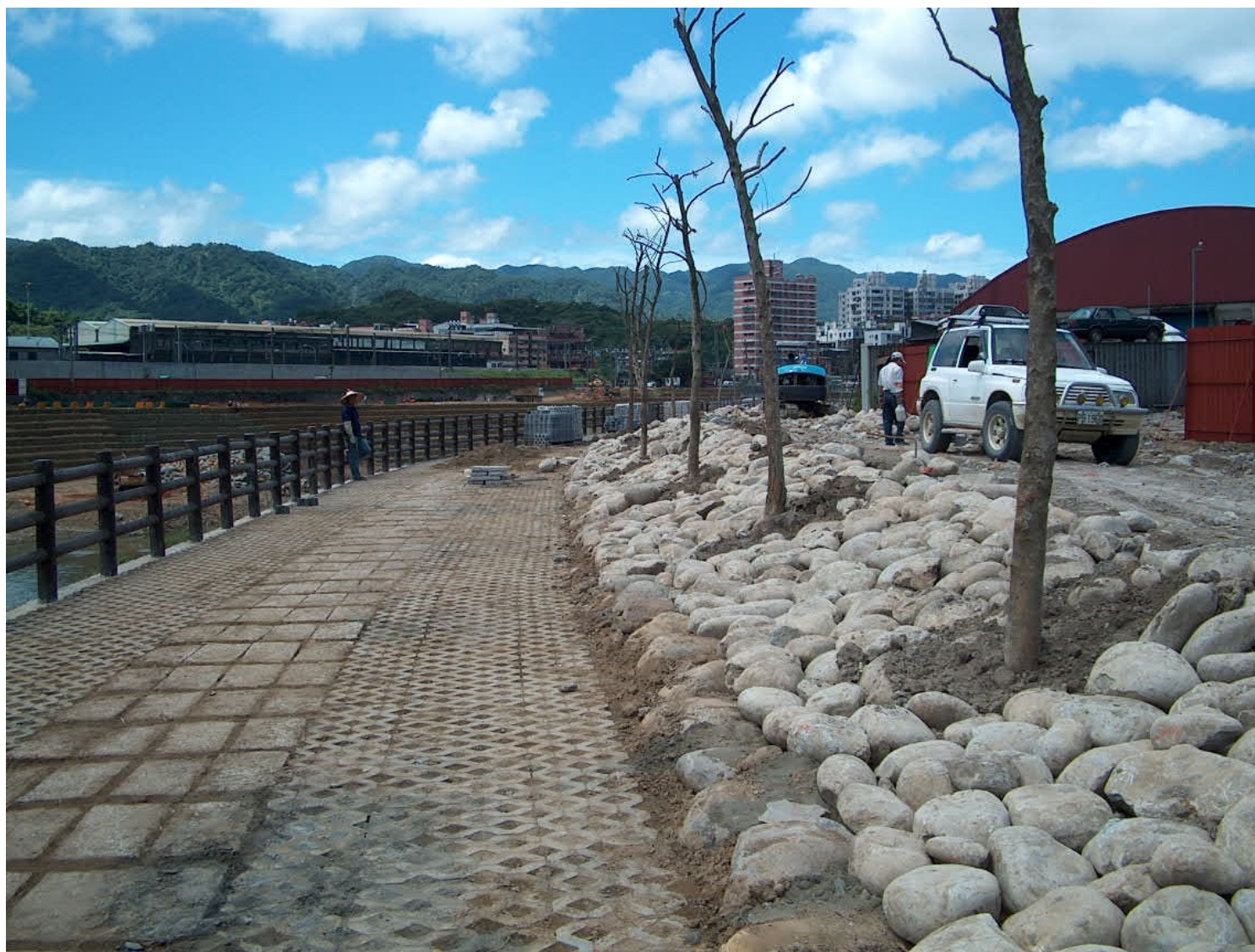
七賢橋下游右岸堤段（施工中）
