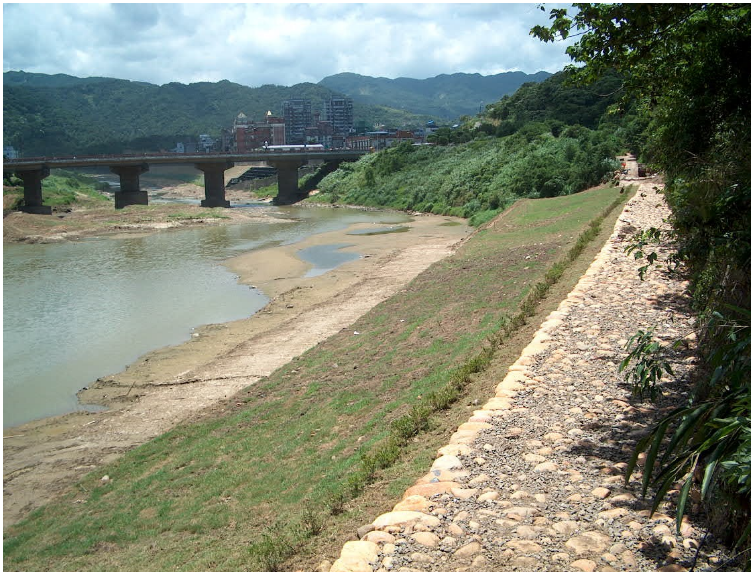
五福橋上游右岸堤段（完工後）
