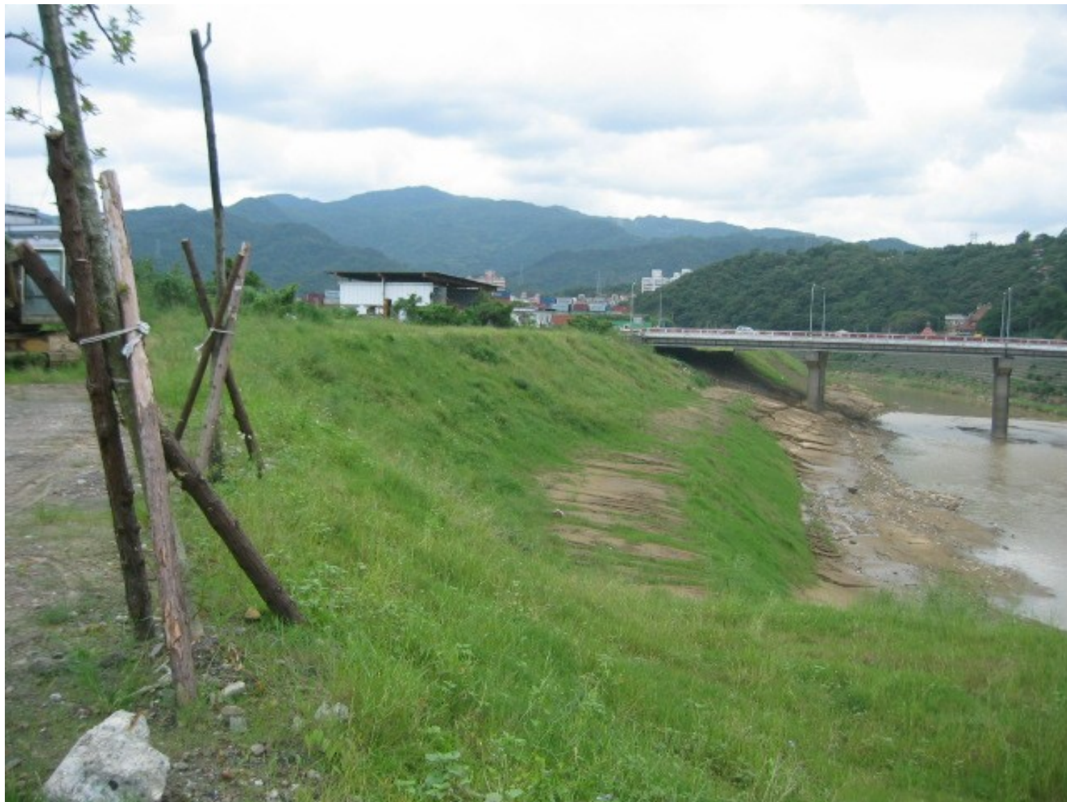
六合橋下游右岸堤段（完工後）
