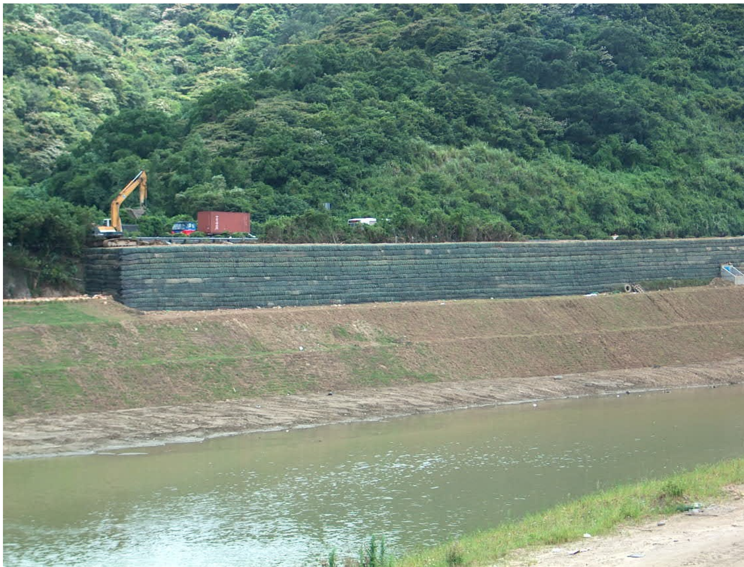
五福橋上游右岸堤段（完工後）
