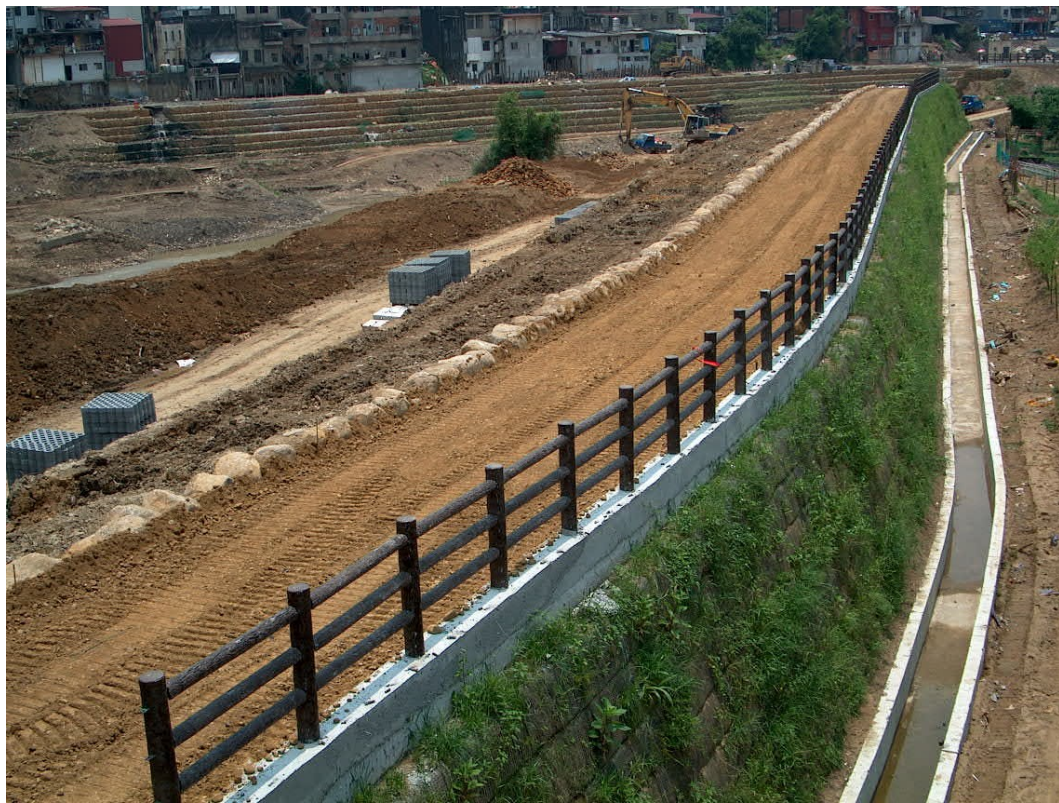
仿木欄杆完成
