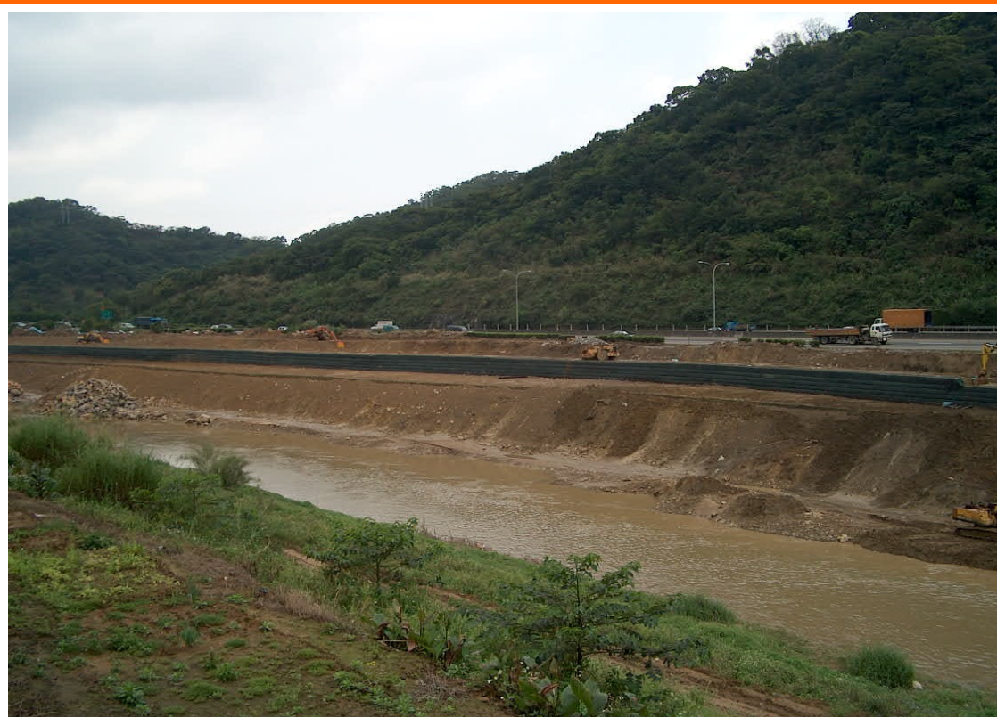
二工區0+700~0+900石籠前坡覆土完成
