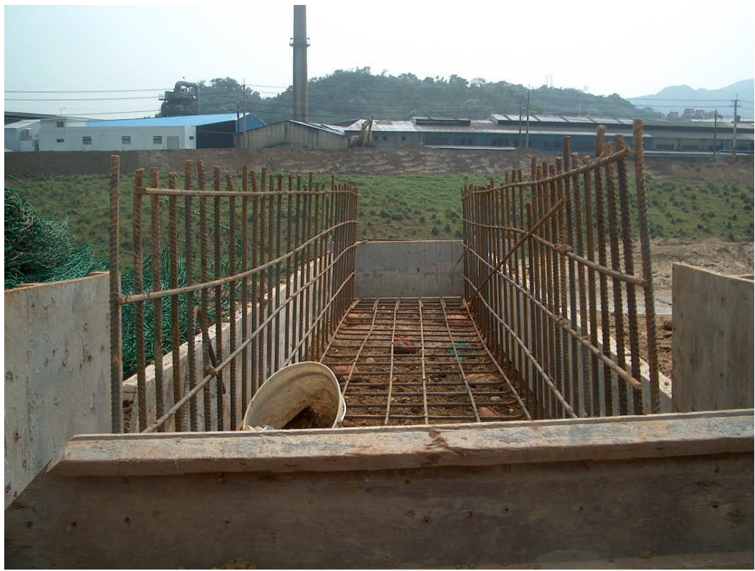
二工區排水工鋼筋及模版組立
