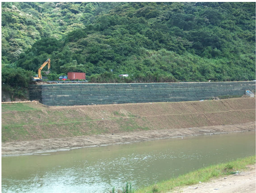
二工區加勁土堤完成
