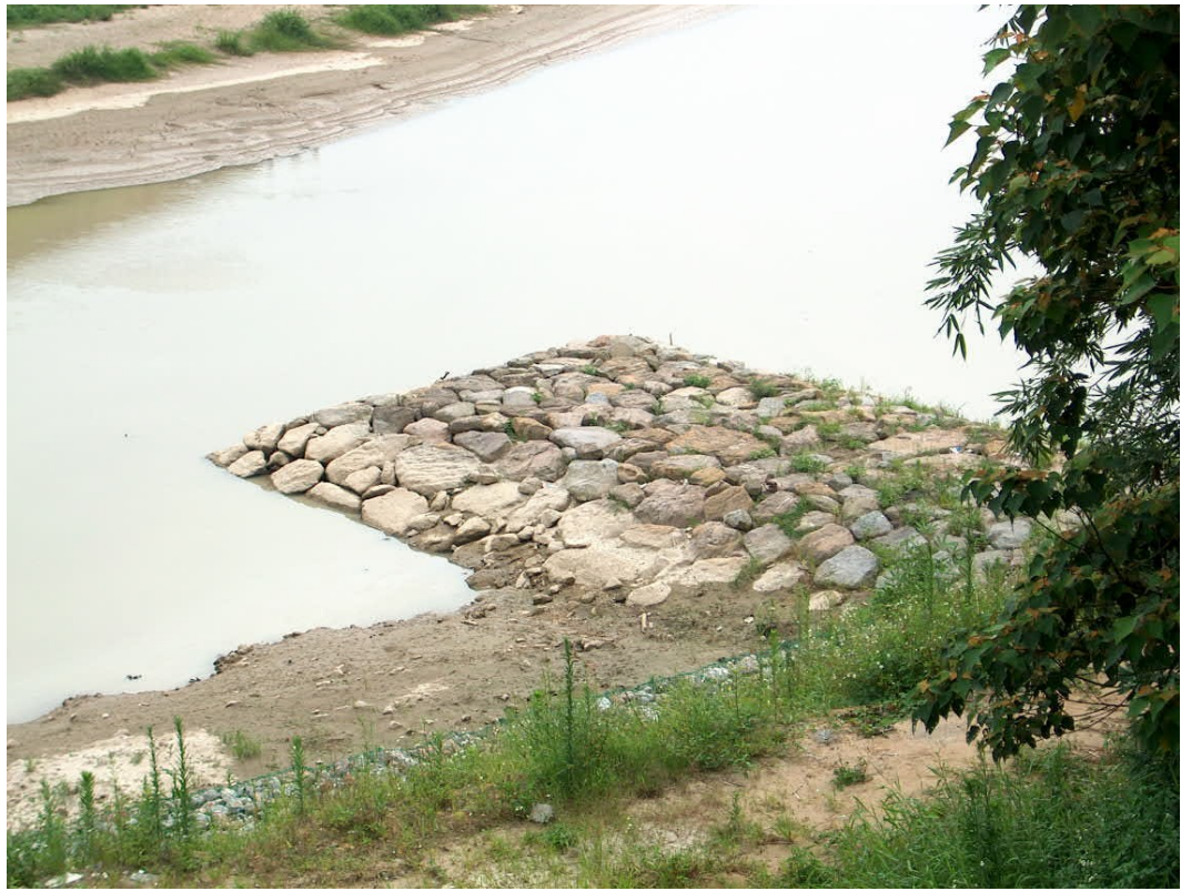
拋石丁堤完成
