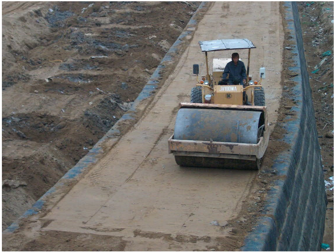
10噸三輪壓路機進行滾壓夯實
