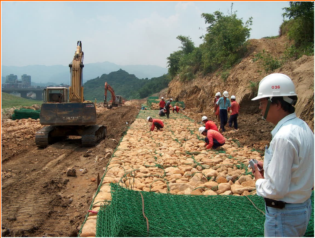
工人排放塊石
