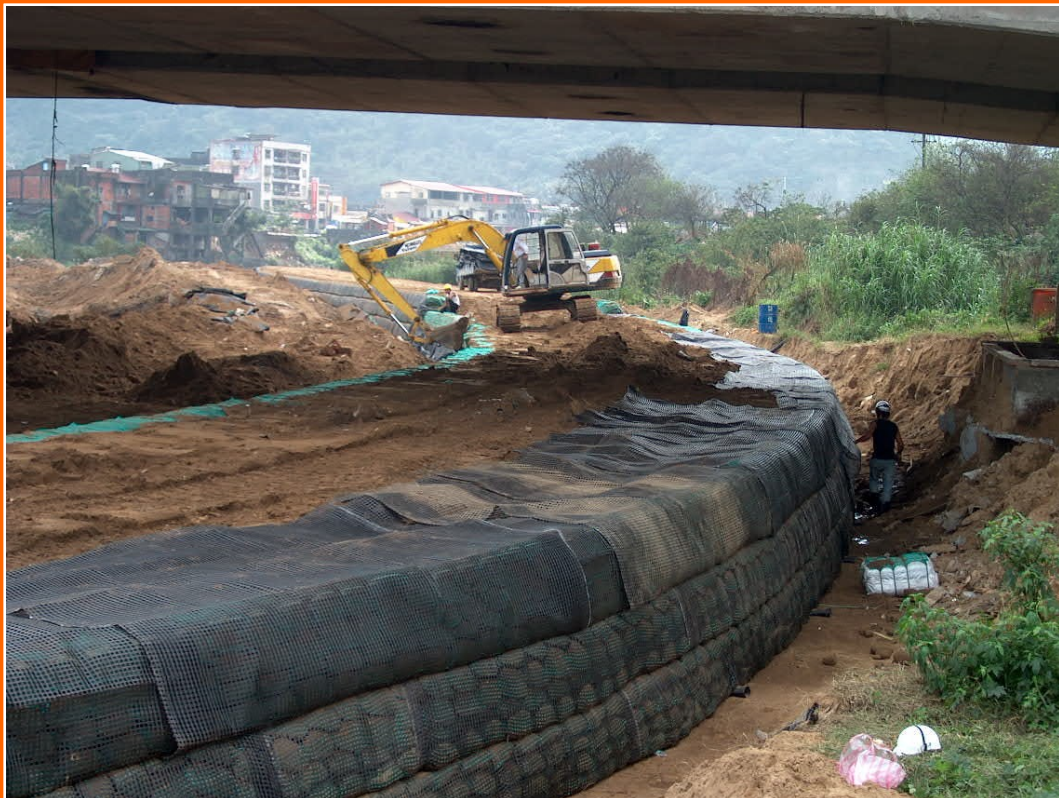
加勁格網回包長度 \geq 2.5\text{m}
