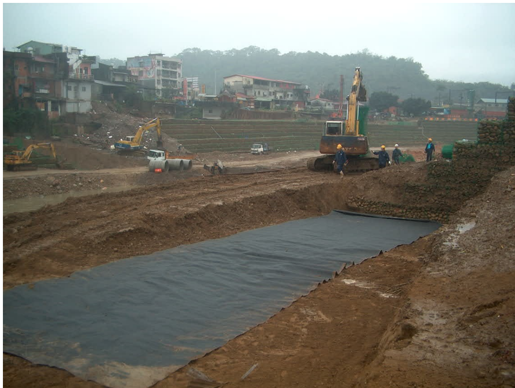
一工區0+300~0+325石籠施作(鋪設透水織布)
