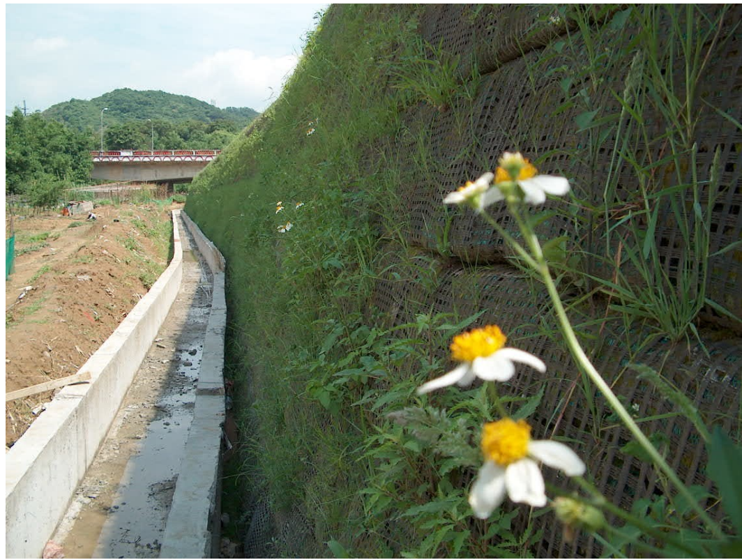
加勁土堤植生完成
