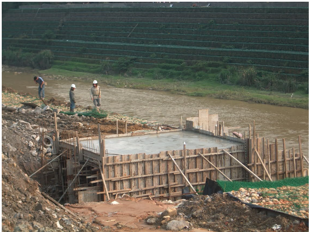
一工區排水箱涵頂版混凝土澆置完成
