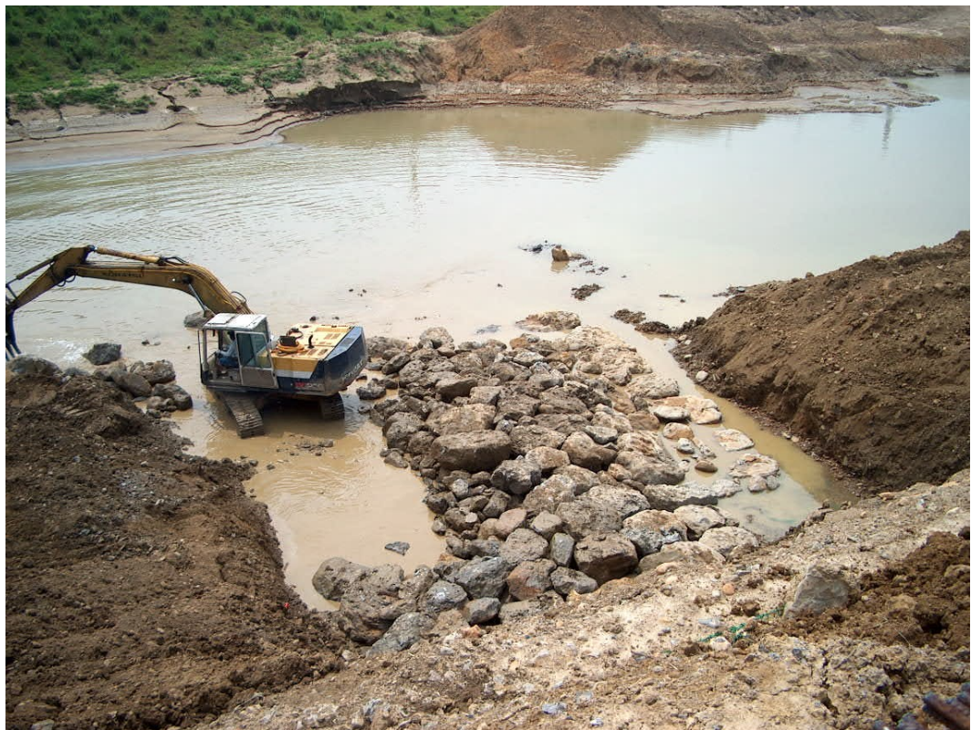
二工區拋石丁堤施作
