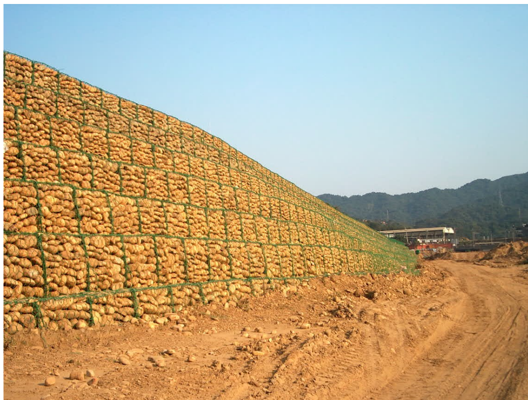
一工區0+700~0+800石籠第八層完成
