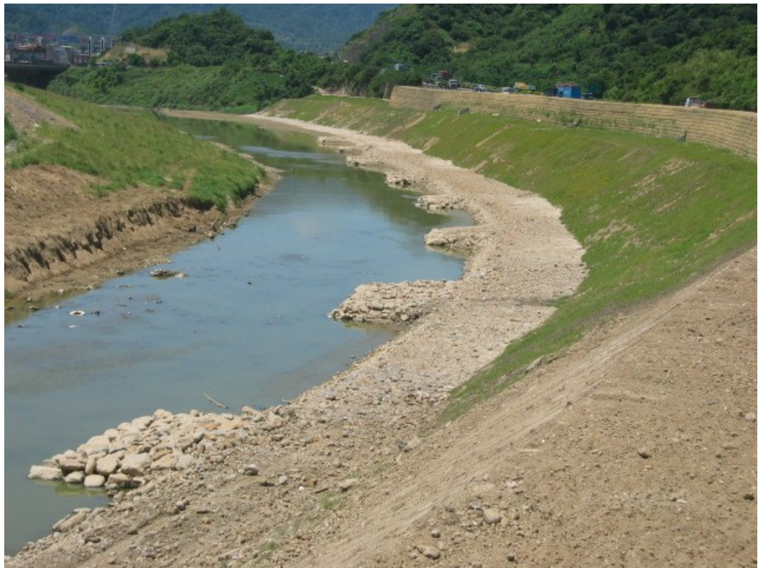
二工區十六座拋石丁堤(@50m)
