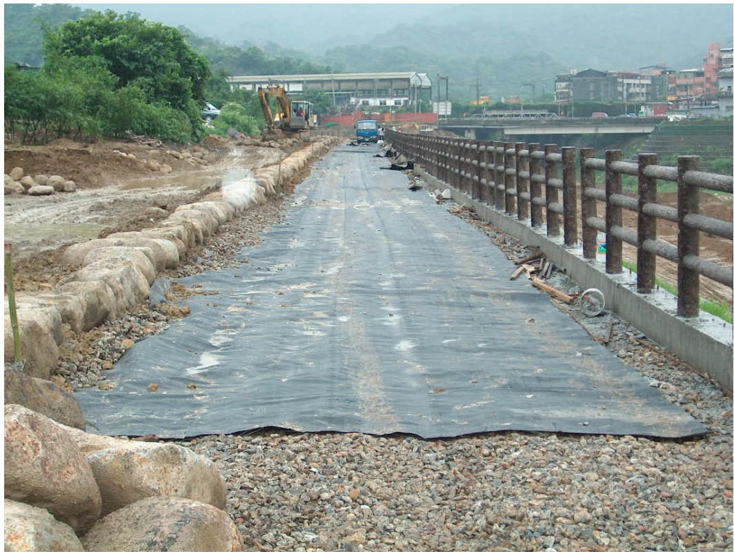
合纖透水織布鋪設
