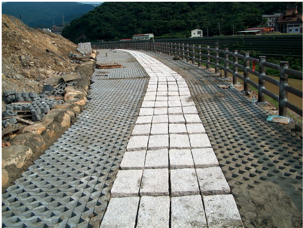
植草磚及石板鋪設
