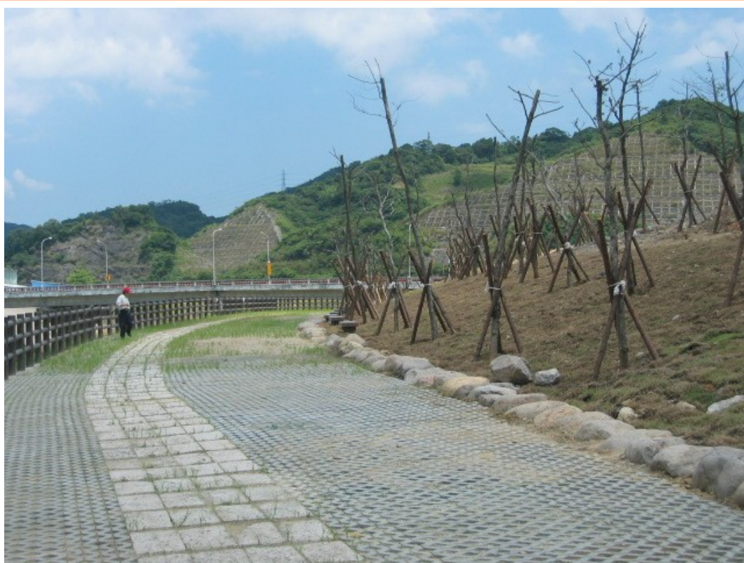
一工區堤頂步道完成
