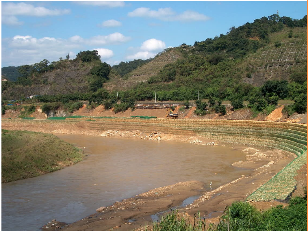
二工區0+000~0+350石籠施作
