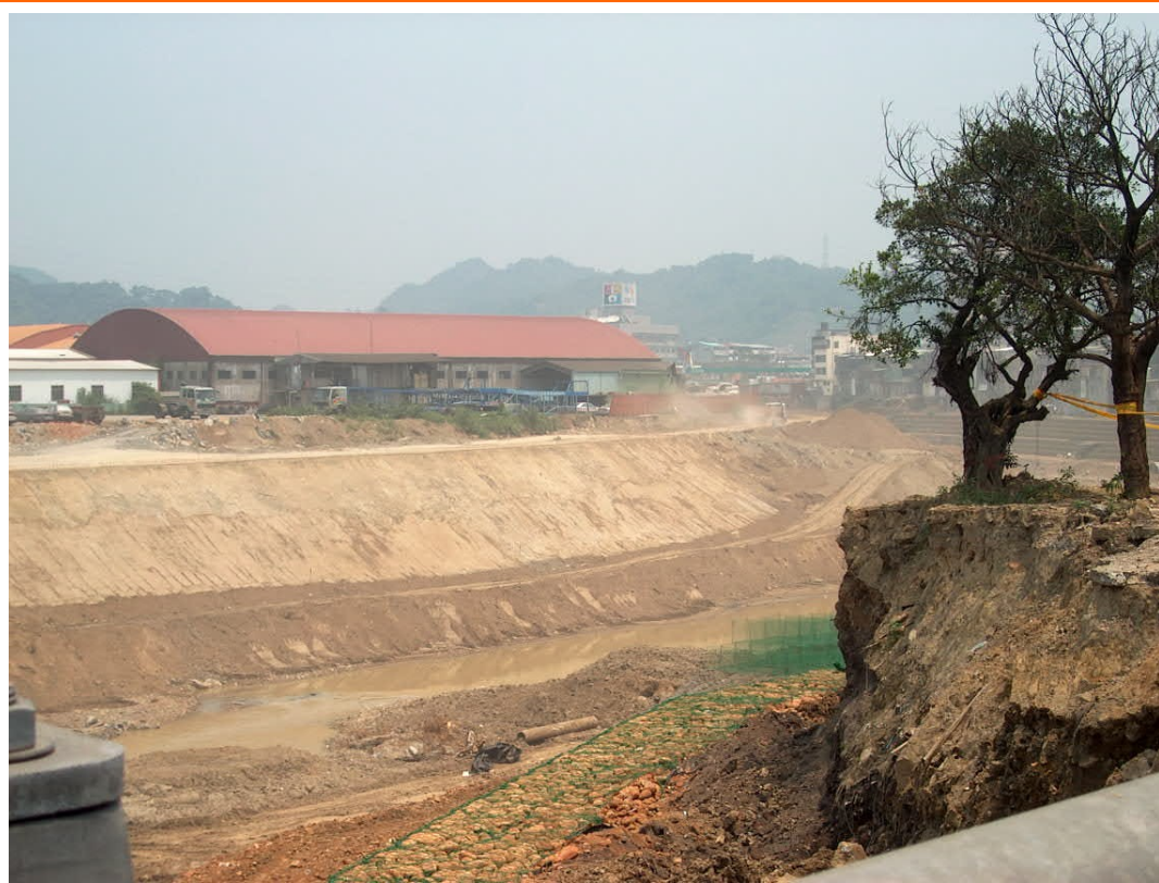
一工區0+500~0+600石籠前坡覆土完成
