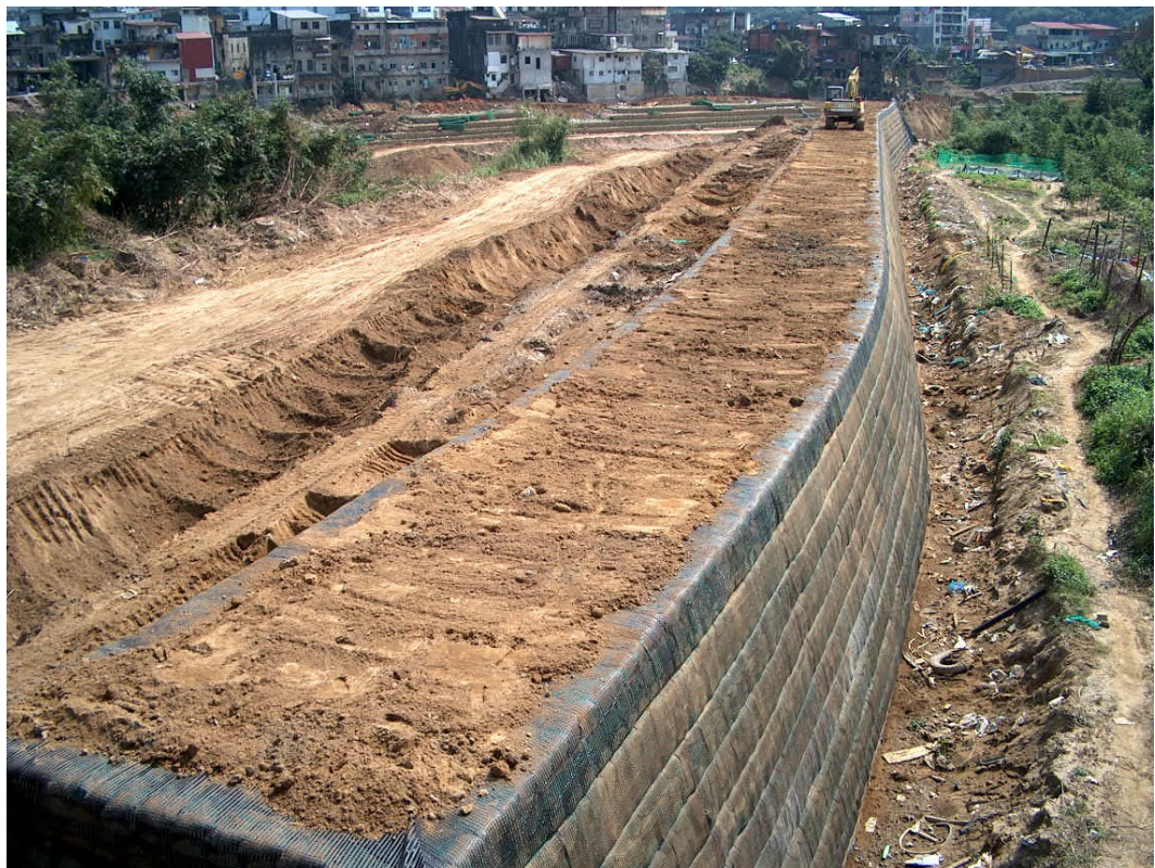
10噸三輪壓路機進行滾壓夯實
