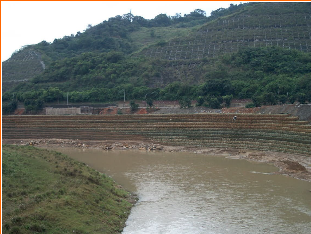
二工區0+200~0+300石籠完成
