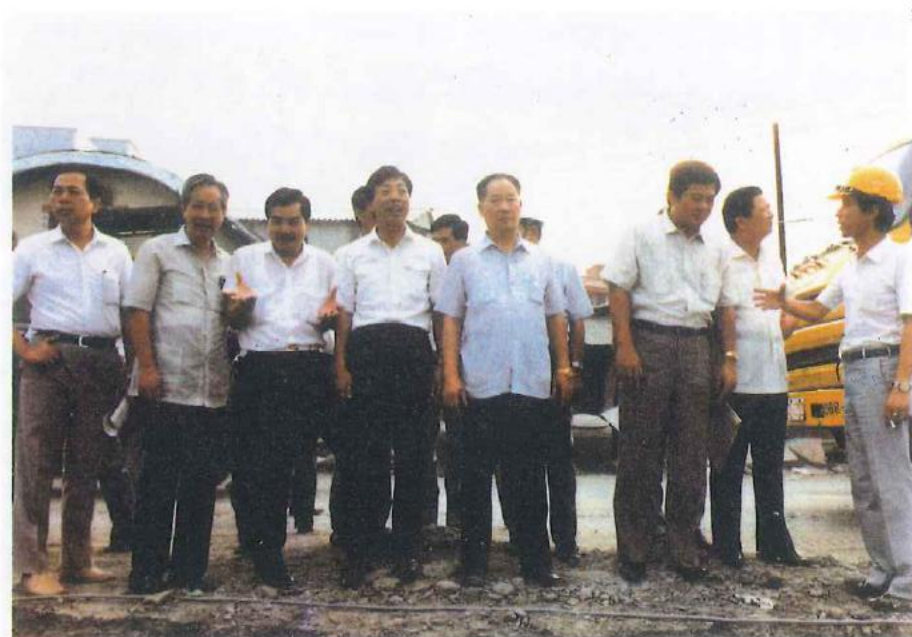
省議會建設小組議員視察本工程
