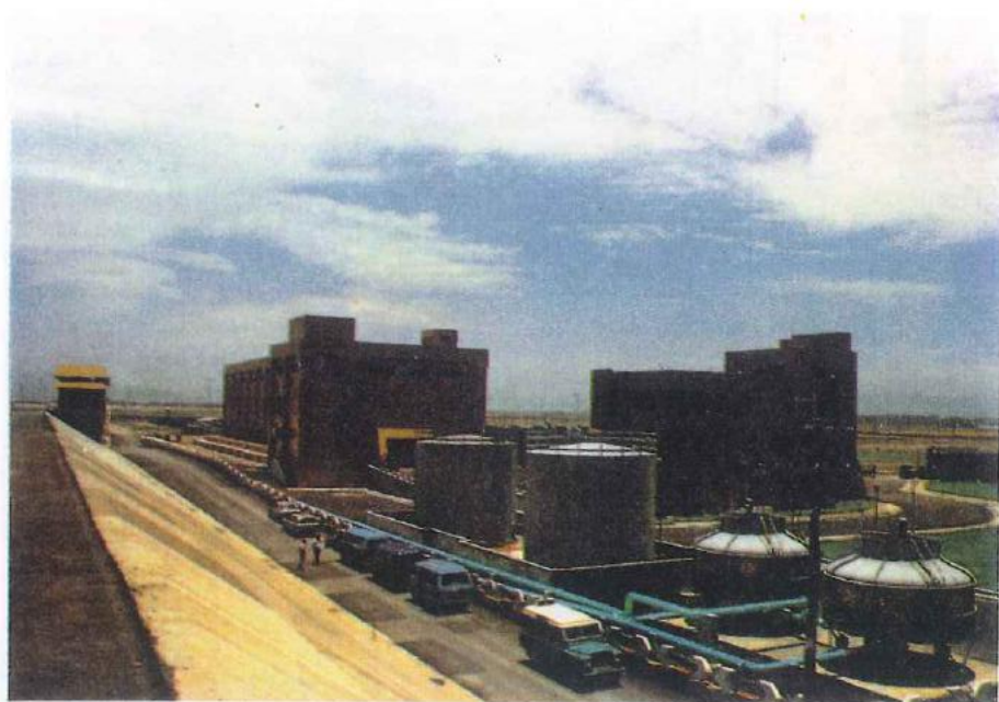
照20 中港抽水站
