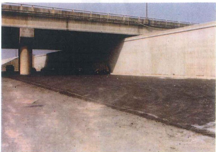
淡水河高速公路橋下堤防改為防洪牆
