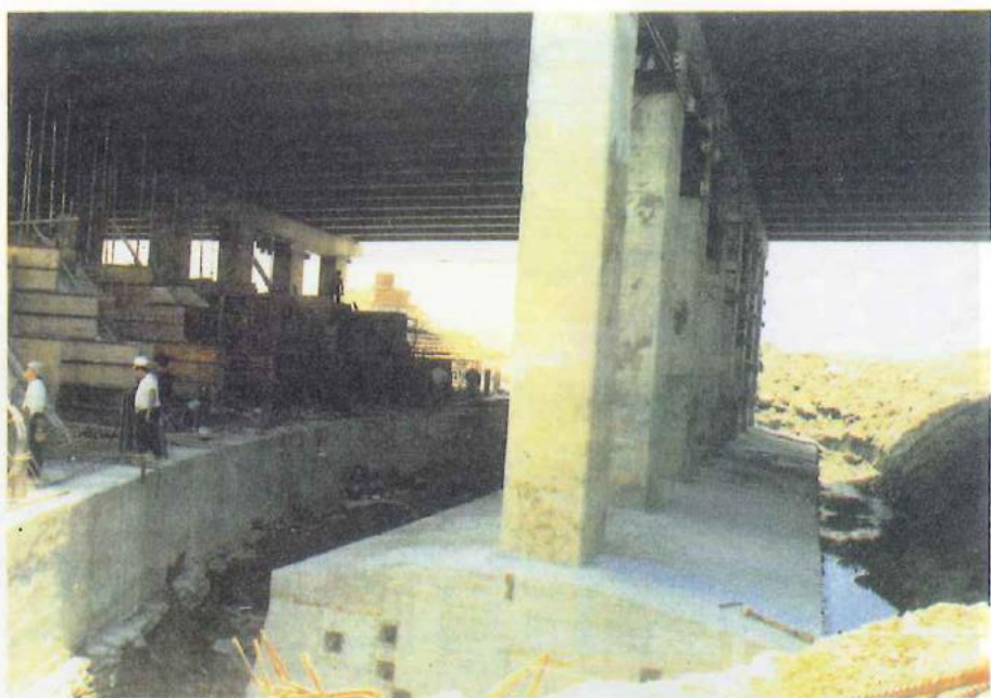
照16 高速公路洩洪橋加固工程(P.5.6.7)
