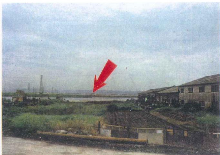
照3 蘆洲堤防蘆洲垃圾堆
