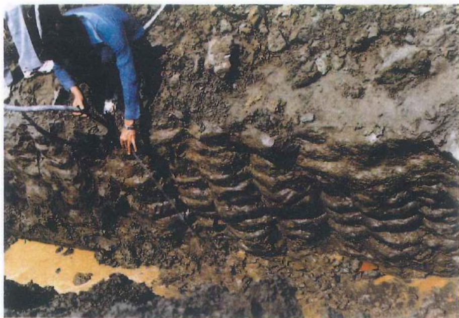
防洪牆前截水牆施工完成開挖檢驗
