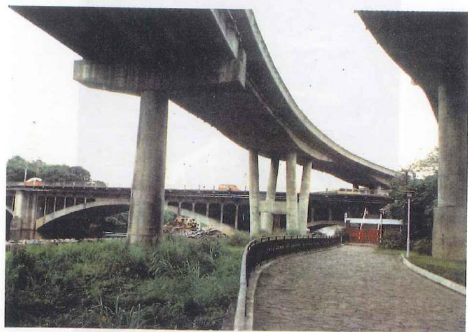
照12 基隆河中山橋上游新生高架橋墩
