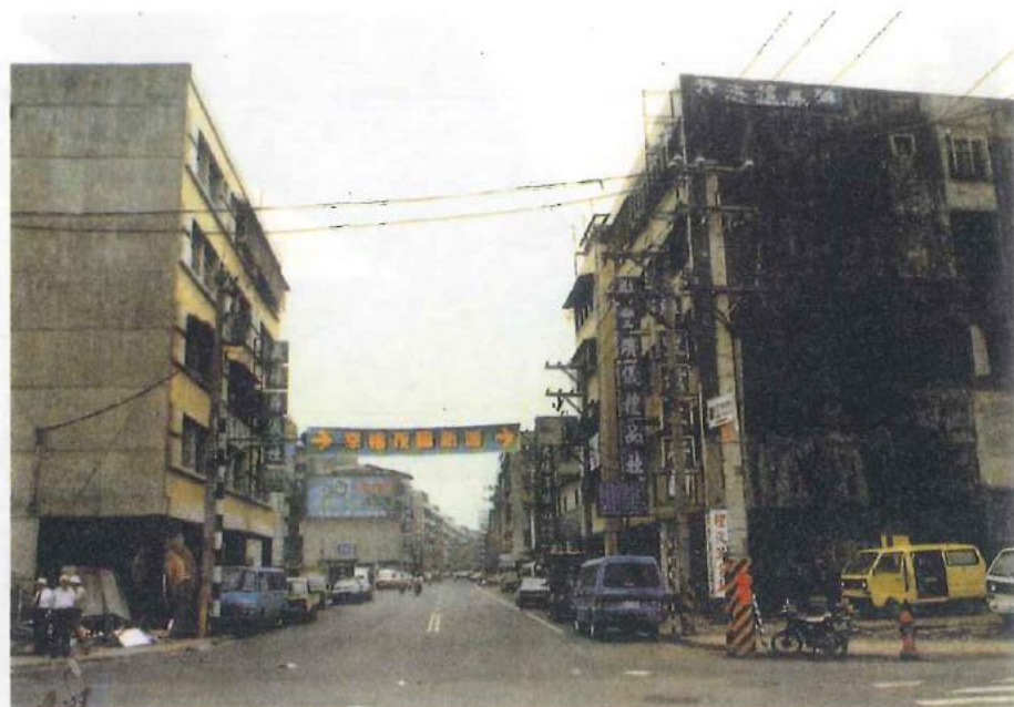
照9 板橋堤防長江路兩側建物
