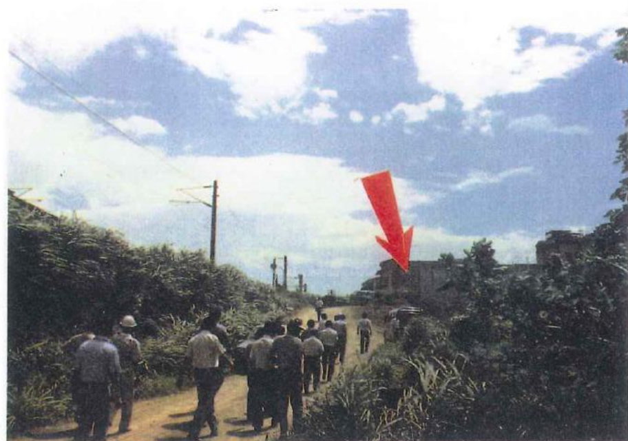
照18 台北市雙園堤防與鐵路橋缺口
