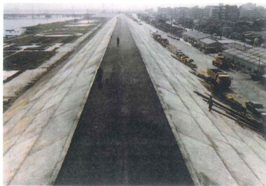
三重堤防完成實景
