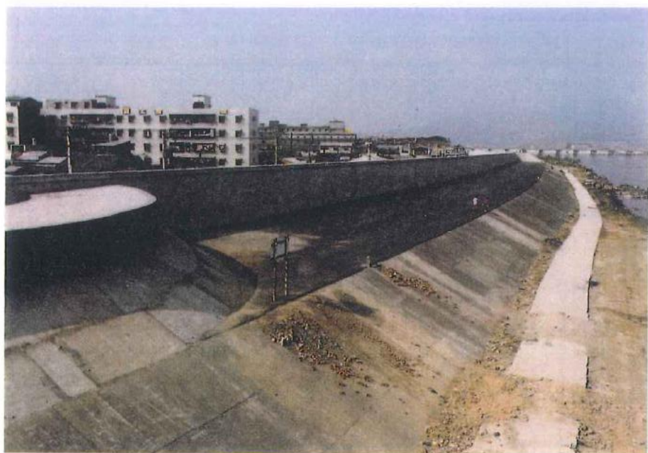
防洪牆(迎水面)完成
