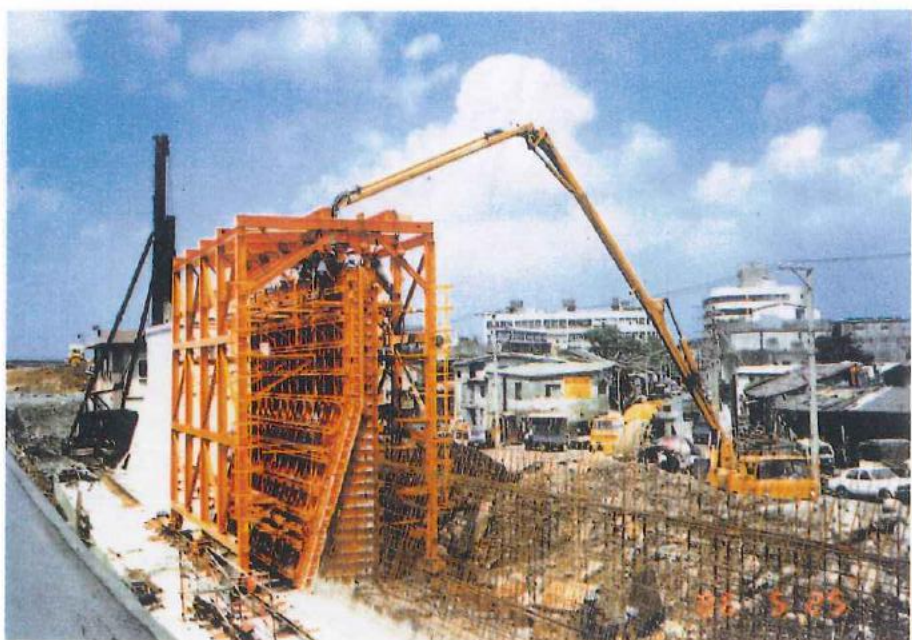
防洪牆施工(面)完成
