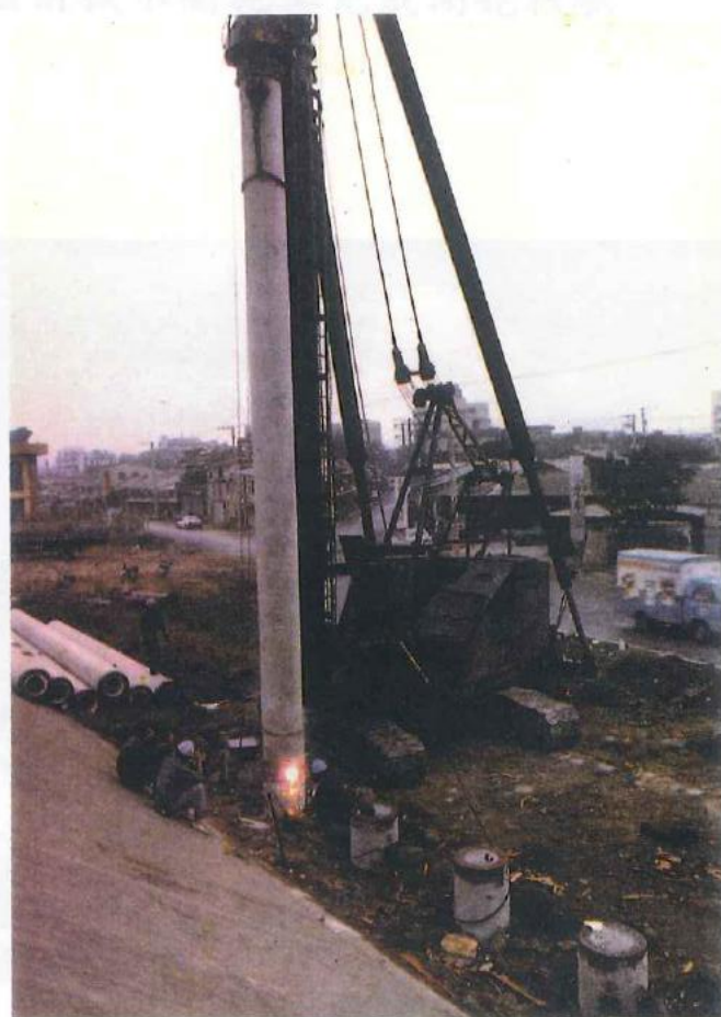
防洪牆基礎打設
