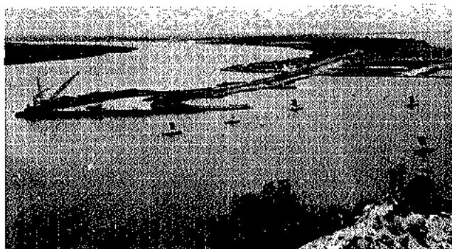
浚渫施工之二
