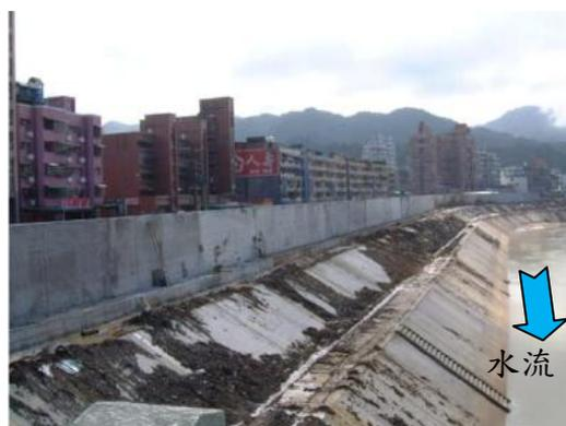
(b) 混凝土護坡及防洪牆施工
