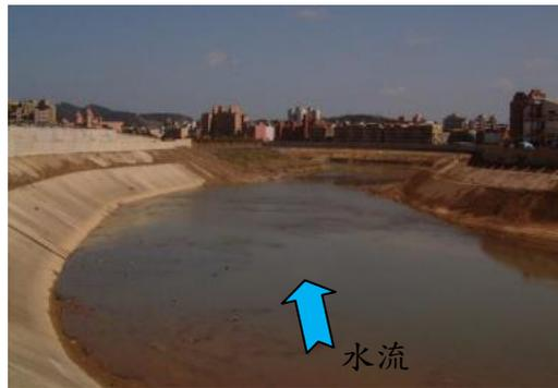
(b) 混凝土護坡及防洪牆施工完成
