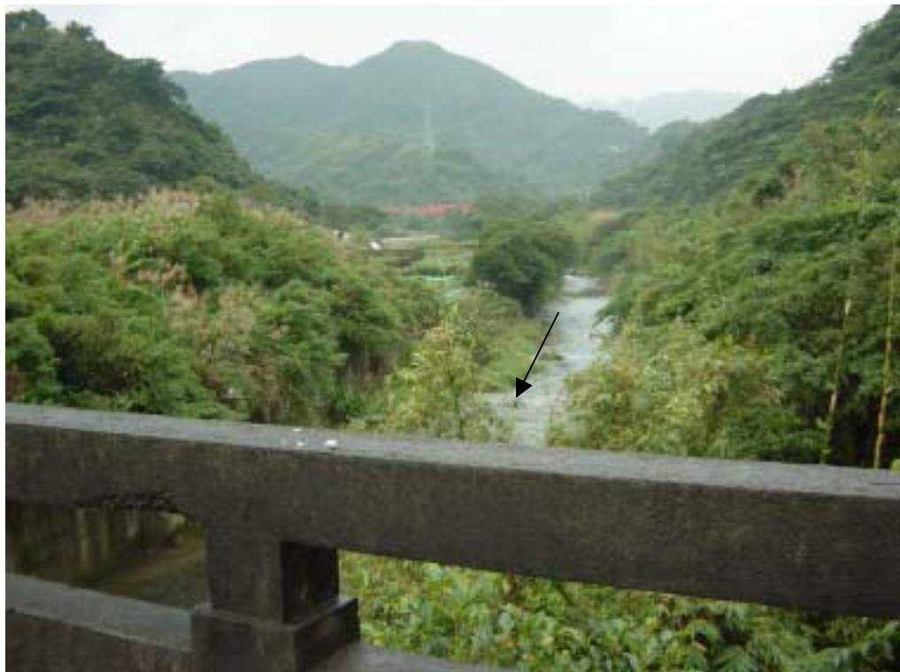
(a) 滯洪池位址
