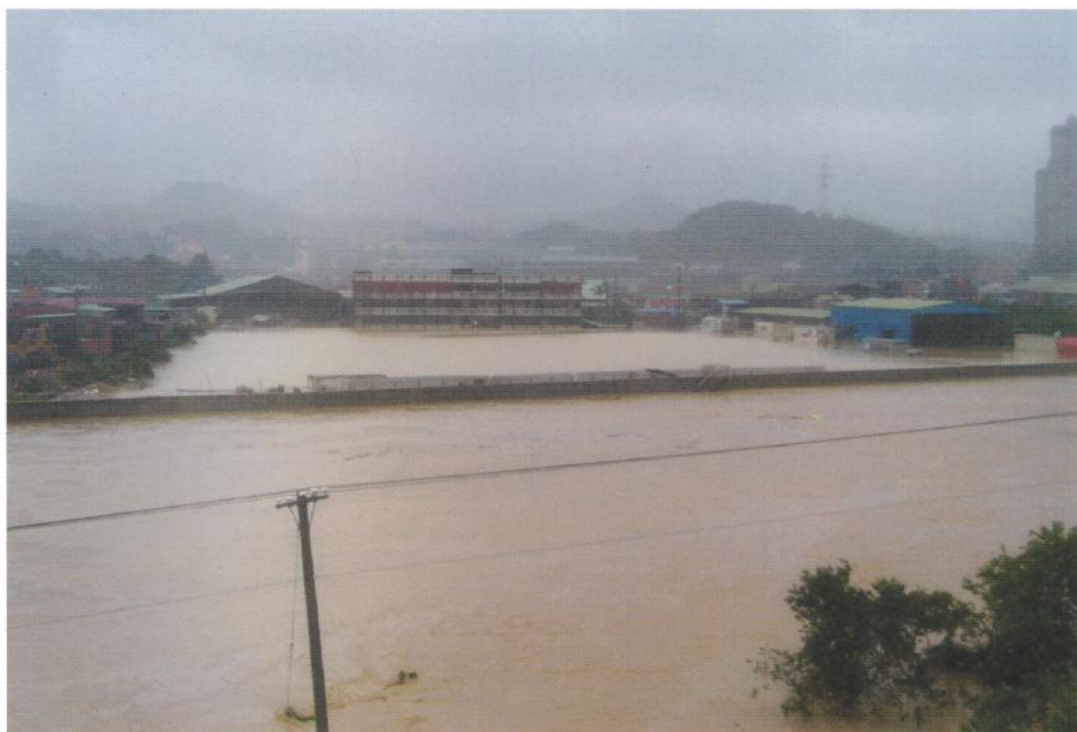
千祥橋上游(堵南工務所)
