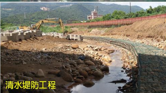
田心堤防防災減災工程
