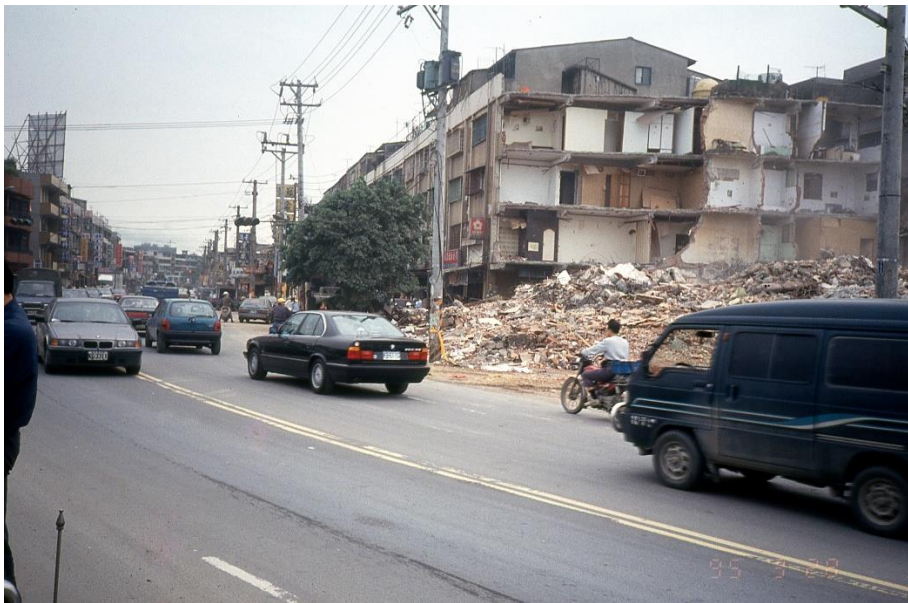
圖說-北洪三期拆遷紀錄 / 圖片來源:第十河川局
