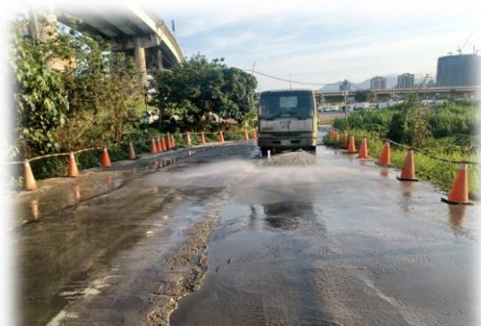
Step3.聯外道路灑水抑 制揚塵及清潔
