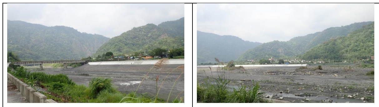
圖 2、新武界橋下游左岸堤段改善工程維管階段現況
