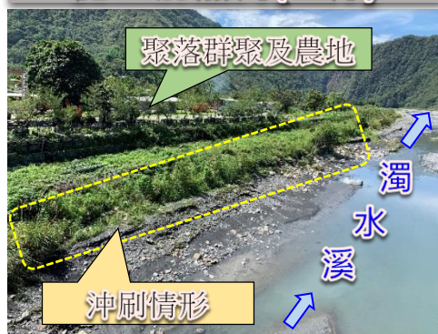
施工前照片(左岸)
