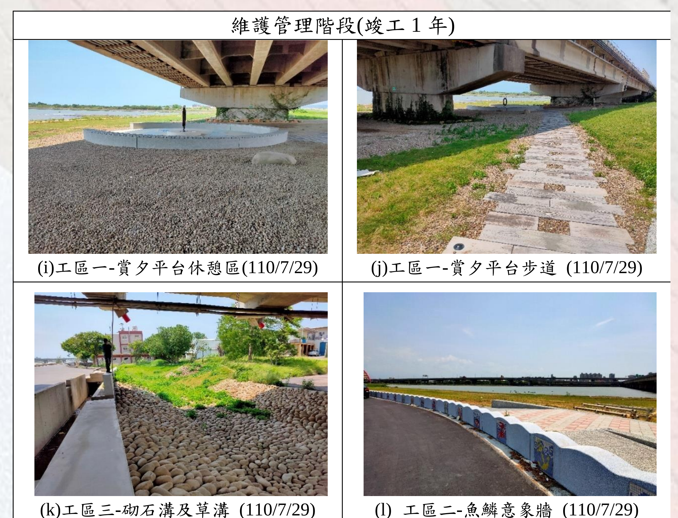
舊港島調節池及環島保護工環境改善工程(一)現況照片
