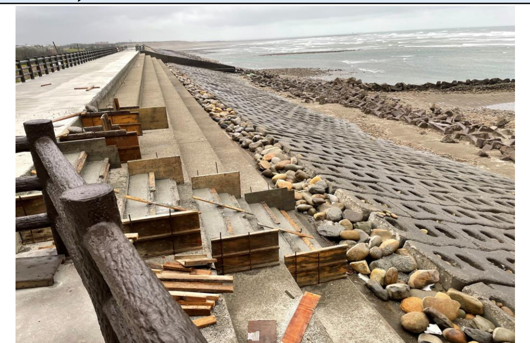
說明：工程於最小影響範圍下施工
