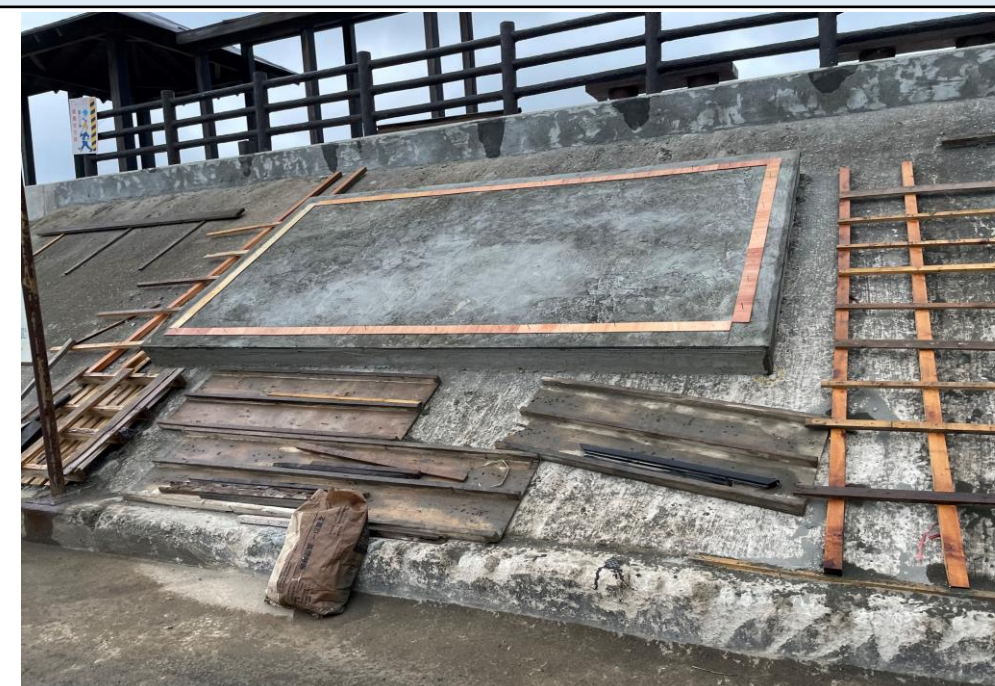
說明：意象牆施工中
