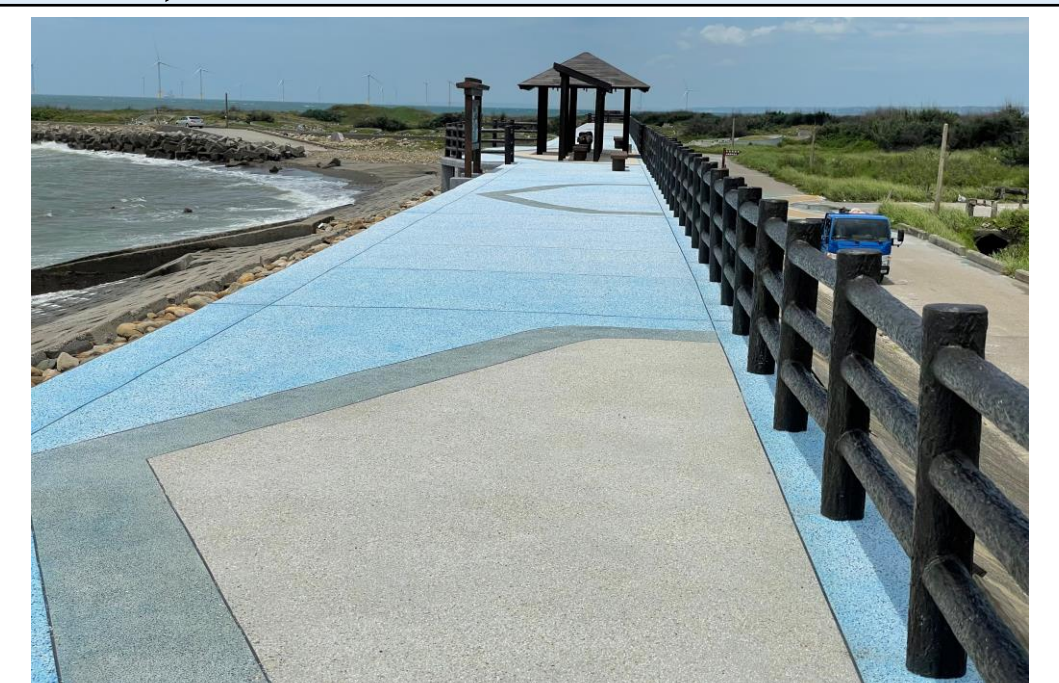
說明：洗石子步道鋪設完成
