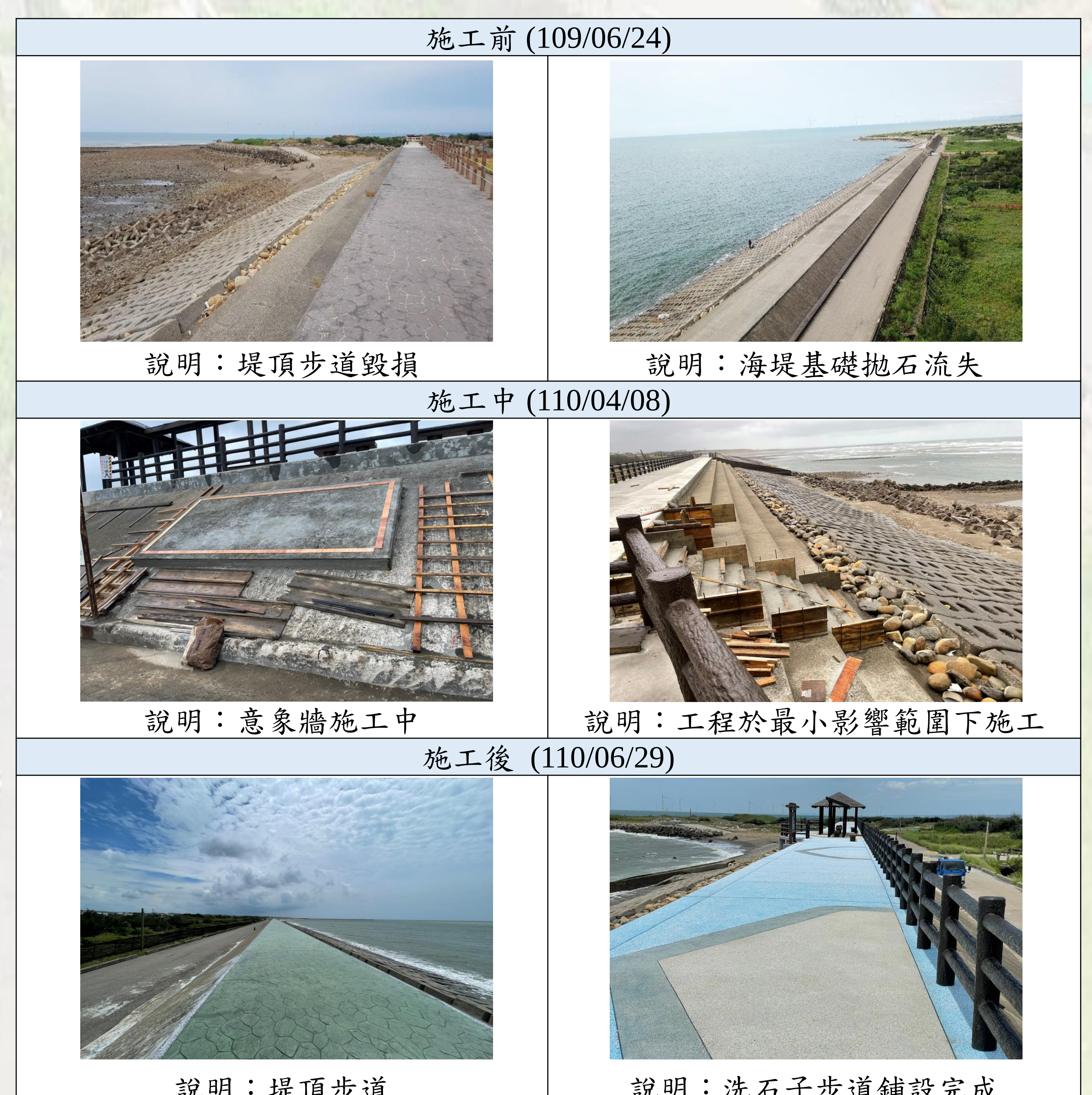
圖3 外埔海堤環境營造改善工程施工紀錄情形
