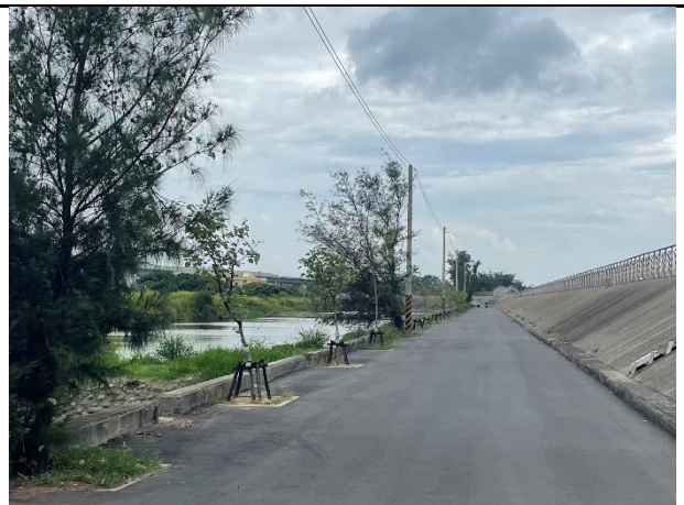
位置或樁號：水防道路 說明：路側木麻黃及植生槽黃槿生長情形
