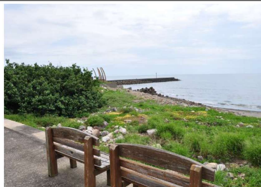
位置或樁號：219134,2715551(圖 D) 日期：109/06/12 說明：海堤外海濱植被
