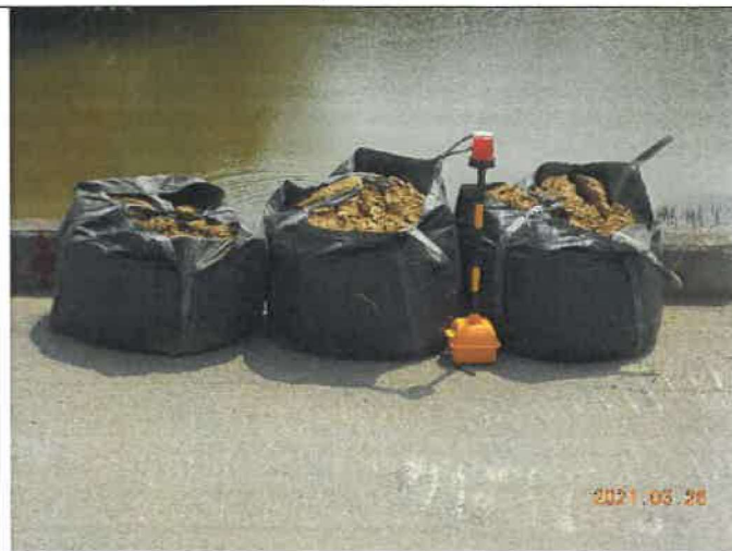
說明：植生區補土採用袋子裝，避免土砂灑落路面 日期：110/03/26
