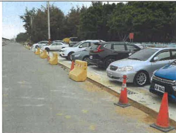
說明：陸側排水溝施作完成 日期：110/05/05
