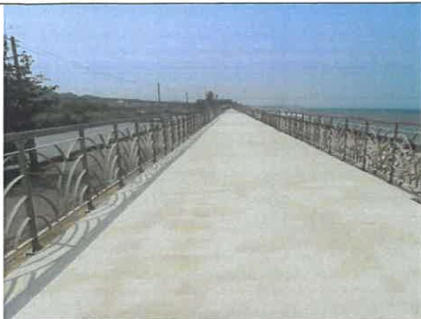
說明：堤頂步道施工鋪設中 日期：110/05/05
