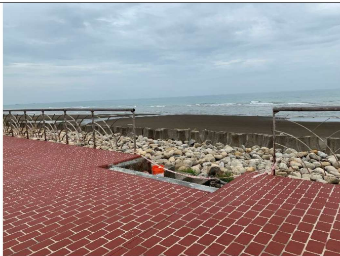
說明：堤頂步道鋪設完成，堤外階梯垂直高度降低，利用 生物行走 日期：110/06/01
