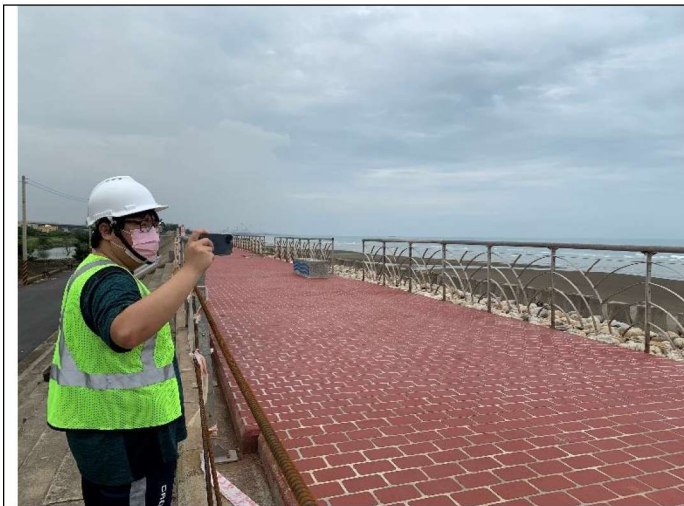
說明：紀錄工程施工過程 日期：110/06/01
