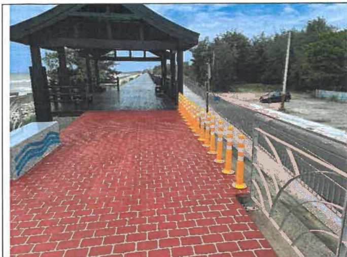
說明：堤頂步道完工 日期：110/06/29
