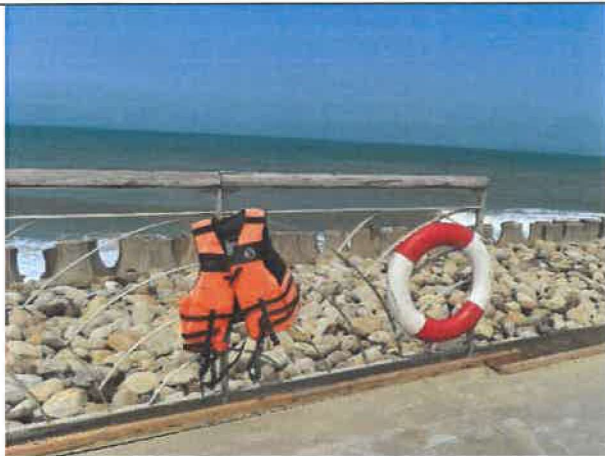
說明：堤外階梯施工 日期：110/05/05
