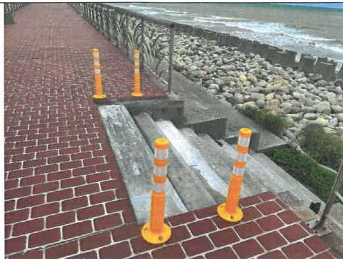
說明：堤外階梯垂直高度降低，利用生物行走 日期：110/06/29
