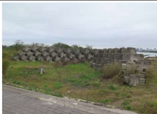
位置或樁號：245130, 2748420 日期：(109/01/17) 說明：島頭消波塊堆置區
