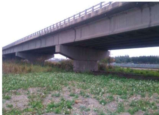
位置或樁號：竹港大橋 日期：(109/01/17) 說明：竹港大橋環境現況
