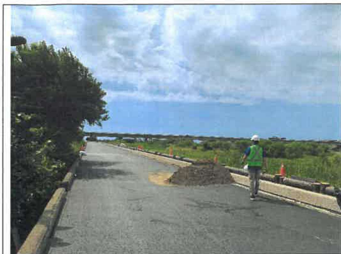
說明：施工材料堆置車道上 日期：110/7/14
