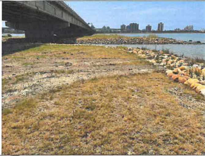
說明：舊港島賞夕平台若是二期工程影響，請復原。 日期：110/9/14
