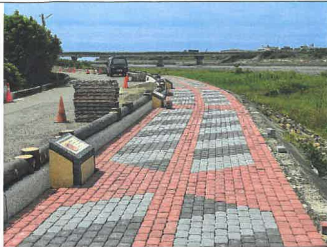
說明：施工材料堆置車道上 日期：110/06/09
