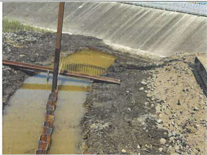
說明：利用鋼板樁穩固構造物 日期：110/04/16
