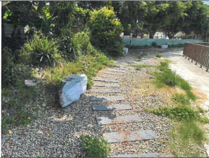
說明：滯洪池步道景觀施工完畢 日期：110/9/14
