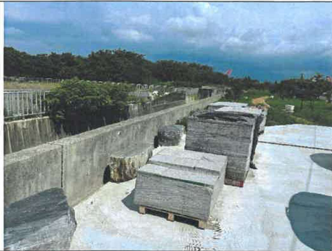
說明：滯洪池步道景觀施工中 日期：110/06/09
