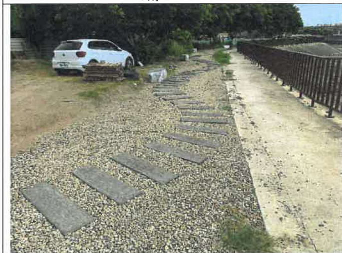
說明：滯洪池步道景觀施工中 日期：110/7/14
