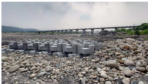
施工預定地現況
