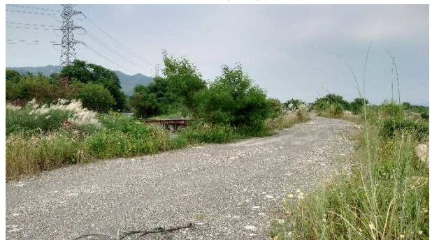
施工便道現況
