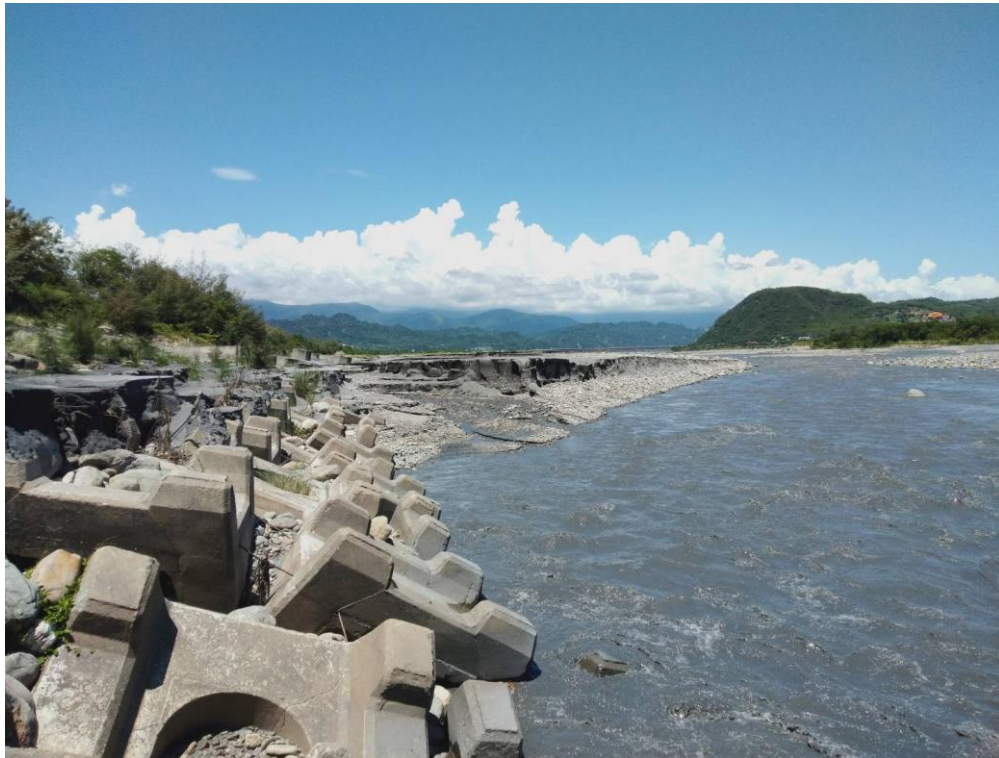
圖 8-2 卑南溪臺東大堤堤前坡環境現況
