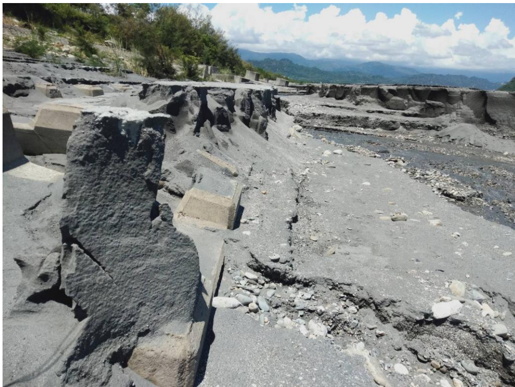
圖 8-4 卑南溪臺東大堤堤前坡現況
