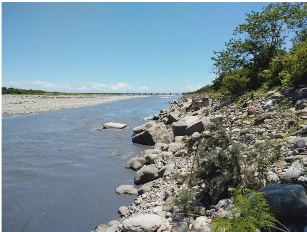
圖 8-3 卑南溪臺東大堤堤前坡現況
