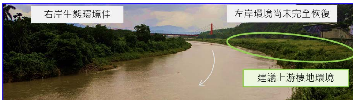
圖 4-8 計畫區上游灘地現況(110/08)
