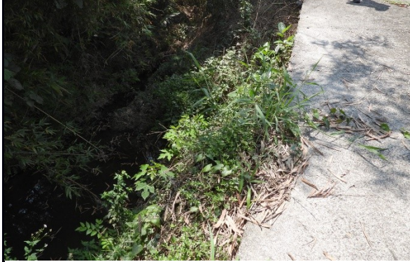
上圖：預計設置護坡位置旁的小溪溝（照片左方）。
