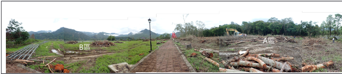
圖 4. 整地後工區全景（拍攝日期 109.05.27）
