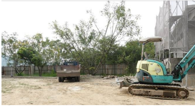
新建公廁旁之大樹皆全數保留(109.09.25)
