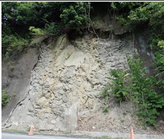
圖 1. #4 工區環境為崩塌地。
