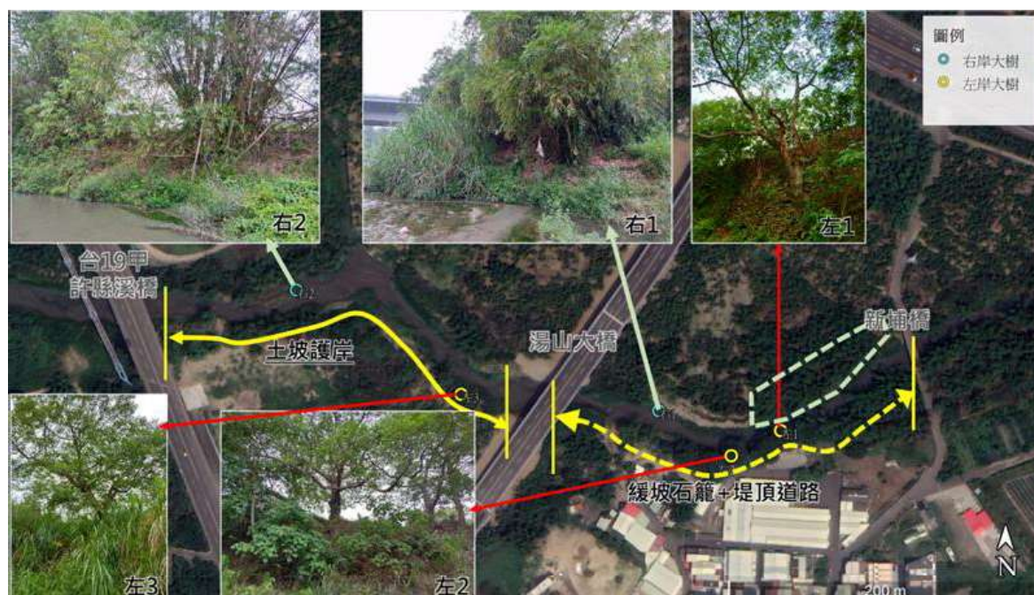
圖 4-47 鹽水溪許縣溪橋至新埔橋堤段防災減災工程大樹位置
