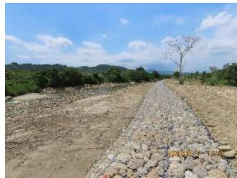
C 工區採通透性高的石籠護岸設計
