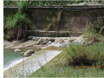
E 工區既有護岸淘刷處以混凝土及砌石修補情形
