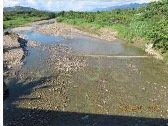
D 工區固床工下游排設混凝土塊防止下刷，且填充河床料無落差
