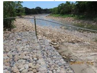
C 工區堤頭堤尾緩坡化塊石護坡
