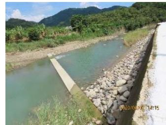
A 工區因配合陳情地主，將原新設護岸變更設計為既有護岸加高，完工後於既有護岸基腳堆置塊石保護，未干擾水域淺灘及深潭等多樣棲地型態
