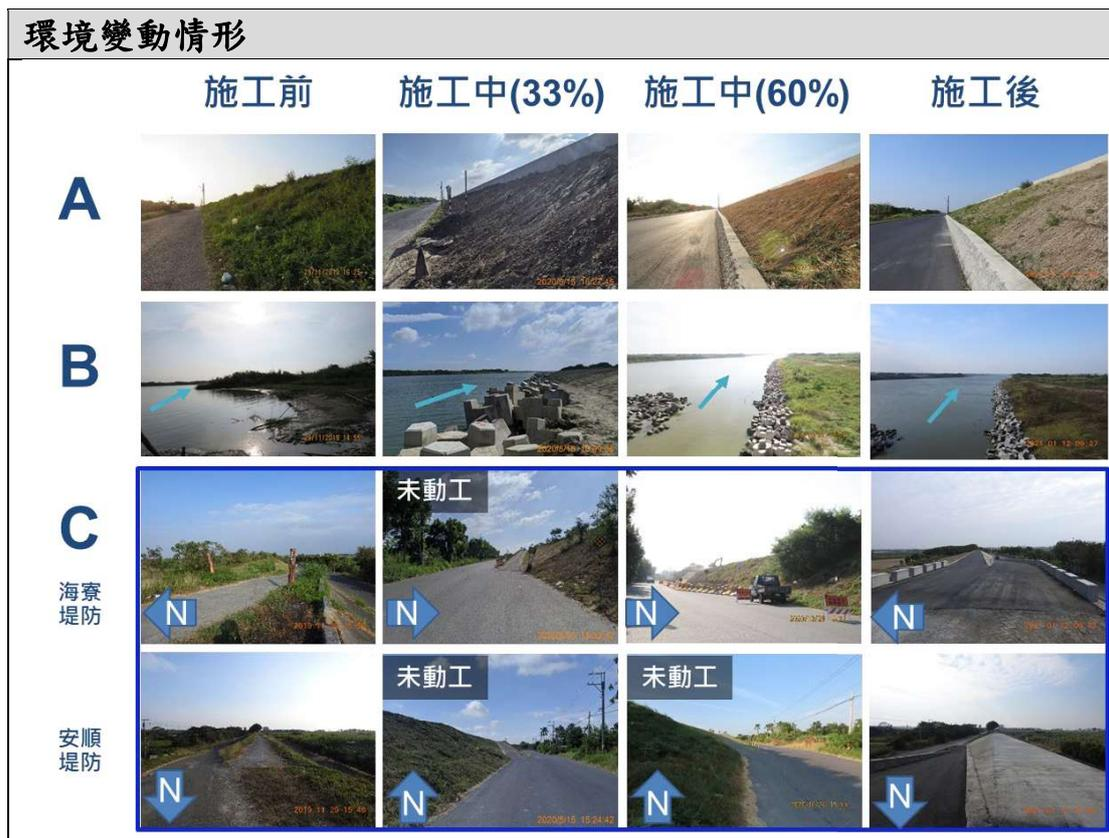
本團隊於 109/3/1 行經 B 工區，發現原掏空處經由工程手段填補為順直河岸，已改變原來的內凹地貌(圖 5-25 左)。第一次施工中(施工進度約 32%)複勘於 109/5/15 辦理，與監造工務所承辦及施工廠商進行會勘，確認工區棲地品質、生態保全對象及生態保育措施執行情形。B 工區業已完工，現場為空曠裸露地，工區範圍外濱岸植被則未擾動；施工廠商於 A 工區已加高混凝土坡面工，正進行使用竹掃帚於表面製造粗糙面；C 工區的越堤路改善則尚未施作。本團隊於 109/7/3 進行施工中夜間勘查，發現兇狠圓軸蟹主要在城西保安林區一帶，穿越防汛道路後攀爬過青草崙堤防降海產卵(圖 5-25 右)，直至第一示範公墓納骨塔仍有發現兇狠圓軸蟹出沒，距河口約 5 公里。
