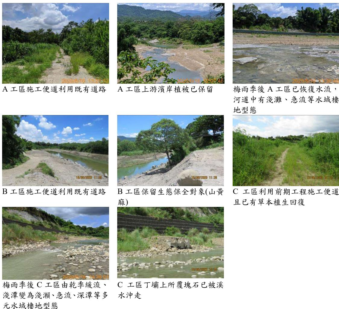
圖 5-49 後堀溪玉井大橋上游芒子芒段護岸改善工程施工後生態保育措施執行狀況
