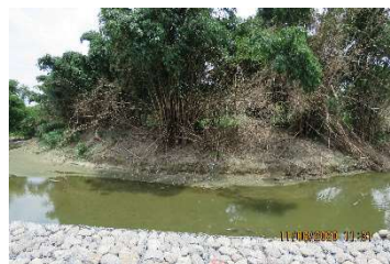
B 工區施作未擾動右岸竹林，圖中竹林為地主自行進行疏伐
