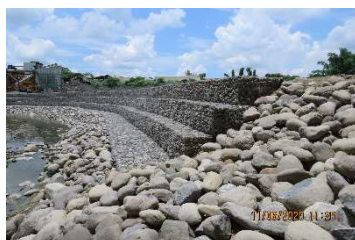
B 工區堤頭堤尾緩坡化塊石護坡
