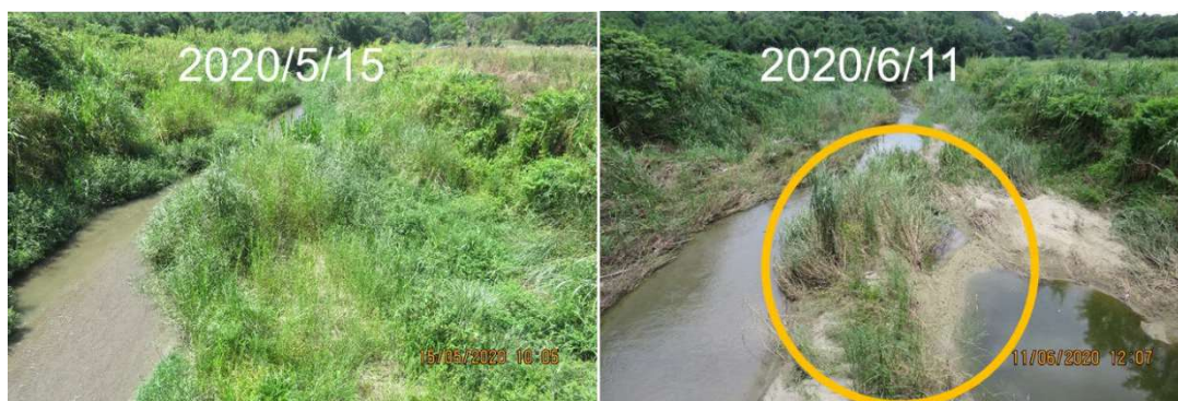
圖 5-64 那拔林溪千鳥橋下游左岸護岸工程梅雨季前(左圖)後(右圖) C、D 工區河道內植被情況
