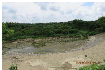
A 工區採通透性高的石籠護岸設計
