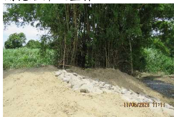
B 工區左岸已保留工程施作範圍外之樹島
