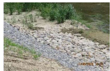
A 工區堤頭堤尾緩坡化塊石護坡
