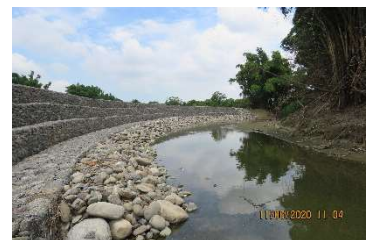
B 工區採通透性高的石籠護岸設計
