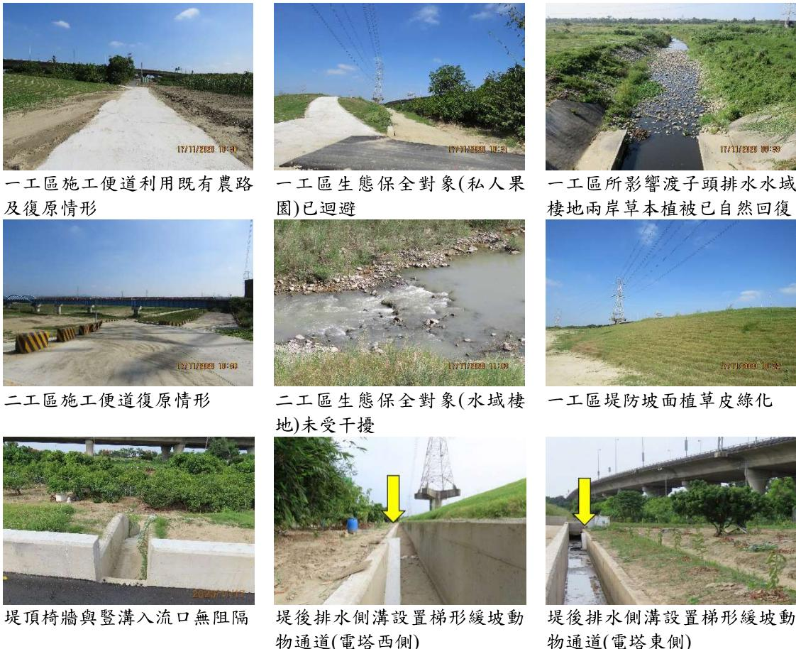
圖 5-13 曾文溪新中堤防防災減災工程併辦土石標售施工後生態保育措施執行狀況
