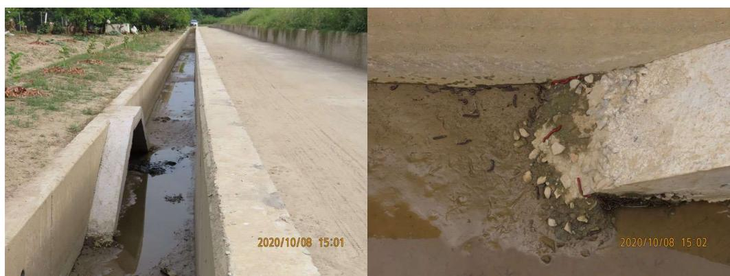
圖 5-12 曾文溪新中堤防防災減災工程併辦土石標售一工區堤後排水側溝動物通道設置情形
