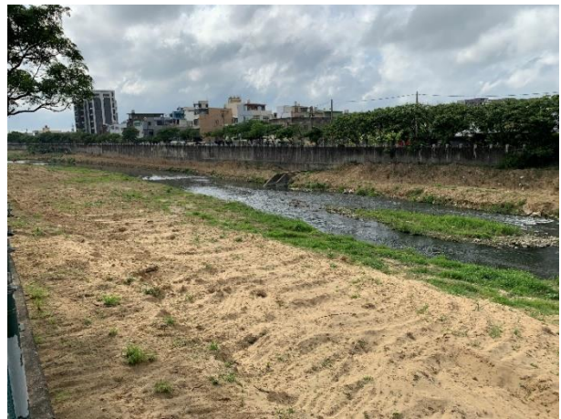
位置或樁號： 日期：110/5/18 說明：堤防內多裸露地。
