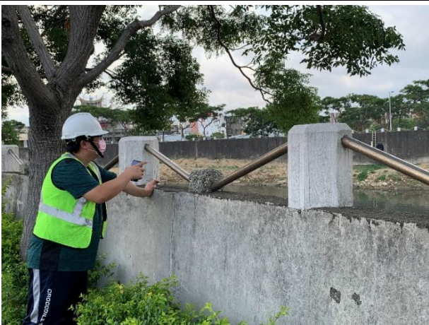
位置或樁號： 日期：110/5/18 說明：觀察河堤型式及河床裸露狀況。
