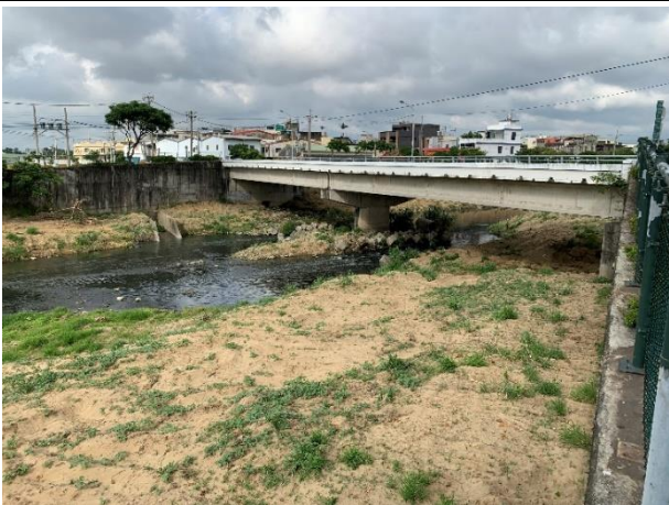
位置或樁號： 日期：110/5/18 說明：客雅溪福樹橋周遭河床。
