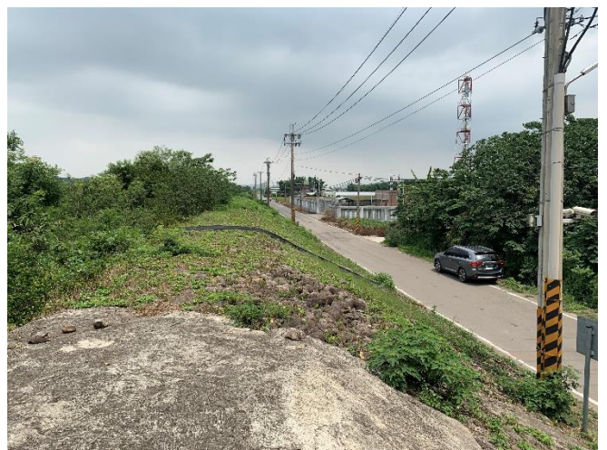
位置或樁號： 日期：110 年 5 月 18 日 說明：芎林堤防
