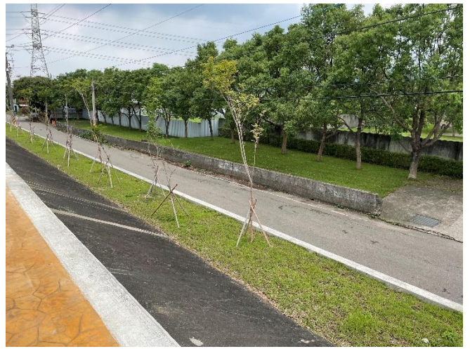
位置或樁號： 日期：110 年 5 月 18 日 說明：山豬湖堤防水防道路兩側行道樹
