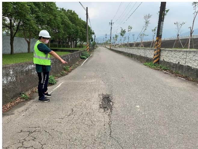
位置或樁號： 日期：110 年 5 月 18 日 說明：山豬湖堤防水防道路生態檢核
