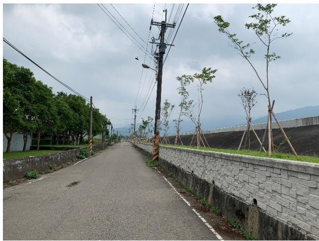
位置或樁號： 日期：110 年 5 月 18 日 說明：山豬湖堤防水防道路行道樹
