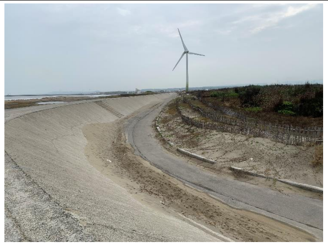
位置或樁號： 日期：110/11/3 說明：堤坡為水泥平滑面
