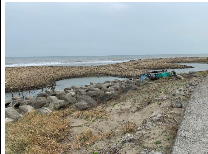
位置或樁號： 日期：110/11/3 說明：部分海岸有濱海植物覆蓋
