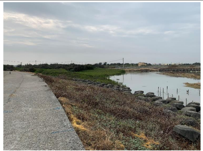
位置或樁號： 日期：110/11/3 說明：房裡海堤堤頂步道不遠處即有水域棲地
