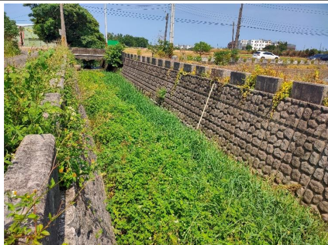
位置或樁號：121.0816，24.9073 日期：110/7/29 說明：德盛溪內多水生植物
