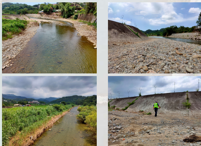
圖3 大坪溪南埔三號堤防改善工程現況情形
