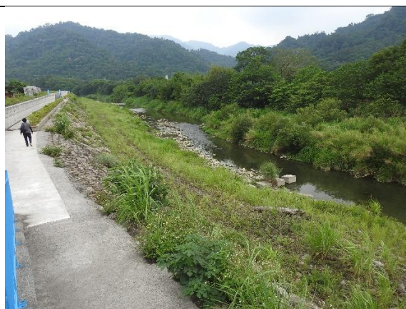
110.05.10 右岸工區現況
