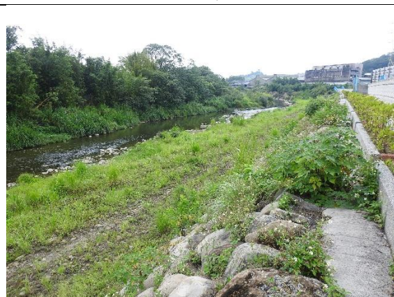
110.05.10 右岸工區現況
