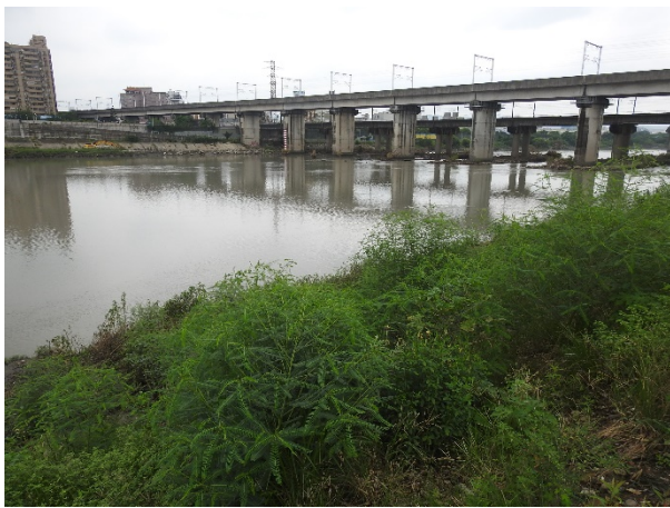
完工後工程範圍-110 年 8 月 3 日
