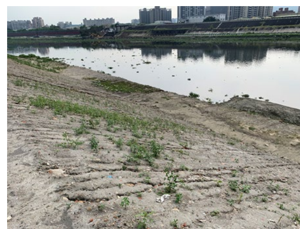
完工後工程範圍-110 年 5 月 4 日
