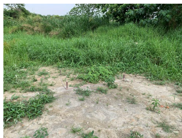
完工後工程範圍-110 年 5 月 4 日
