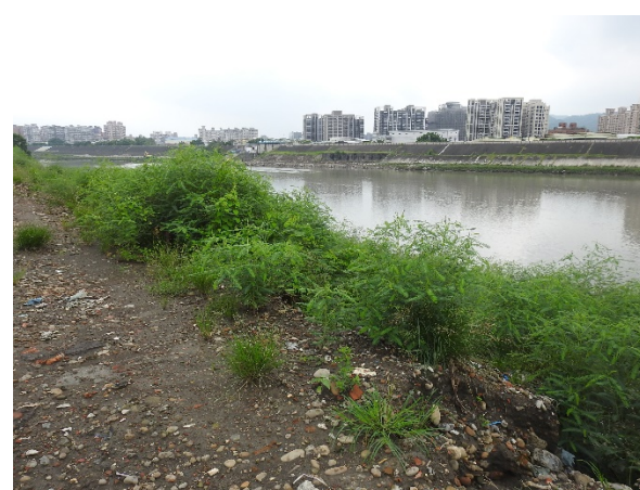
完工後工程範圍-110 年 8 月 3 日
