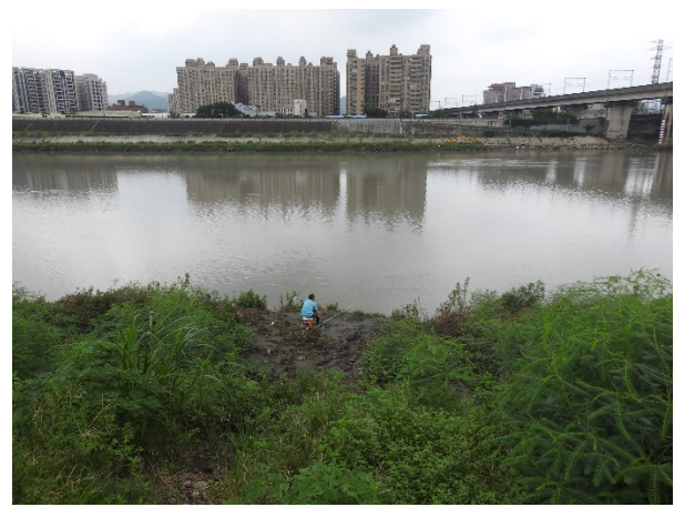
完工後工程範圍-110 年 8 月 3 日
