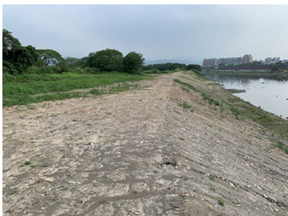
完工後工程範圍-110 年 5 月 4 日
