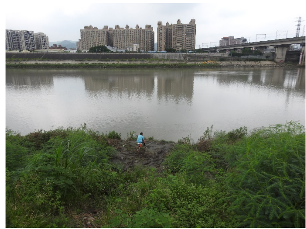
完工後工程範圍-110 年 8 月 3 日
