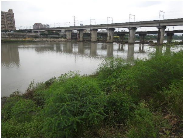
完工後工程範圍-110 年 8 月 3 日
