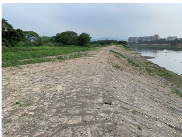
完工後工程範圍-110 年 5 月 4 日
