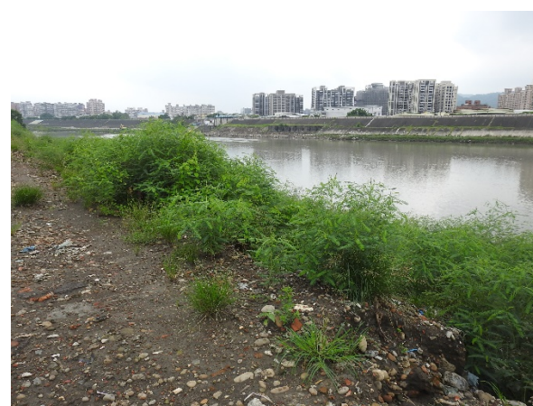
完工後工程範圍-110 年 8 月 3 日
